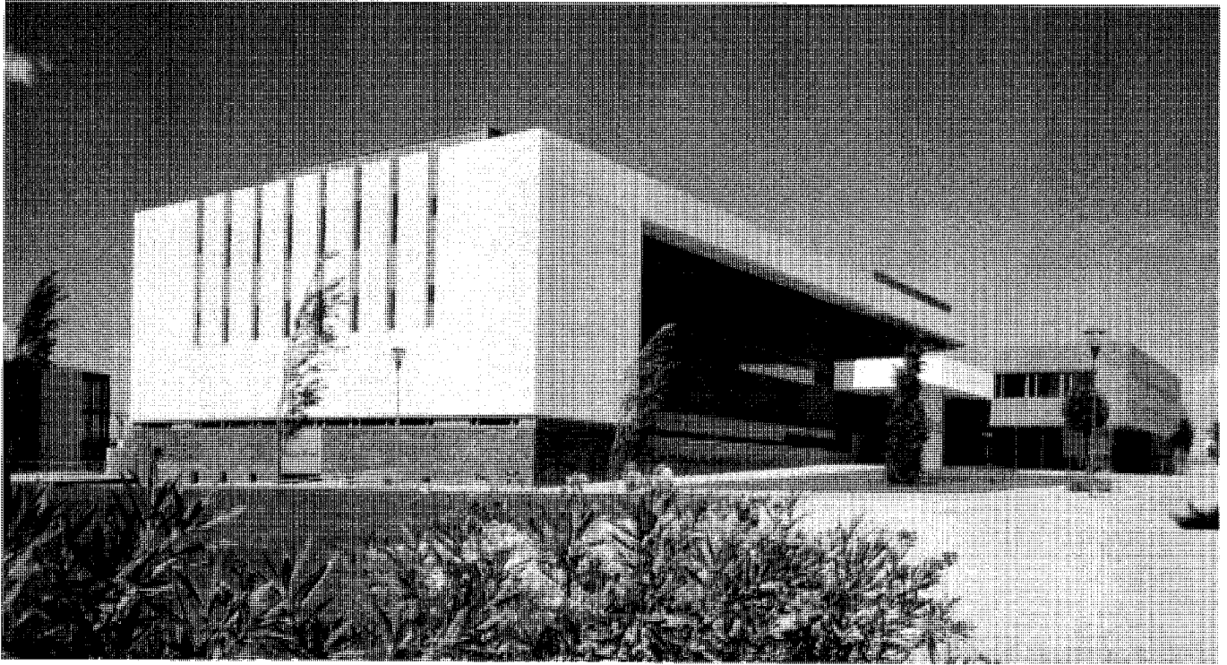
Vista de conjunto. Fotografía del autor.
