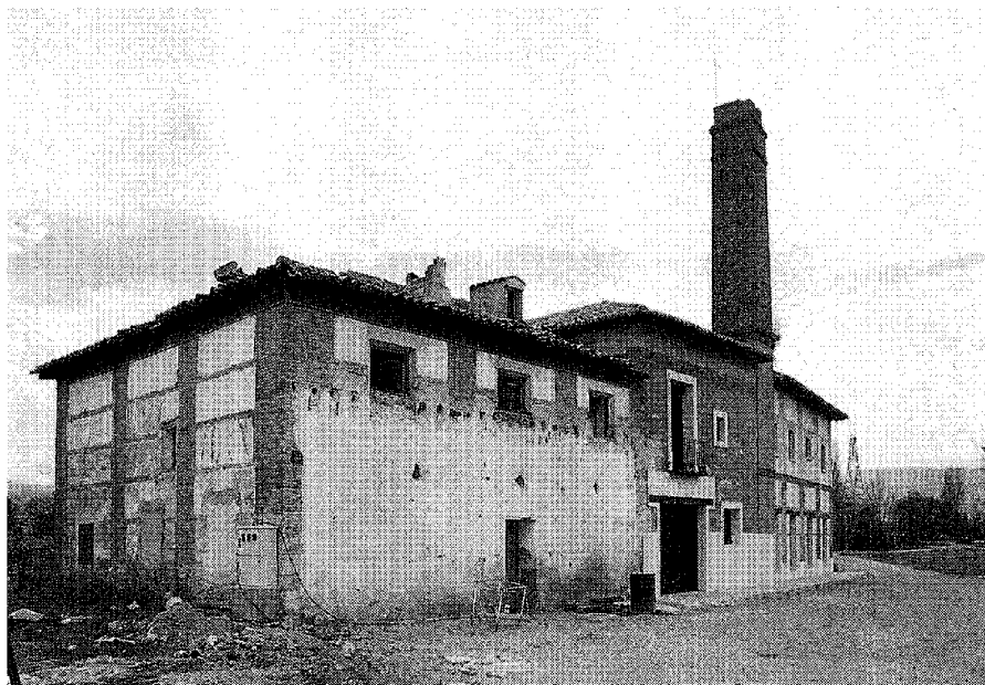
Molino. Fachada principal tras la rehabilitación.
