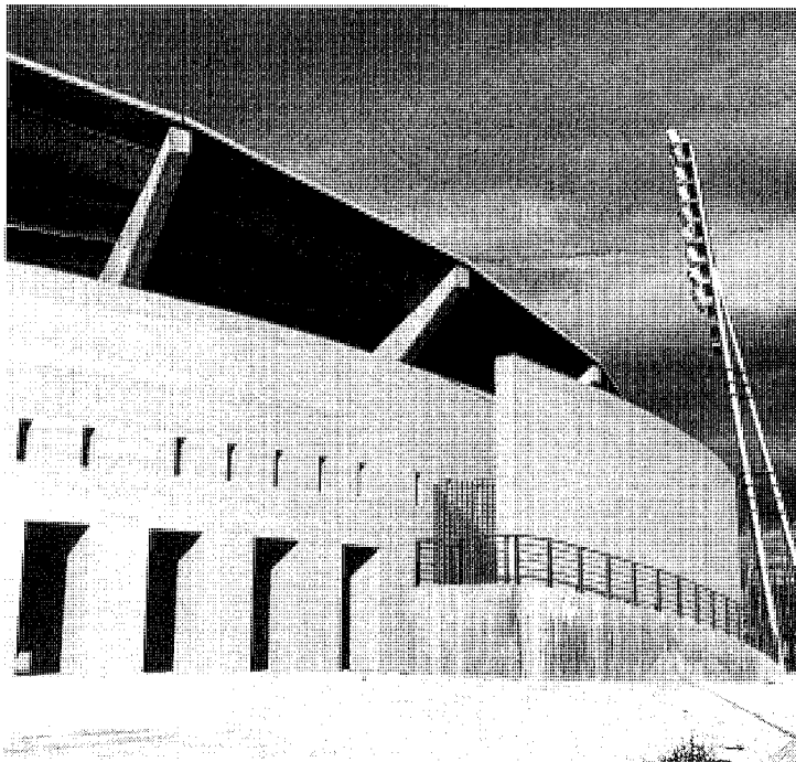
Rampa de acceso. Foto del autor.
