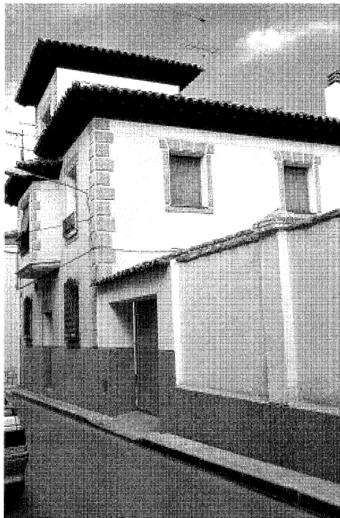
Vivienda en calle Colmenares, 3.
