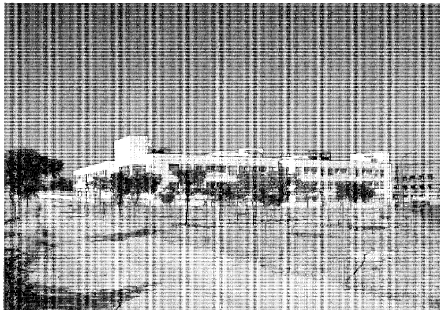
Vista general del edificio. Jose Ablanedo, 2000
