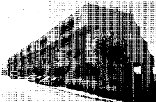
Barrio de Santa Elena. Calle de acceso.
