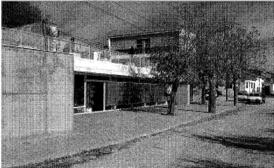
Centro Cultural. Fachada a C/ de la Fuente. Foto José Ablanedo.
