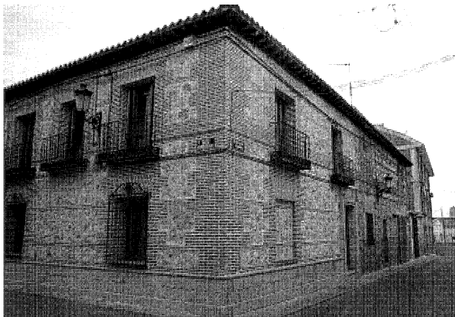
Vivienda del siglo XVIII en Pza. de la Constitución, c/v a C/ Escalinata de la Iglesia, 6 y 7, conocida como "casa Escobar". Foto José Ablanedo.
