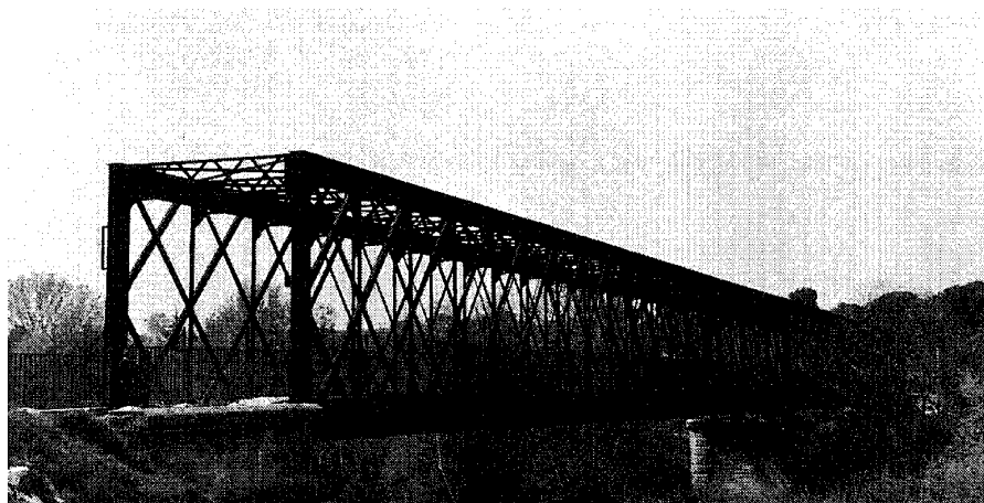
Vista aguas abajo. Foto Pilar Martín-Serrano.
