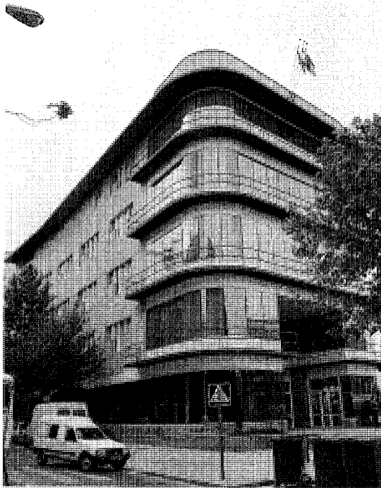
Fachada a la calle Canarias. Foto José Ablanedo.
