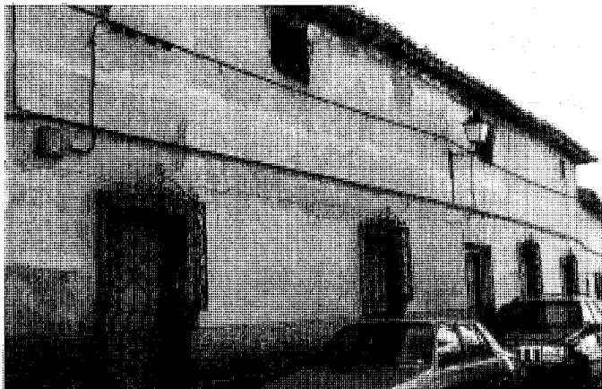
Vivienda en C/ Madrid, 12, 14 y 16. Foto Pilar Lorenzo.
