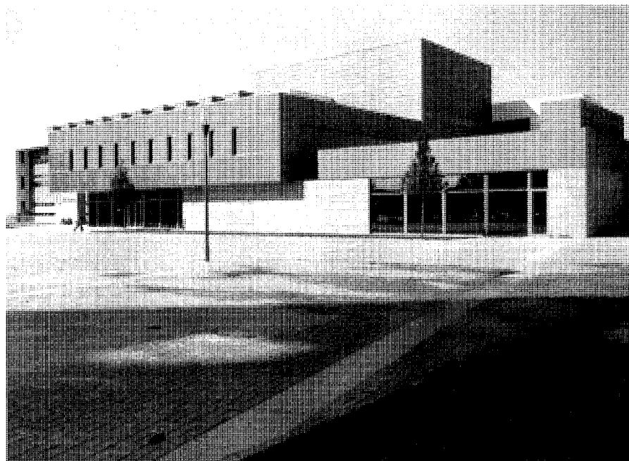
Fachada principal. Fotografía del autor.
