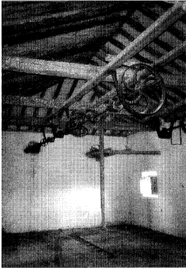
Molino. Antiguo sistema de poleas y engranajes en cubierta. Foto. Virginia Torres.
