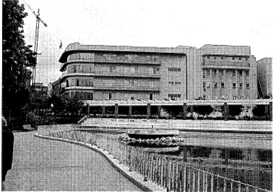
Vista de conjunto del conservatorio y biblioteca. Foto José Ablanedo.
