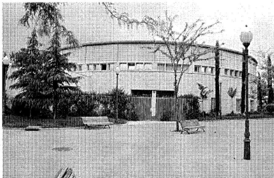
Vista exterior. Foto José Ablanedo.
