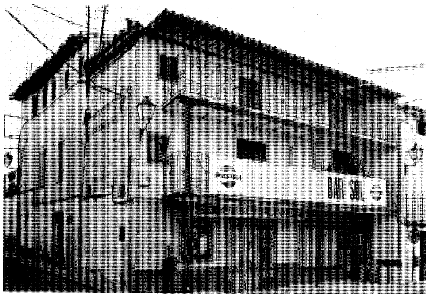
Vivienda en plaza de la Constitución, 7.
