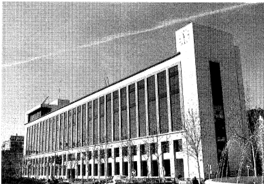
Vista de conjunto. Foto Pilar Martín-Serrano.
