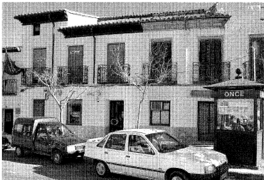
Vivienda en la calle Libertad 2 y 4. Foto José Ablaneda.
