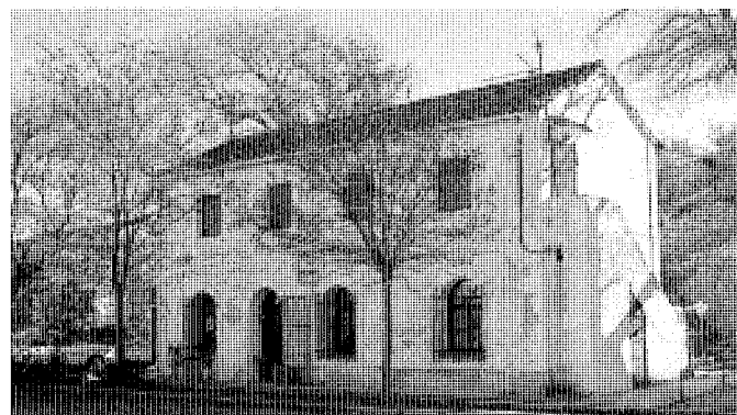
Apeadero del ferrocarril. Foto.: Jose Ablanedo.
