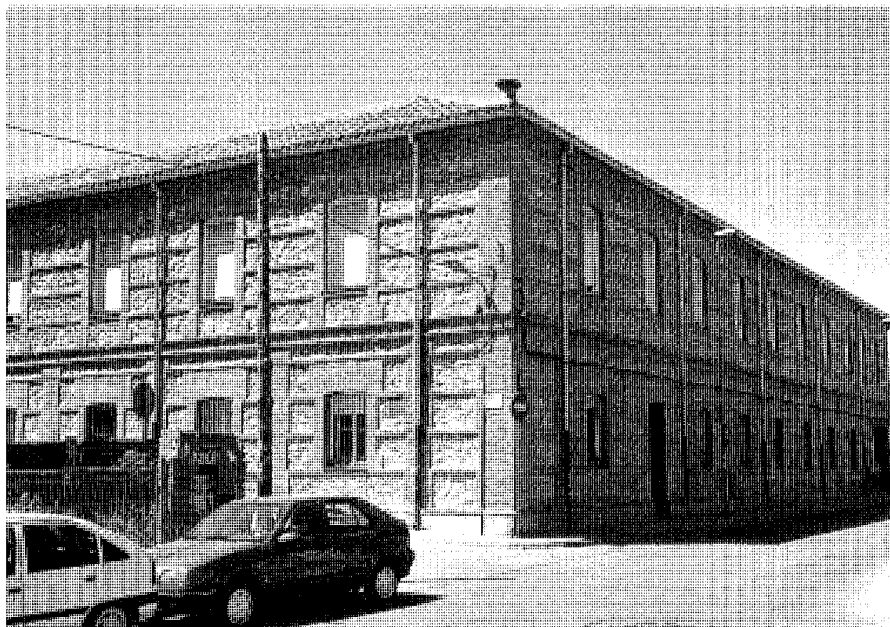
Vista de las fachadas principales del Convento de San Nicolás.
