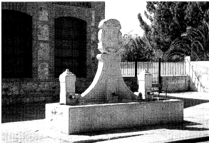
Vista de la Fuente de la villa.
