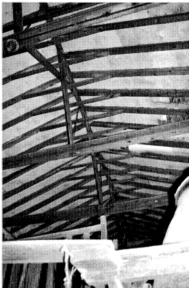
Bodega en la calle de los Clérigos, 45. Detalle de la estructura de cubierta. Foto Miguel Ángel Vega Delgado.
