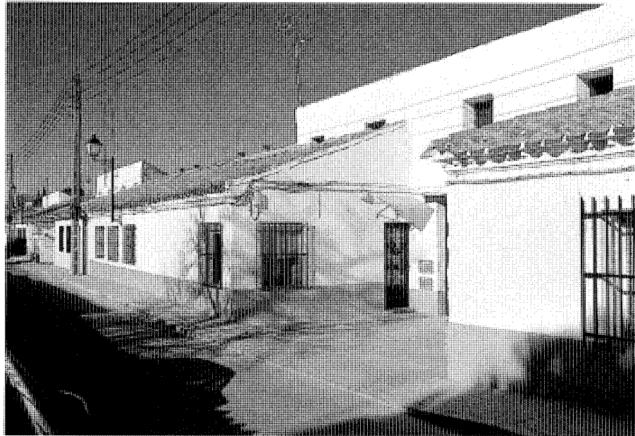
Barriada en la Calle Roma; antes General Mola. Vista de Conjunto
