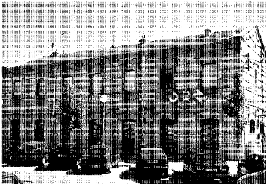
Vista de la fachada principal del edificio de viajeros.
