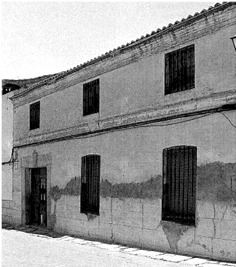
Vivienda en la calle José García Núñez 7. Foto Jose Ablanedo.
