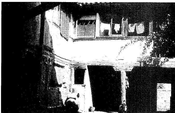
Patio de la derruida casa de "los zorritos". Memoria de Valdemoro I. Fotografías.
