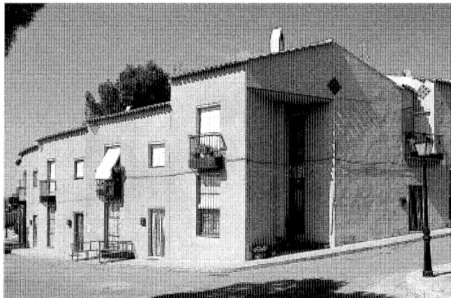
Vista general del conjunto
