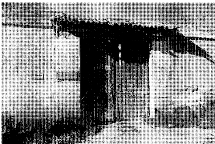
Portalón del patio, hoy entrada principal. Foto M. Lasso de la Vega.
