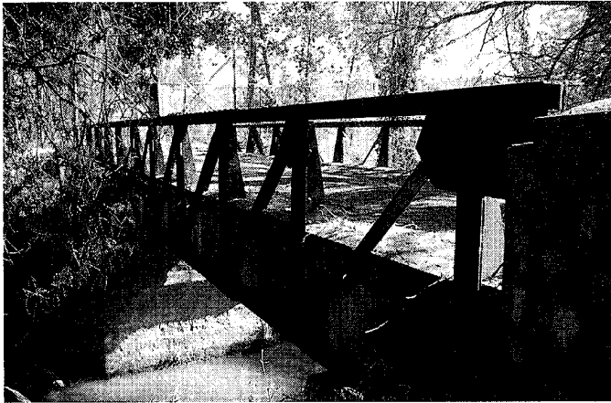
Molino de Cantarranas. Puente de acceso. Foto Actividades y Servicios Fotográficos, S.A.
