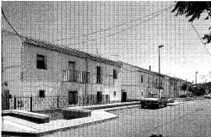
Viviendas de la Delegación Nacional de Sindicatos en la calle Real. Foto Actividades y Servicios Fotográficos, S.A.
