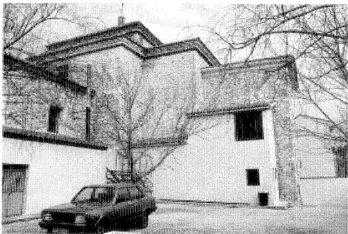
Algunas de las construcciones actualmente adosadas a la cabecera del templo y a las traseras del convento. María Cristina García, 2001.
