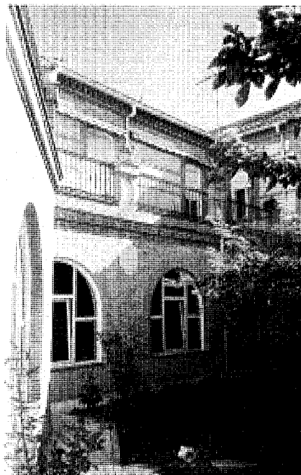
Vista del claustro del Convento de San Nicolás. Foto Alberto Sanz.
