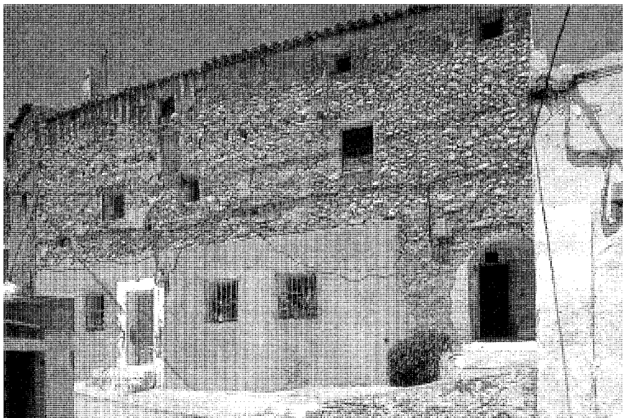
Vivienda en calle Las Conejeras, 36.
