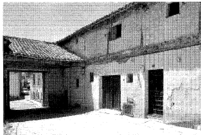
Casa Grande. Patio.
