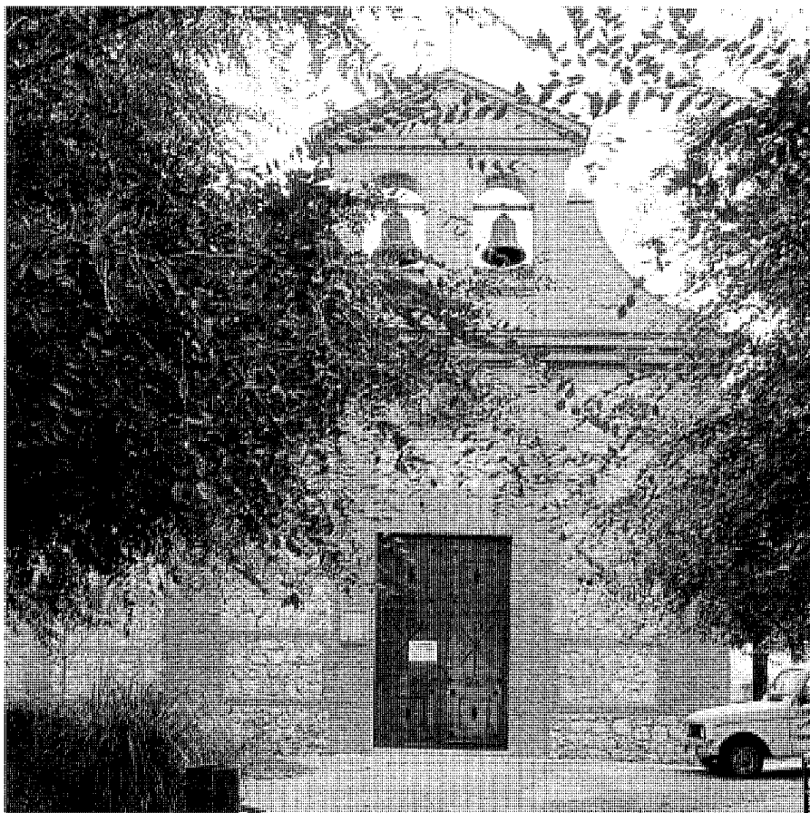
Fachada actual. Jose Ablanedo, 2001.
