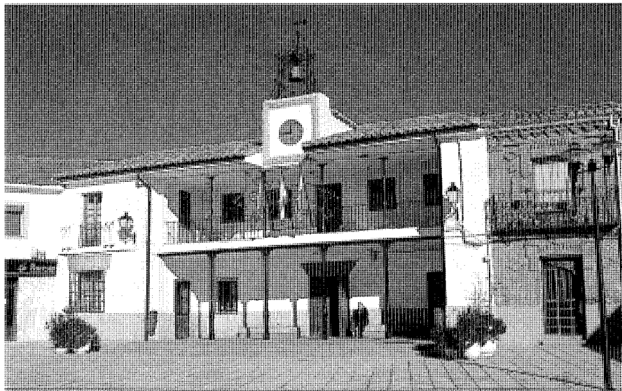
Fachada Principal. Foto Jose Ablanedo.
