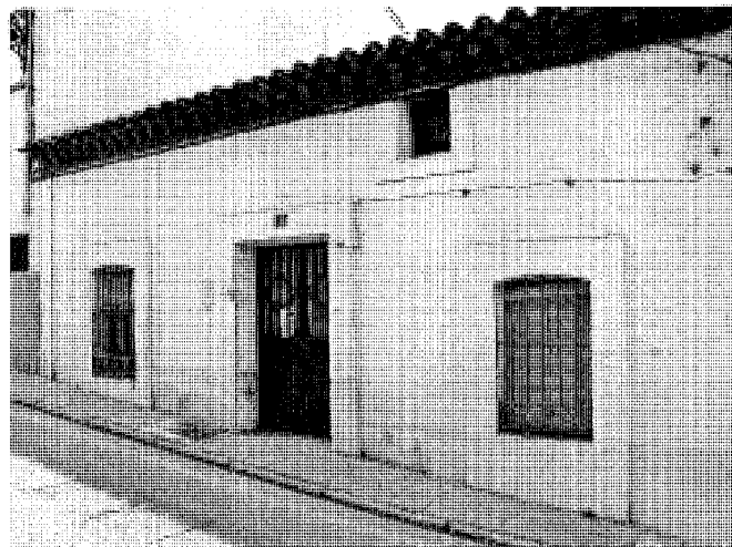
Casa revocada con cornisa de ladrillo en la calle Alcalá, 38. Foto, Jose Ablanedo, 2008.
