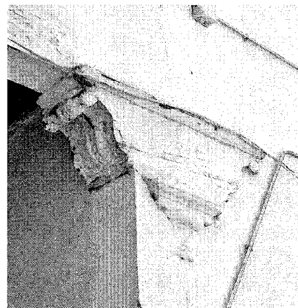
Detalle de zapata de madera labrada. Foto Vicente Patón.
