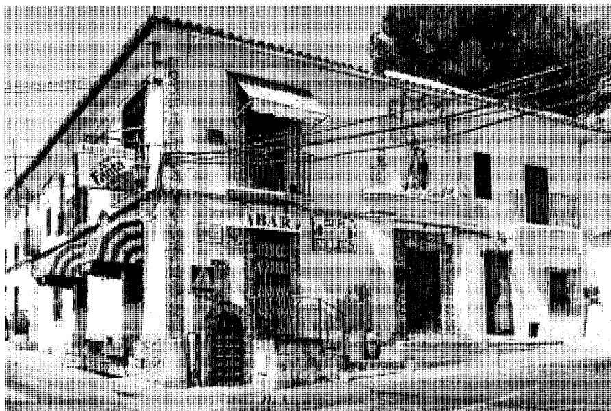
"Casa de los Escudos" en la calle Mayor, 26, vista exterior.
