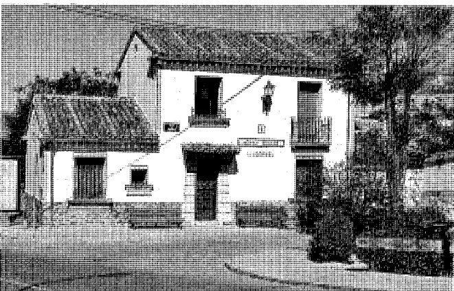
Vista de la fachada principal de la antigua vivienda del médico, reformada recientemente para uso hotelero: Casa rural "El Zumaque". Foto Patricia Hernández Lamas.
