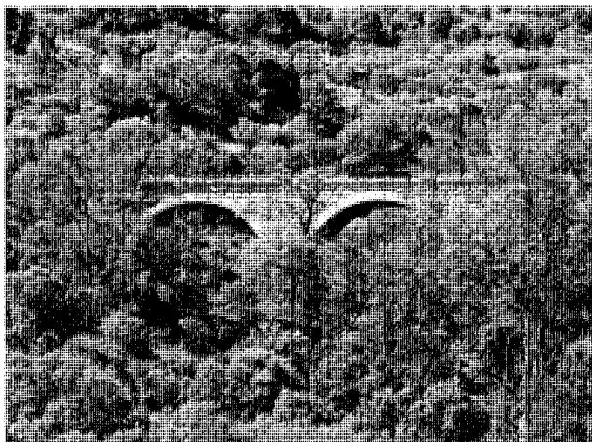
Viaducto del ferrocarril en Valdepalacios.
