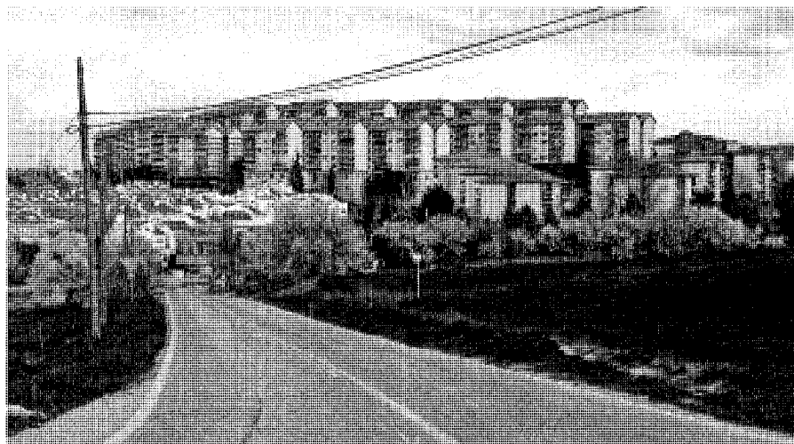
Vista de la aglomeración de bloques y viviendas unifamiliares desde la carretera de Cobeña. Foto, Jose Ablanedo, 2008.
