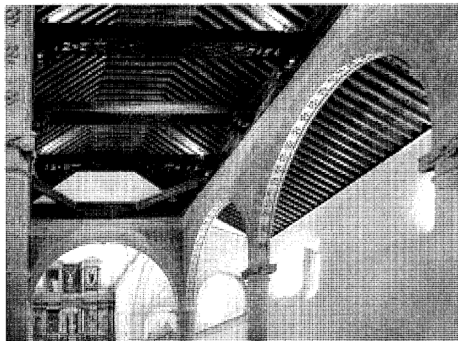
Vista interior de las naves y las cubiertas tras las obras de rehabilitación. Foto cedida por Antonio Lopera Arazola.
