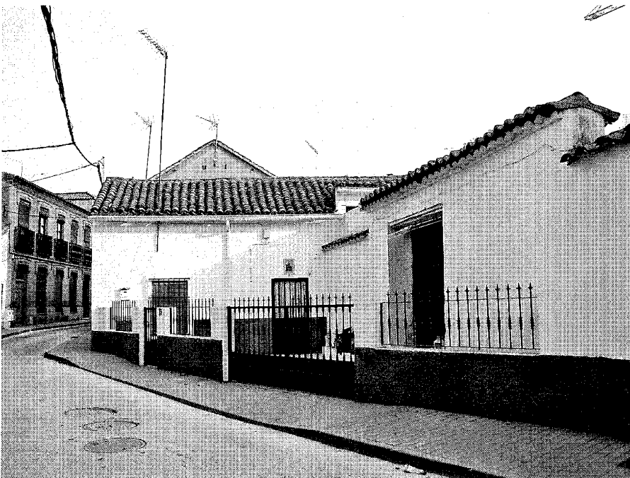
Vivienda rural en calle Mayor, 15. Foto José Ablanedo.
