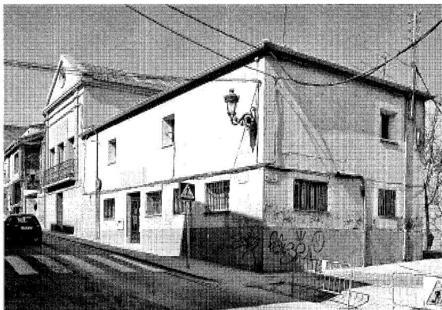
Vista de conjunto a la calle Mayor c/v Paloma. Foto, Jose Ablanedo, 2008.
