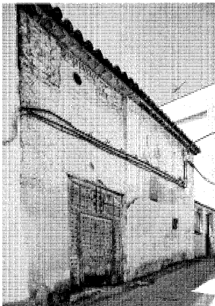
Vivienda en la calle de Oriente, nº 2.
