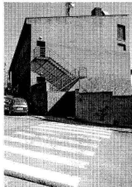
Fachada lateral sur. Foto, Jose Ablanado, 2008.
