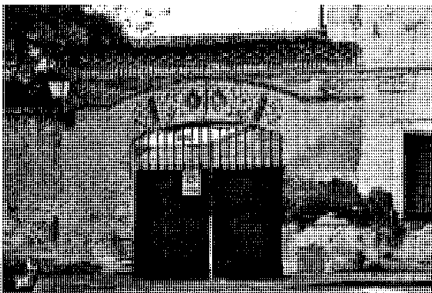
Portón de la misma vivienda antes de la reforma. Foto Pilar Lorenzo.
