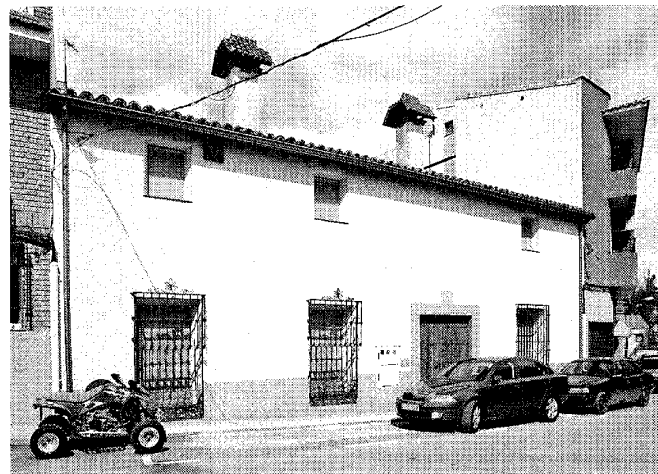
Vivienda en la calle Morata, 30.
