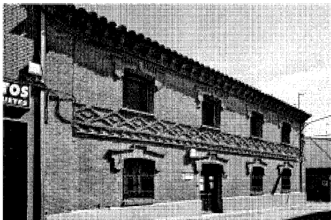
Vivienda en la calle Vilches, 15.
