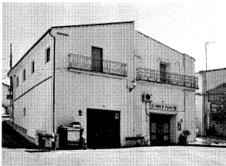
Vista de la fachada principal a la plaza del Generalísimo.
