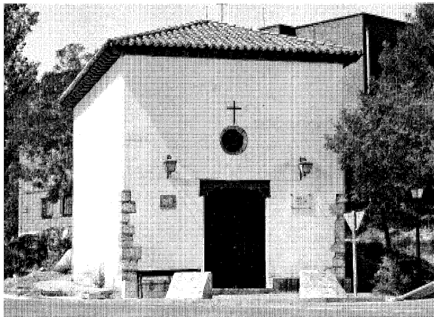
Ermita de San Roque, vista exterior.
