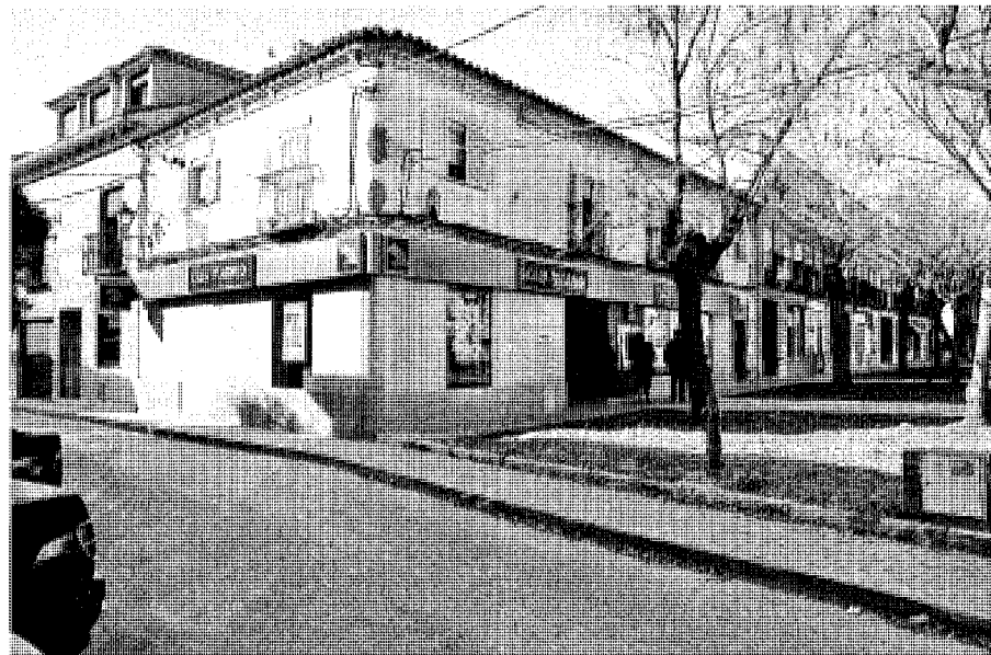
Calle Mayor, 2. Foto José Ablanedo.
