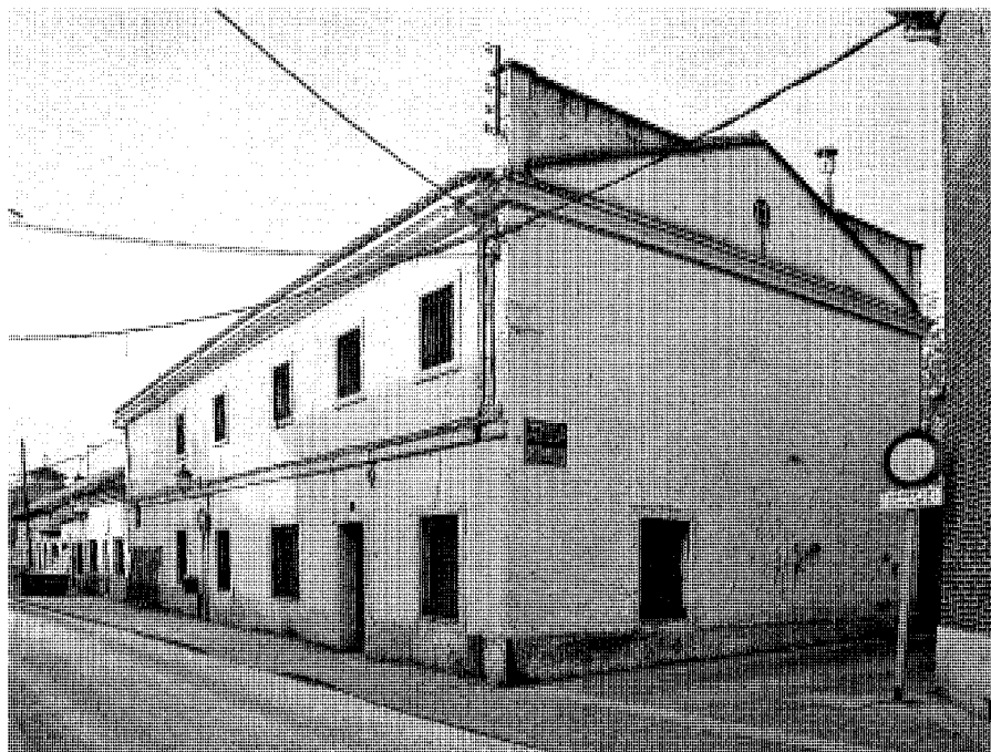
Calle Mayor, 20. Foto José Ablanedo.
