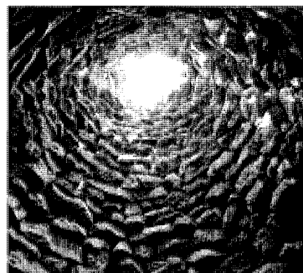
Interior del chozo del corral del Almendrillo. Foto Vicente Patón.
