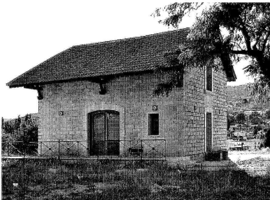
Edificio destinado a cafetería, 2005. Foto Patricia Hernández Lamas.
