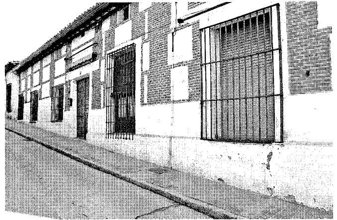
Ejemplo rehabilitado de la calle Limón Verde, 10. Foto, Jose Ablanedo, 2008.
