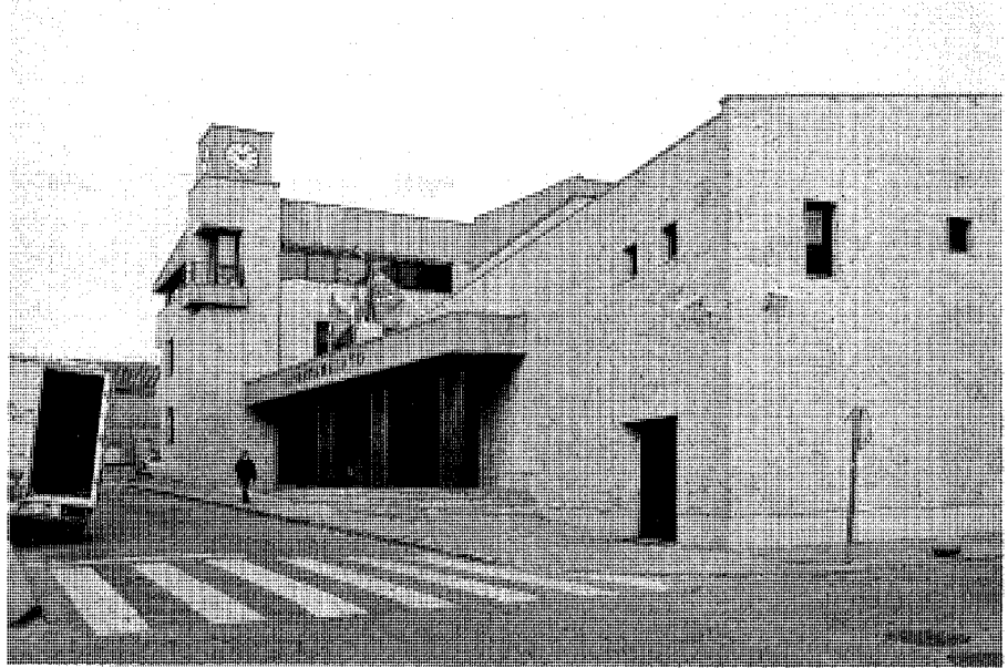
Nuevo edificio consistorial en C/ Daganzo, 2 c/v a C/ del Fresno y C/ de la Soledad. Foto José Ablanedo.
