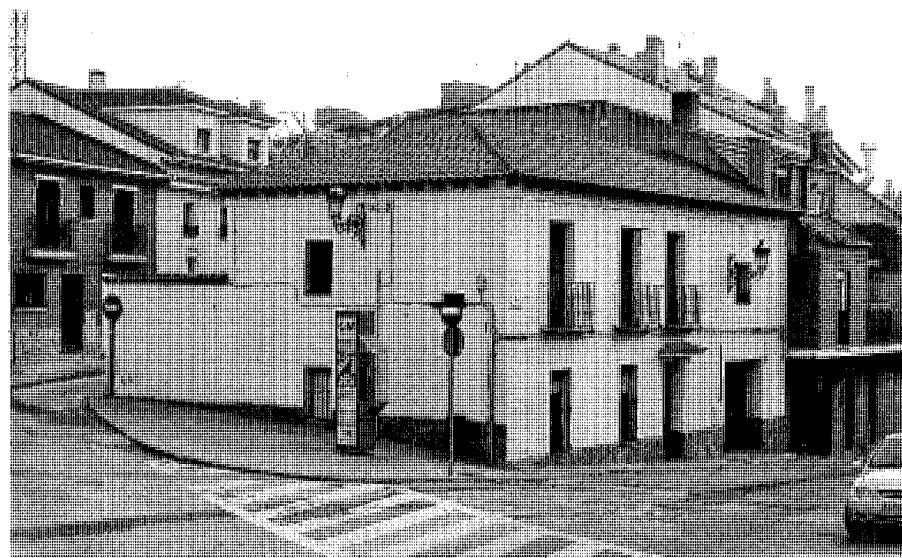
Casa de dos plantas en la encrucijada de la calle de la Paloma, 50, la plaza del Trinquete y la ronda de la Constitución, 2. Foto, Jose Ablanedo, 2008.
