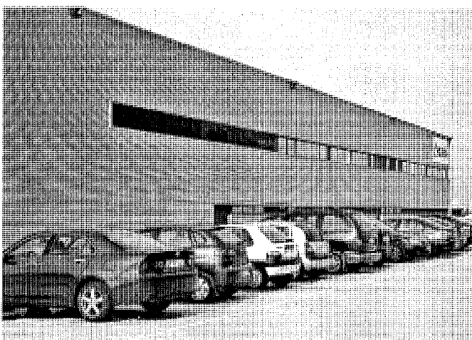
Fachada representativa del edificio de producción. Foto, Félix Cabrero, 2005.
