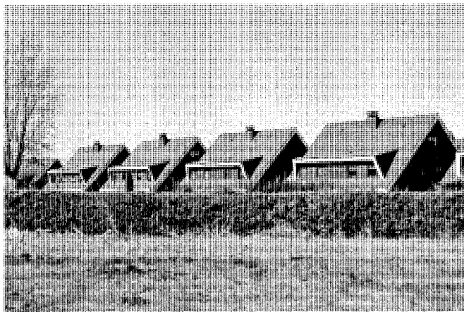
Conjunto residencial de viviendas unifamiliares Los Girasoles, en la carretera M-111. Foto, Jose Ablanedo, 2008.
