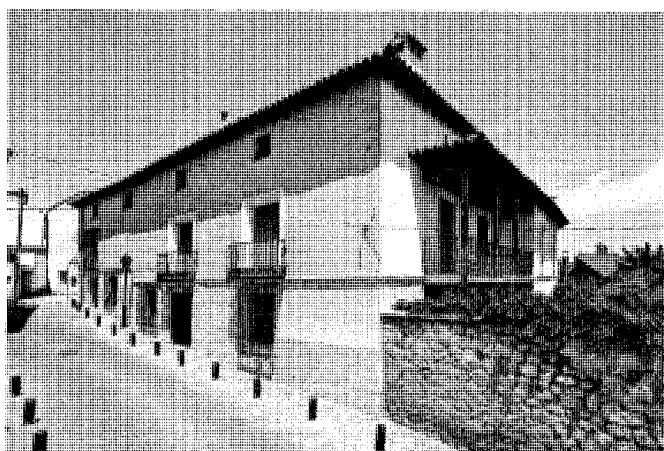
Casa de los Garnica en el nº 11 de la calle del Viento.
