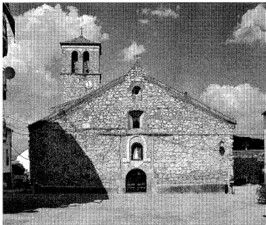
Fachada occidental. Foto Vicente Patón.
