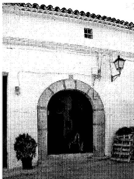
Puerta de acceso a la vivienda en la calle Magistrado Benito Torres 4, 2005. Foto Patricia Hernández Lamas.
