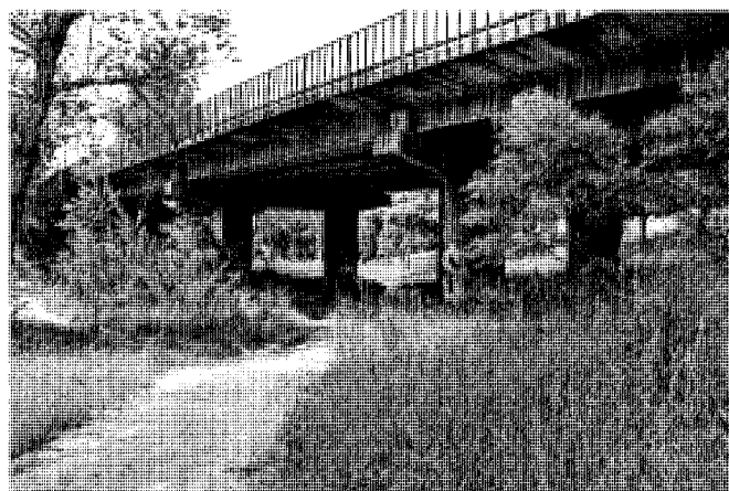
Puente sobre el arroyo de la Barranca, que fragmenta la urbanización. Foto, Jose Ablanedo, 2008.
