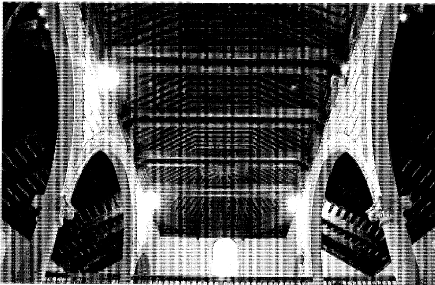
Artesonado de la nave central y detalle del menado de una de las cubiertas laterales. Foto José Ablanedo.
