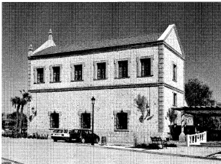
Fachada lateral una vez rehabilitada.
