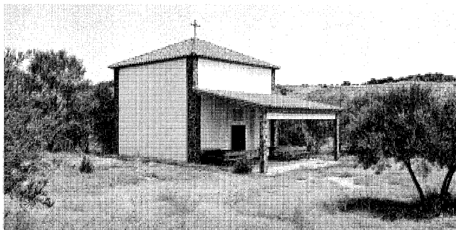
Ermita de San Isidro, vista exterior.
