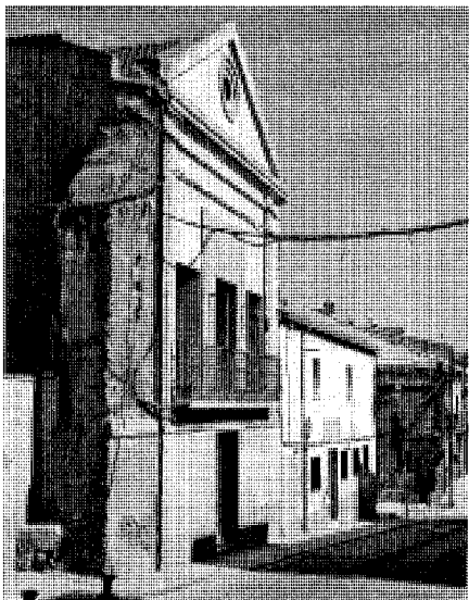
Biblioteca municipal reconvertida sobre el edificio del antiguo Ayuntamiento. Foto, Jose Ablanedo, 2008.
