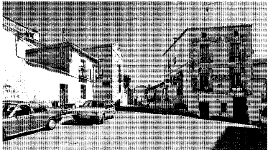
Vista de la plaza del Caudillo de Ambite desde el sur.
