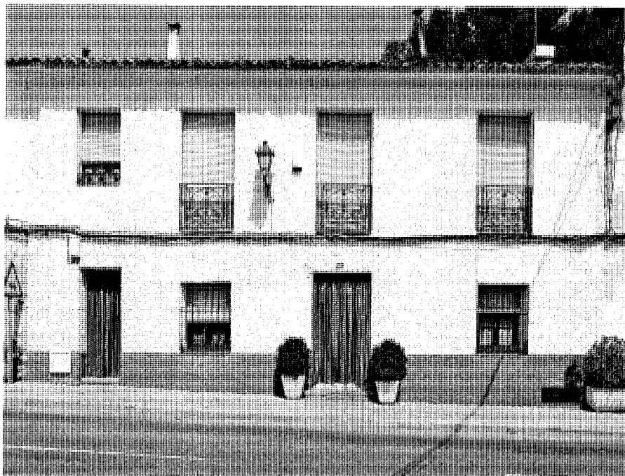
Vivienda en la calle Mayor, 30, vista exterior.
