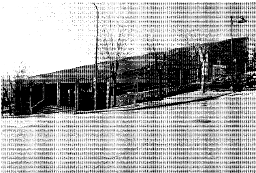
Vista general por la fachada de acceso en la confluencia de las calles Valdeamor y Carrachel. Foto, Jose Ablanedo, 2008.
