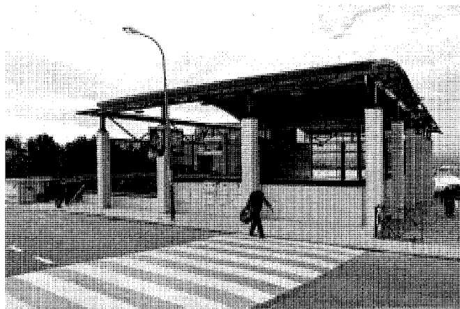
Pistas deportivas cubiertas al borde de la ronda de la Constitución. Foto, Jose Ablanedo, 2008.
