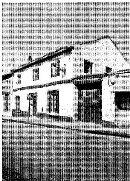
Vivienda en la calle Mayor, 18. Foto, Jose Ablanedo, 2008.
