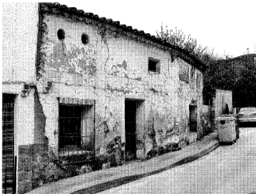
Vivienda en la calle del Agua, nº 17. Foto Vicente Patón.
