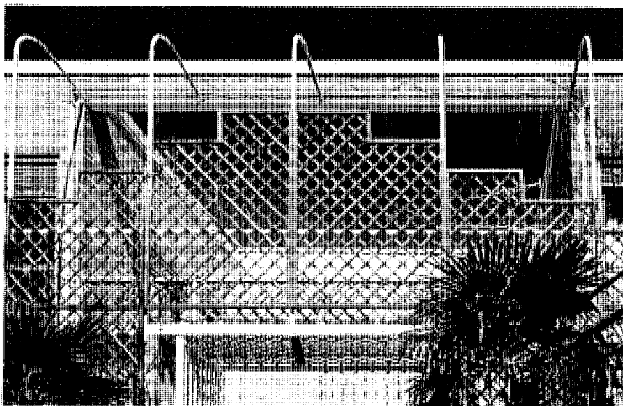
Detalles frontal y lateral de la galería de la fachada de acceso. Fotos cedidas por el autor.
