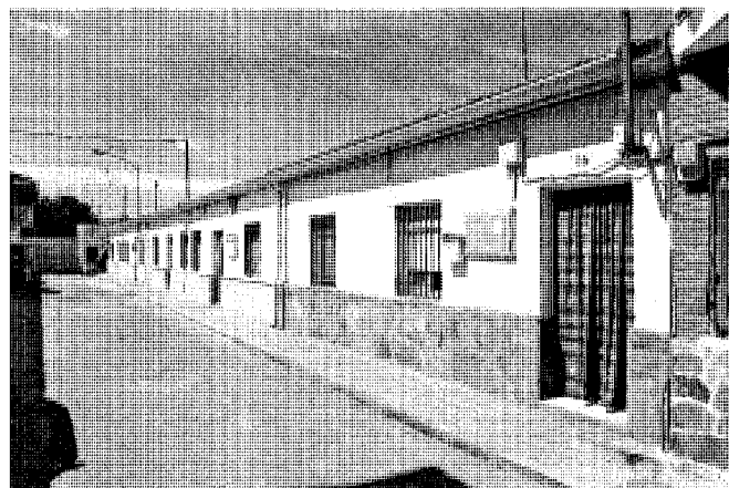
Viviendas de la calle Miguel Cervantes.
