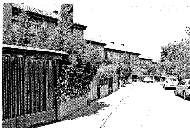
Modelo de agrupación lineal de viviendas unifamiliares en las Eras Altas, hacia la carretera de Ajalvir. Foto, Jose Ablanedo, 2007.
