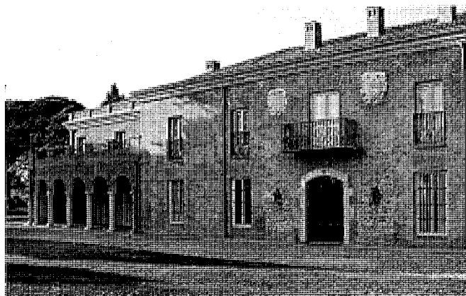
Conjunto rehabilitado. Fachada principal. Página web , 2007.
