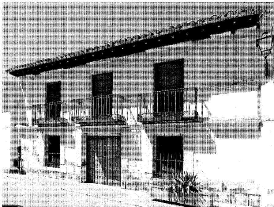
Calle de la Iglesia, 6.
