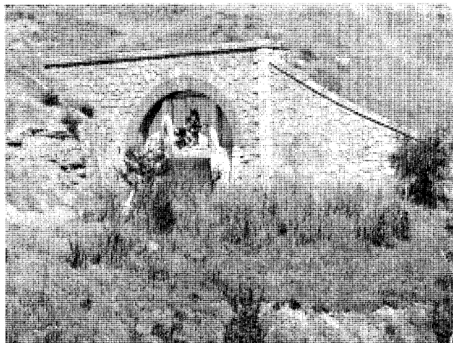
Túnel del ferrocarril de los 40 días. Foto Fundación Arquitectura COAM.
