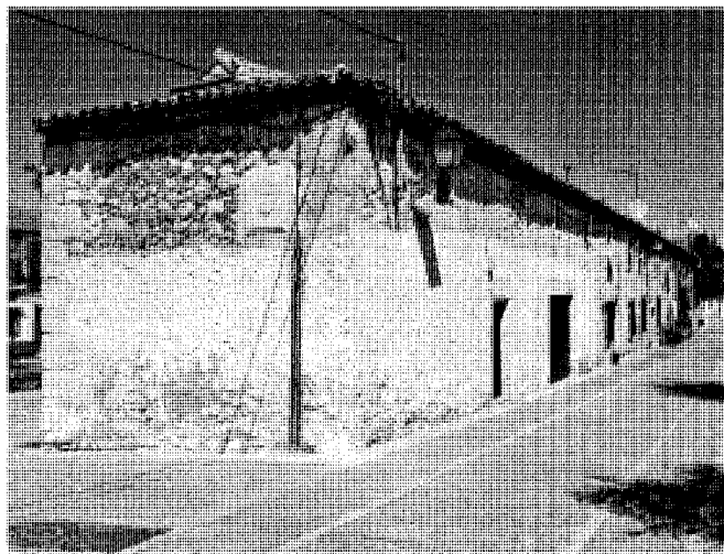
Viviendas de labradores en c/ Palacio, 7 c/v pza. Cebada.
