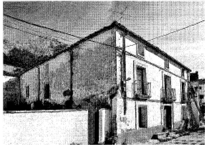
Casona desaparecida de la calle Mayor, nº 63. Foto Vicente Patón.
