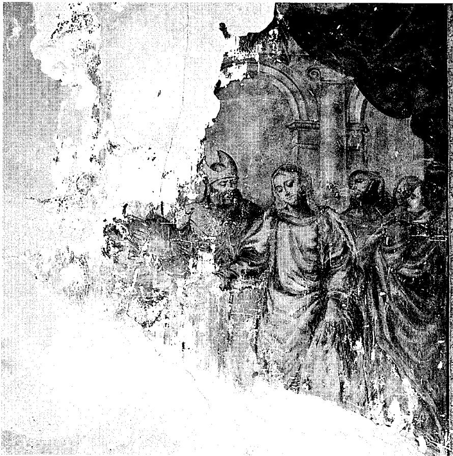
Detalle de los desposorios de la Virgen en la capilla del Rosario, 1994. Proyecto de restauración de la Iglesia de San Andrés. Apóstol. Arq. J. de D. de la Hoz y E. Nuere. Oficina técnica del Obispado de Alcalá de Henares.
