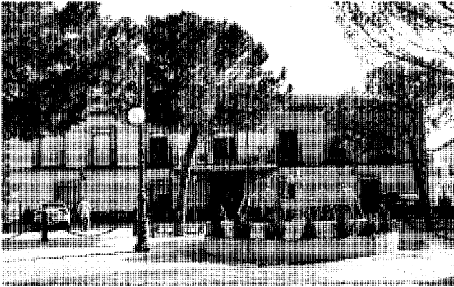
Pza. de la Constitución y edificio consistorial. Foto José Ablanedo.
