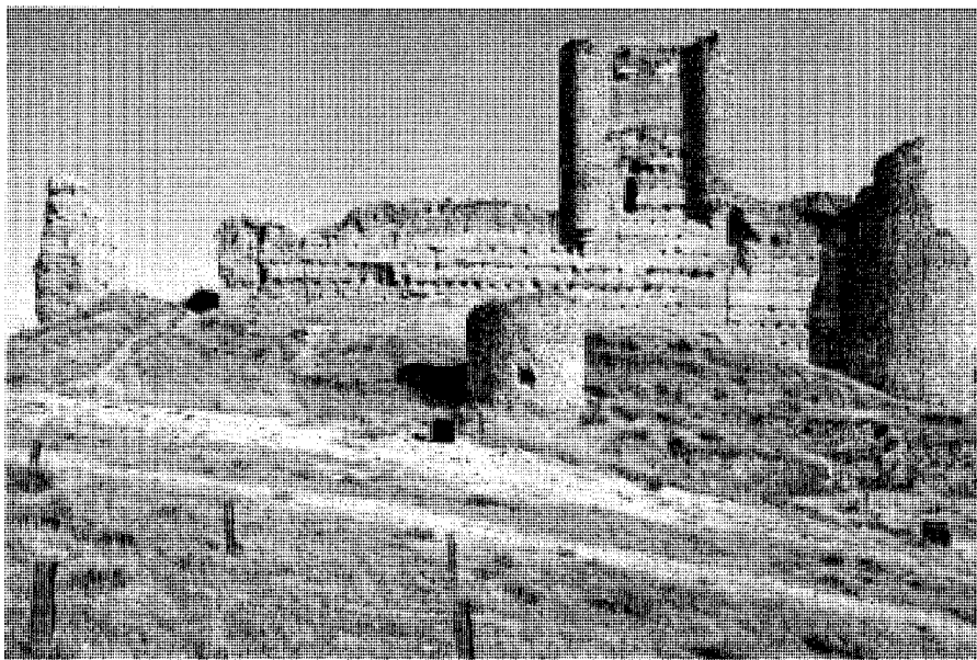
Fachada con Torre del Homenaje.
