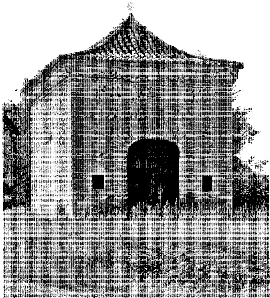
Vista exterior de conjunto por la fachada de acceso. Foto, Jose Ablanedo, 2007.
