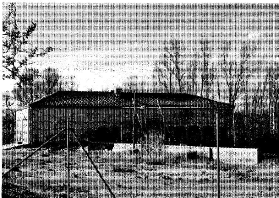
Molino de Estremera. Central eléctrica. Foto Inmaculada Sánchez.
