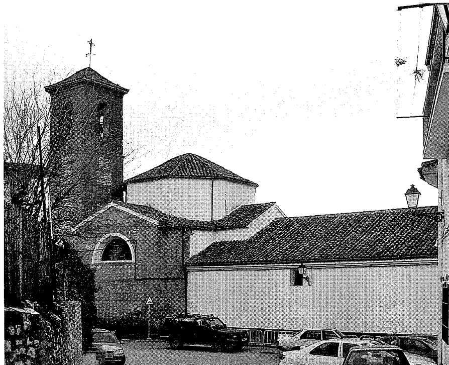
Vista exterior. Foto Fundación Arquitectura COAM.
