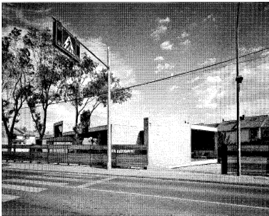
Fachada a la Crta. de Fresno. Foto cedida por el autor.
