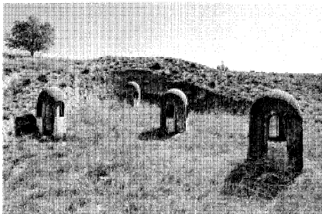
Linternas desde el exterior.
