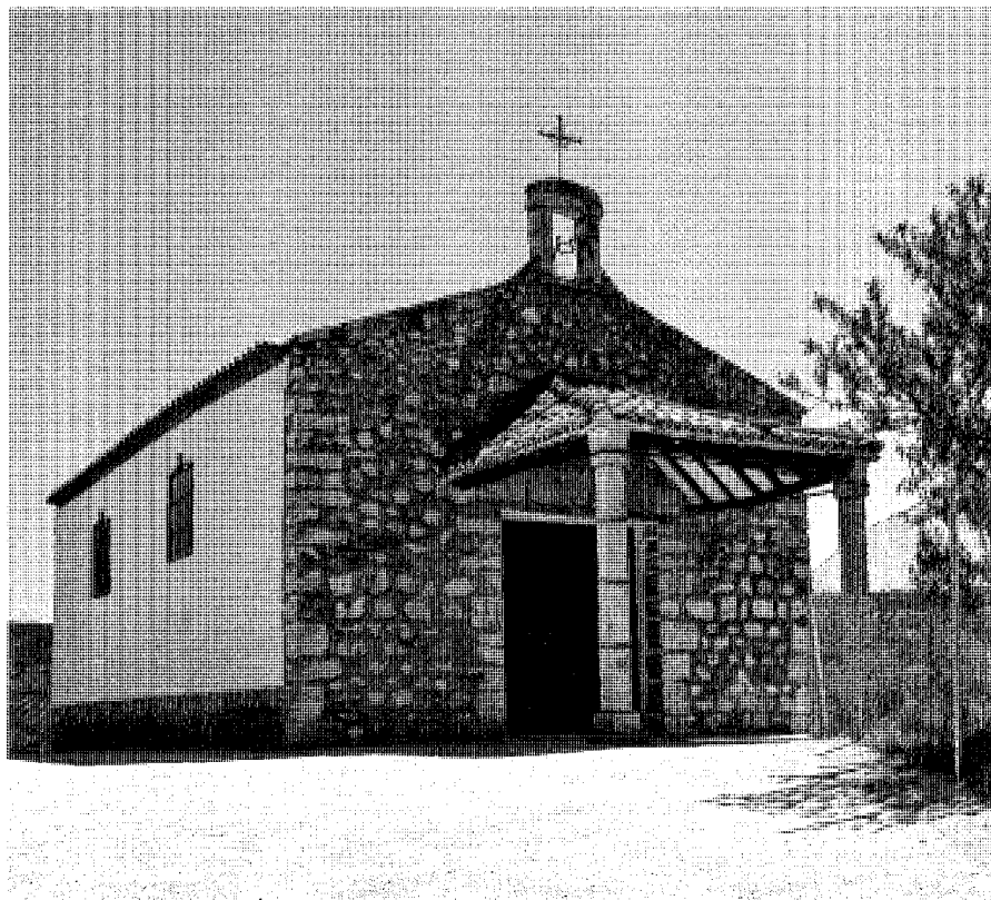
Vista exterior. Foto Fundación Arquitectura COAM.
