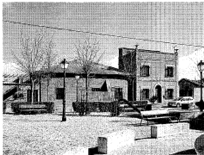
Vivienda urbana en el nº 7, y dependencias agropecuarias anexas. Foto José Ablanedo.
