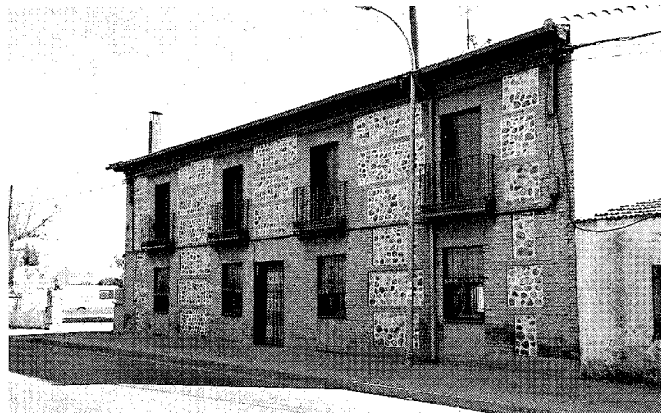
Vivienda urbana al borde de la carretera M-103 en la calle Algete, 9. Foto, Jose Ablanedo, 2007.
