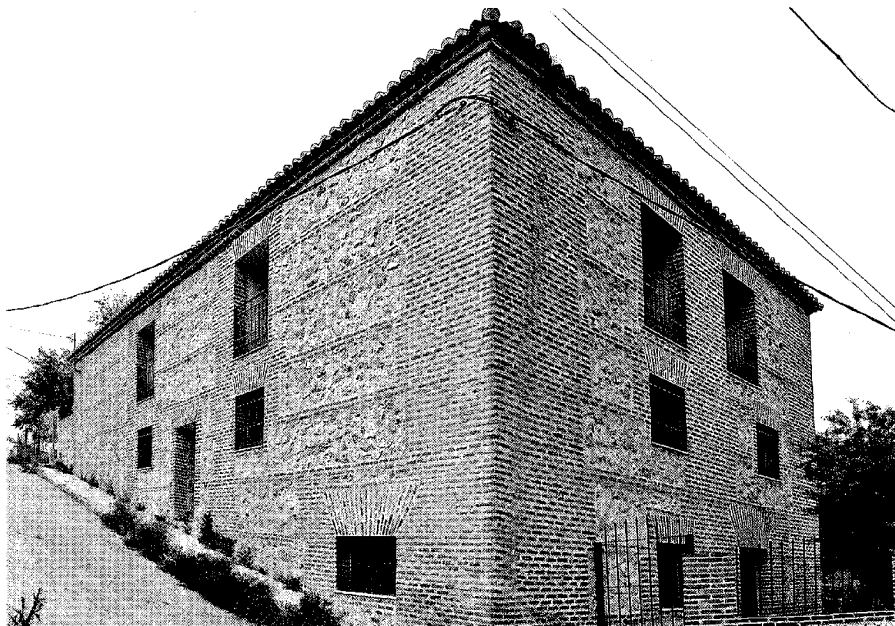
El antiguo pósito pontifical, tras su reciente rehabilitación para uso residencial. Foto Vicente Patón.
