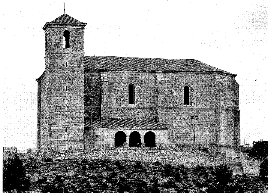
Fachada meridional. Foto Vicente Patón.
