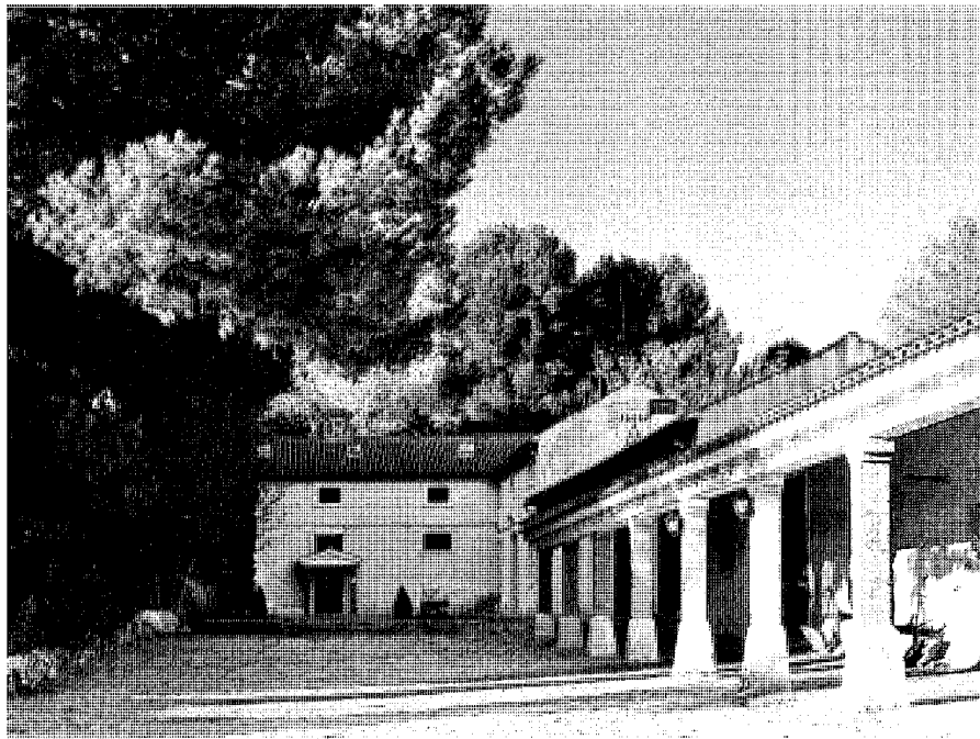
Finca de los Arenales. Casa principal. Foto Inmaculada Sánchez.
