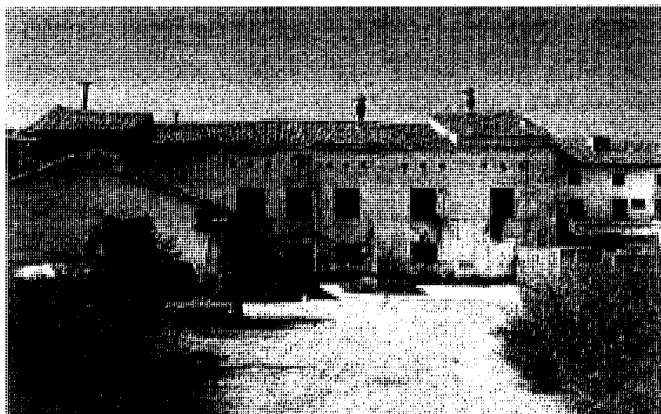
La antigua harinera antes del incendio de 1996.
