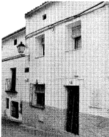
Vivienda en la Placituela, 1.
