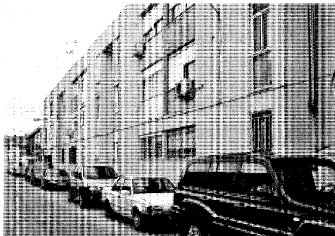
Bloques de vivienda colectiva en la calle Félix Rodríguez de la Fuente c/v Algete. Foto, Félix Cabrero, 2005.
