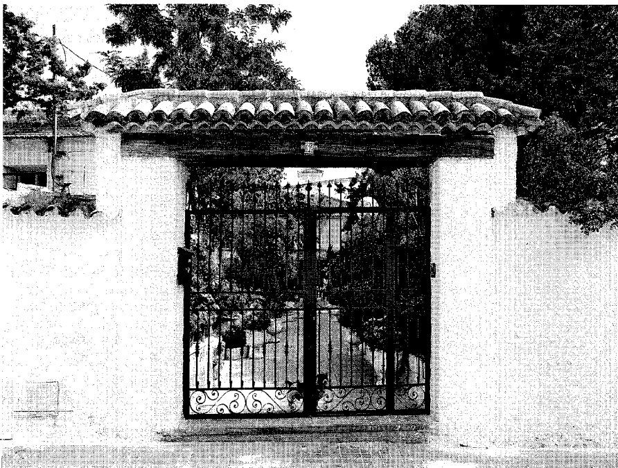
Entrada casa calle Mayor, 32.
