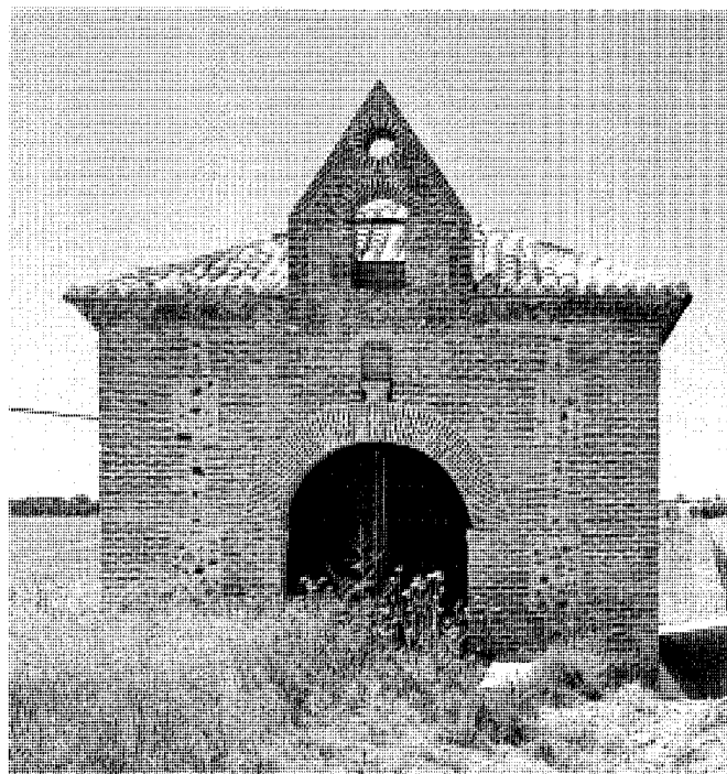
Fachada de acceso. Foto José Ablanedo.
