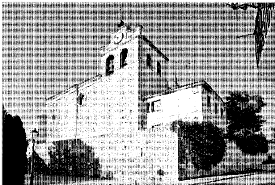
Fachada desde plaza.
