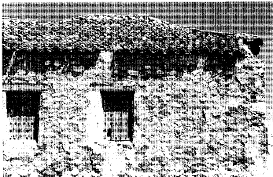
Detalle de la casa de plaza de la Caserna, nº 3, año 1997. Dirección General de Arquitectura y Patrimonio. Servicio de Arquitectura y Patrimonio.
