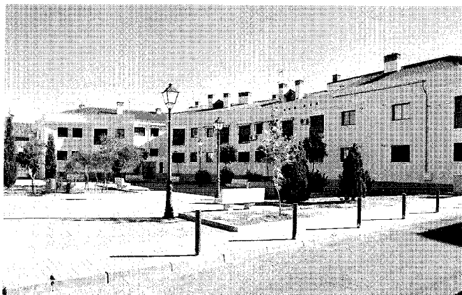
Conjunto residencial entre las calles San Roque y Cruces. Foto, Jose Ablanado, 2007.
