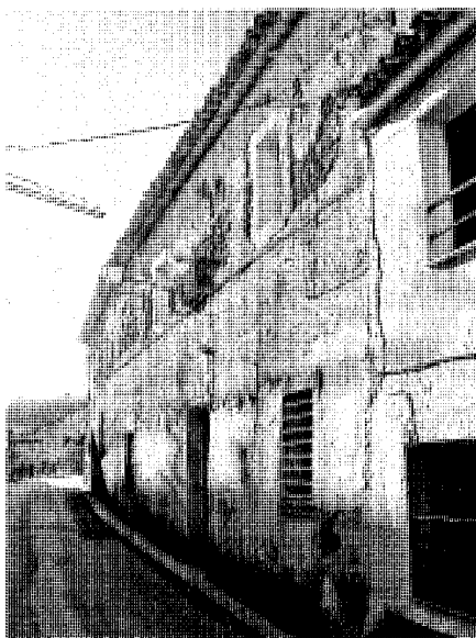
Vivienda en la calle Carreteros, 4. Foto Ángel Cordero.
