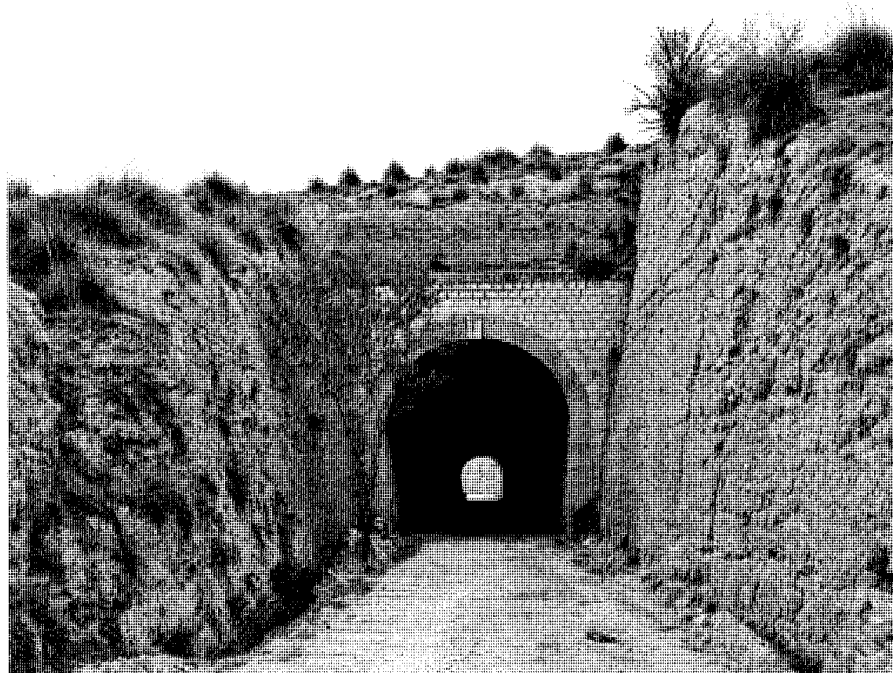
Entrada de un túnel del Ferrocarril de los 40 días en Estremera. Foto Inmaculada Sánchez.
