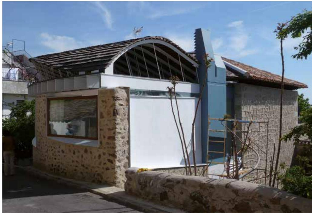
La nueva estructura de perfiles laminados IPE resuelve la cubierta sin elementos horizontales permitiendo así incorporar el espacio bajo cubierta al interior del edificio y dotar al interior techos más altos.
