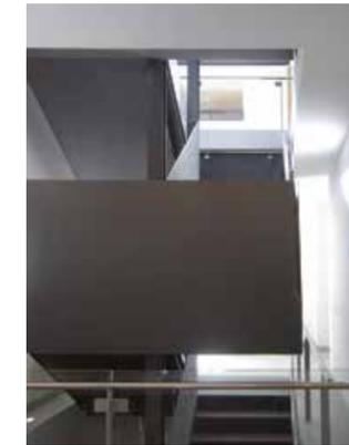
Se modifica el trazado y la situación de las dos escaleras existentes con el objetivo de habilitar un itinerario practicable en planta baja que conecte ambos núcleos verticales a través del patio. La instalación de ascensor completa el itinerario accesible interior.
