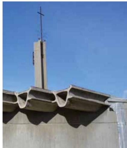
Sustitución del forjado deteriorado y colocación de tapas en las vigas huecas para controlar el caudal de aire en su interior.
