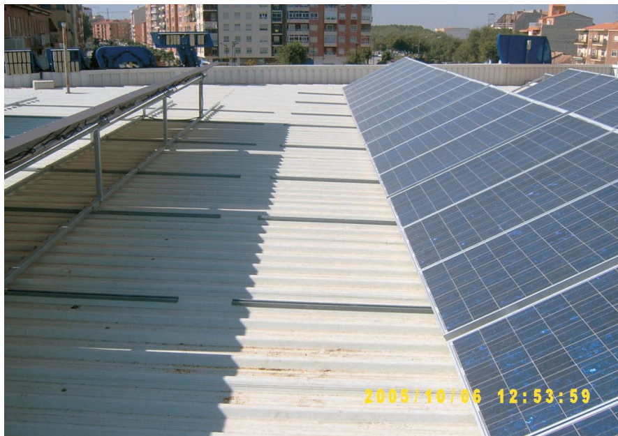
Foto 5. Estructura sobre tejado plano de uralita.
