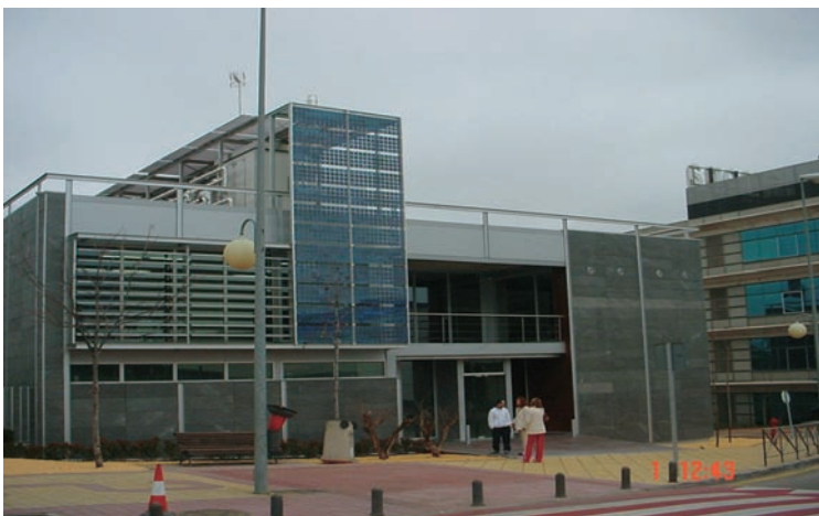
Foto 8. Instalación fotovoltaica integrada en muro cortina.
