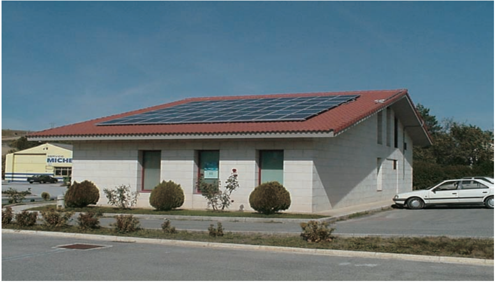
Foto 3. Sistema fotovoltaico sobre tejado inclinado.
