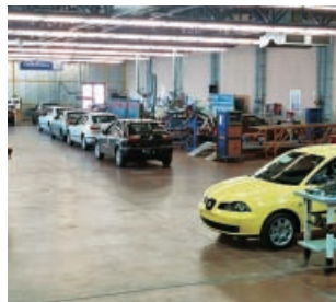
Foto 2. Alumbrado con lámparas fluorescentes.
