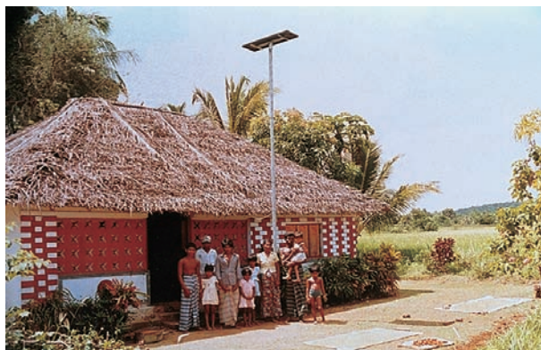
Foto 1. Instalación fotovoltaica aislada.
