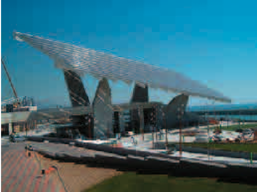
Foto 3. Pérgola fotovoltaica de Forum 2004. Barcelona.
