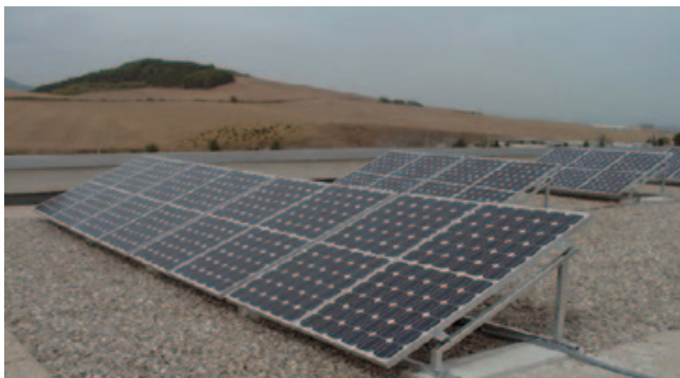
Foto 4. Sistema fotovoltaico sobre tejado plano.
