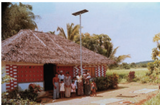
Foto 1. Instalación fotovoltaica aislada.
