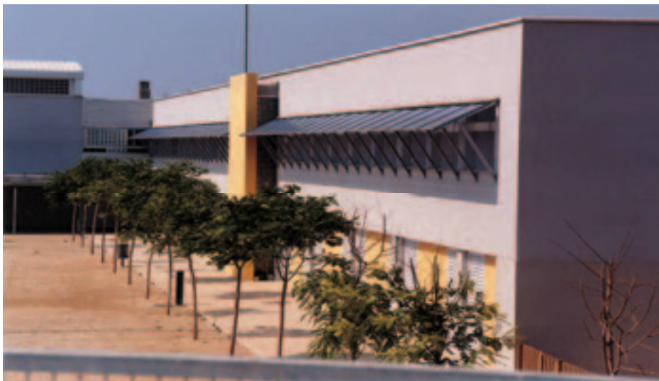
Foto 9. Instalación fotovoltaica integrada en parasoles.
