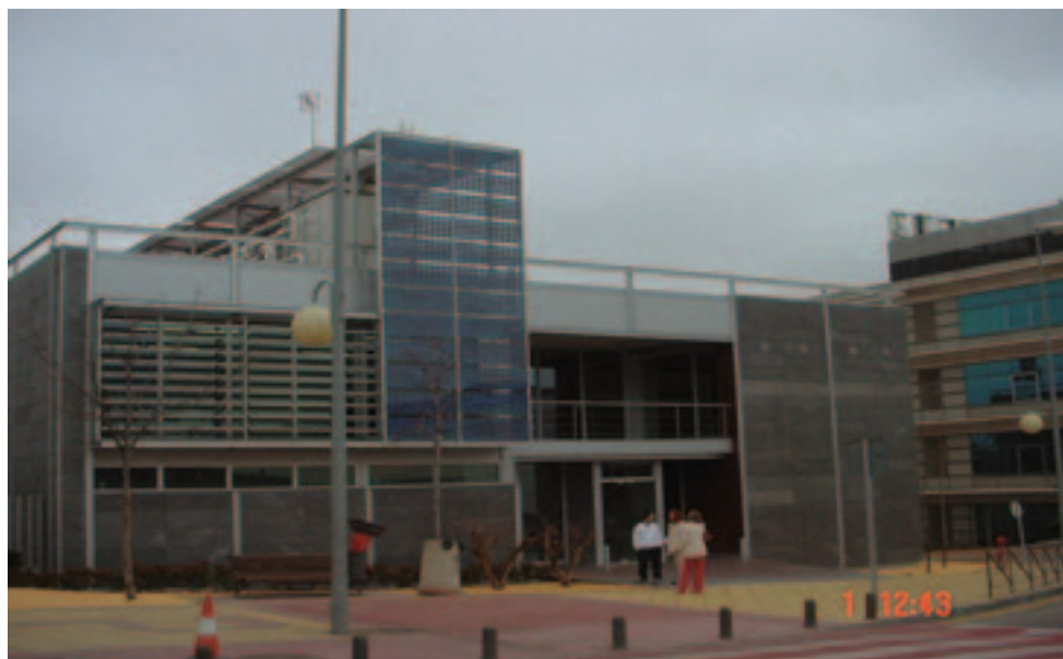
Foto 6. Instalación fotovoltaica integrada en muro cortina.
