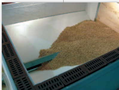
Figura 23: Sección de almacenamiento tipo silo.
