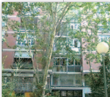
Figura 43: Edificio de viviendas en la calle Pedro Muguruza.
