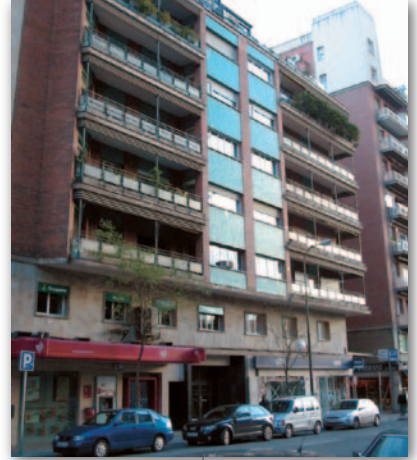
Figura 9: Edificios de viviendas con caldera de biomasa para calefacción.
