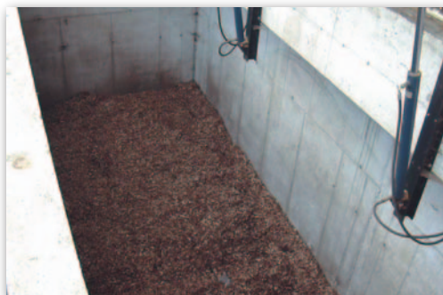
Figura 11: Depósito de almacenamiento exterior
