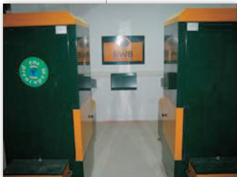
Figura 47: Sala de calderas del Hotel Flamingo.
