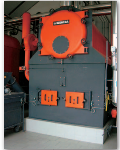
Figura 4: Caldera de biomasa para district heating (850 kW).
