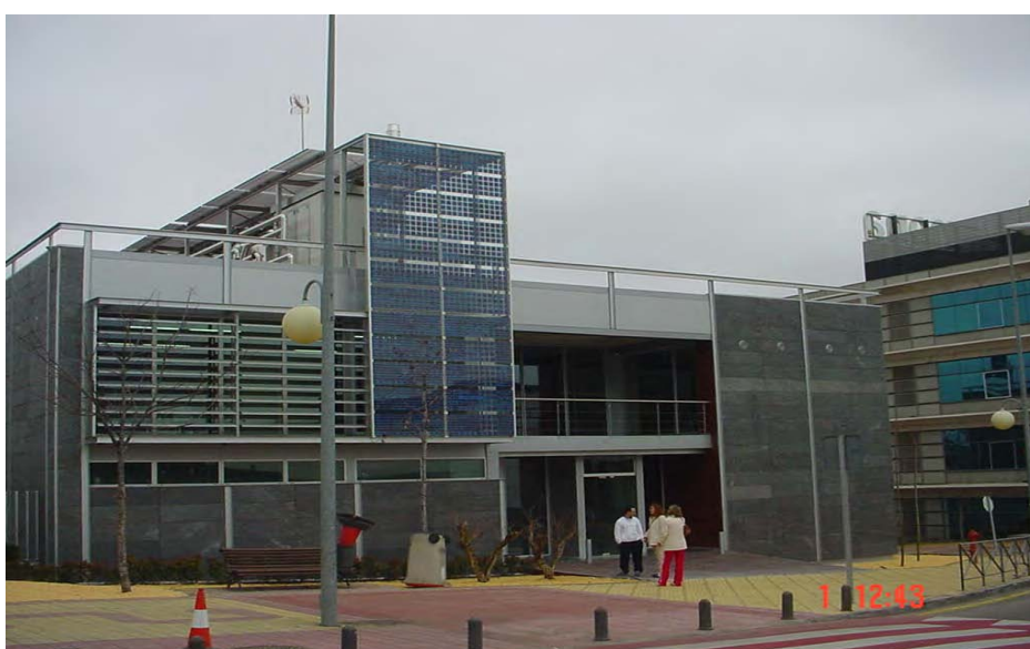
Foto 8. Instalación fotovoltaica integrada en muro cortina.
