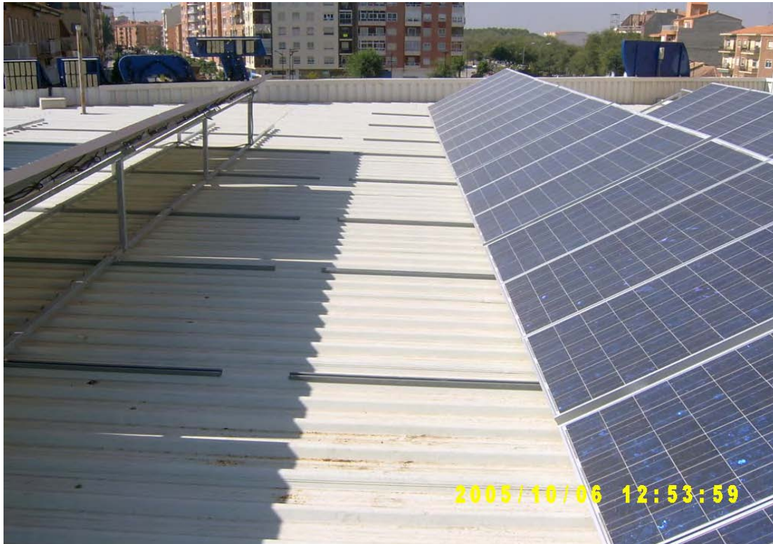
Foto 5. Estructura sobre tejado plano de uralita.
