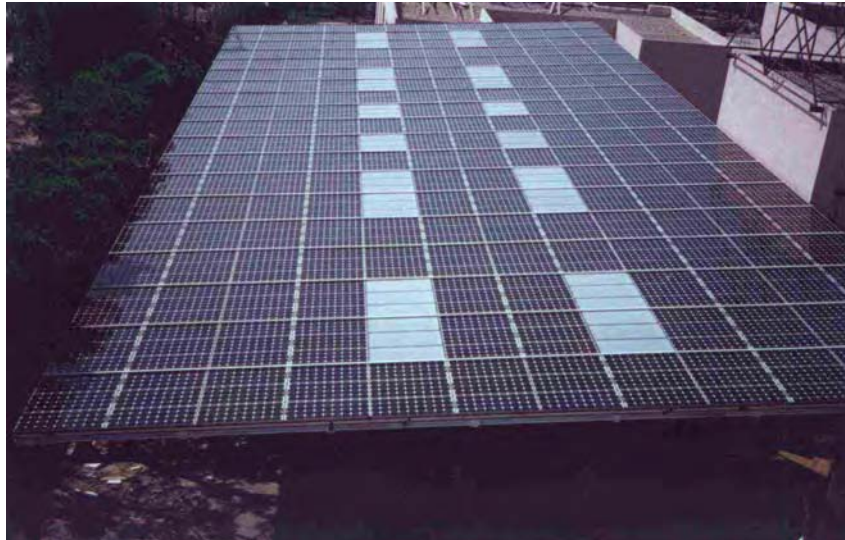
Foto 9. Instalación fotovoltaica integrada en cubierta.
