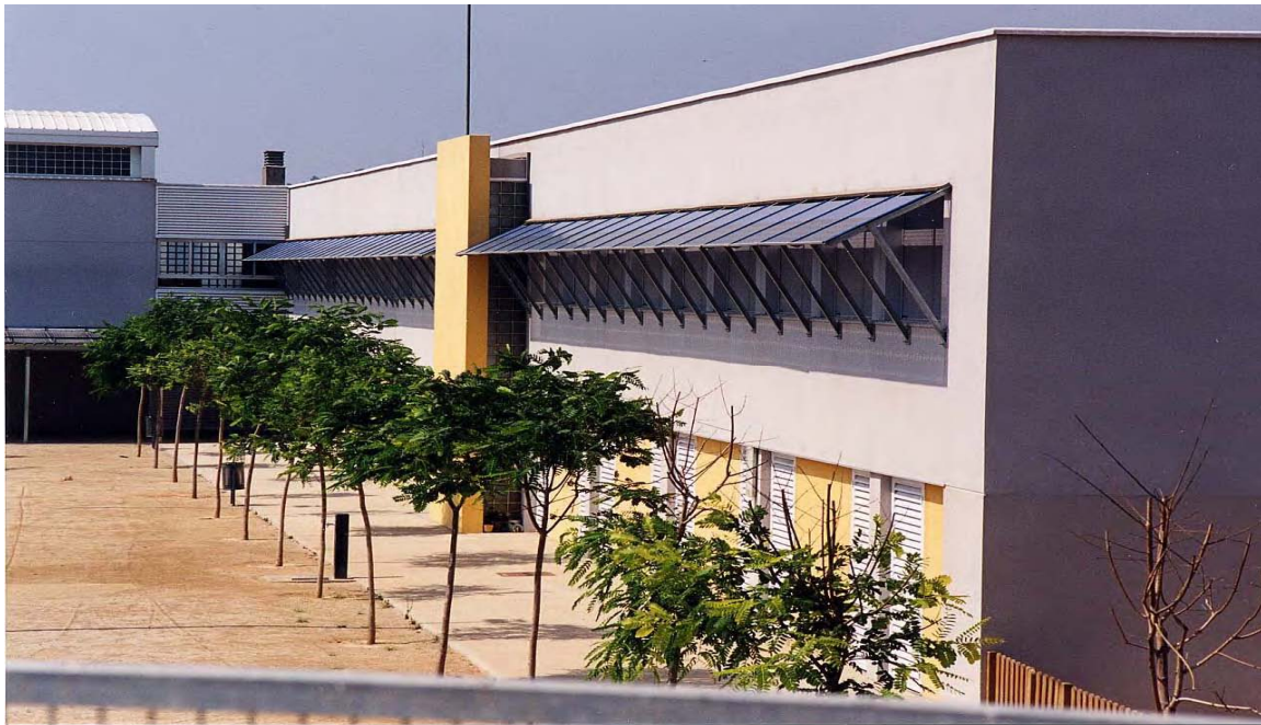
Foto 11. Instalación fotovoltaica integrada en parasoles.
