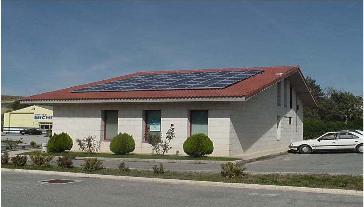
Foto 3. Sistema fotovoltaico sobre tejado inclinado.
