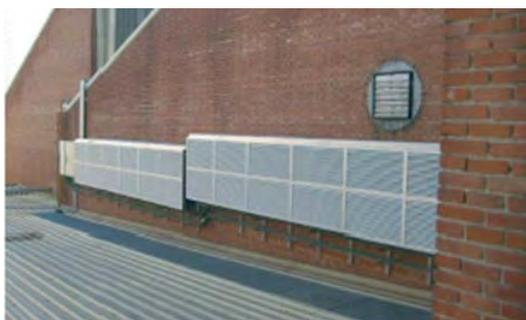
De este modo se obtiene un rendimiento global mayor y mejor fiabilidad del sistema. Cada convertidor tiene una potencia nominal de salida de 5.000 W, un consumo en operación menor de 10 W y tiene conectado dos subcampos solares en paralelo de 17 módulos en serie cada uno.
