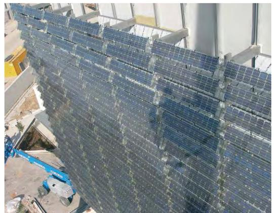
Los módulos fotovoltaicos constituirán las lamas de un sistema de protección ante la radiación solar, dispuesto en la fachada del edificio. Formando una segunda piel y separa-
