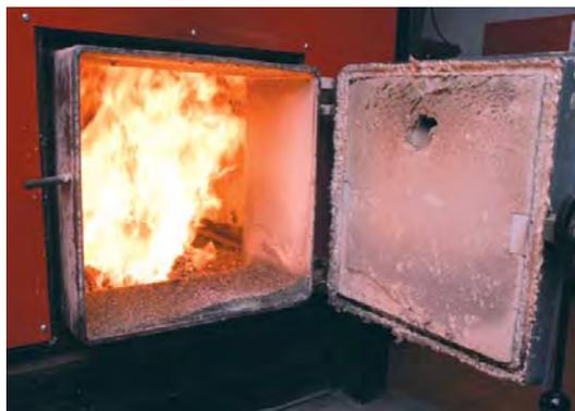
La combustión para calefacción se realiza en una caldera LASIAN HKN 400 de 465 kW, fabricada en España. Es una caldera de tipo atmosférico de triple paso de humos, donde el biocombustible es inyectado a un sistema de afloración para ser combustionado con el comburente primario y secundario.
