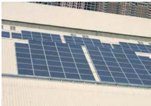
El campo solar ha sido colocado en las cubiertas de dos de las cuatro naves que existen, ya que poseen una inclinación y una orientación óptima (con una desviación respecto al Sur < 5°) para conseguir un máximo aprovechamiento de la radiación solar durante todo el año.
