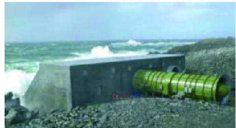
Figura 36. Columna de agua oscilante (OWC). Proyecto LIMPET (Escocia). Fuente: Wavegen (www.wavegen.co.uk) .
