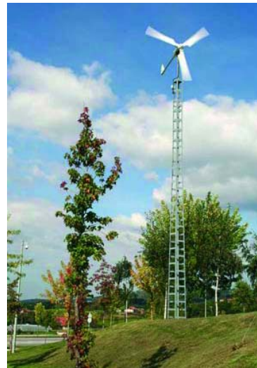
Figura 11. Aerogenerador de 6 kW. Fuente: LABEIN-TECNALIA.
