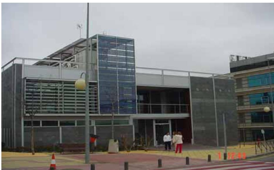
**Foto 8.** Instalación fotovoltaica integrada en muro cortina.
