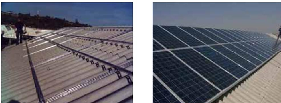
**Foto 4.** Estructura sobre tejado inclinado de uralita.
