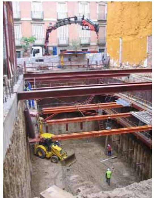
**Figura 17.** Construcción de un aparcamiento robotizado con 55 plazas bajo un edificio de nueva planta en el casco histórico. C/ Huertas 39, Madrid.
