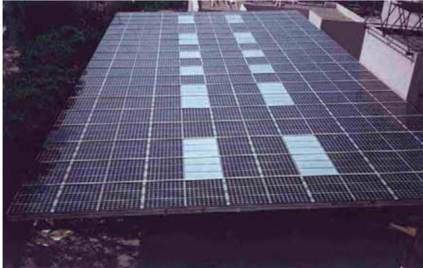
**Foto 9.** Instalación fotovoltaica integrada en cubierta.
