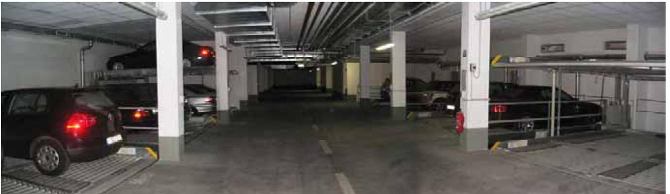
**Figura 18.** Aparcamiento semiautomático para residentes en un edificio de viviendas de nueva planta.
