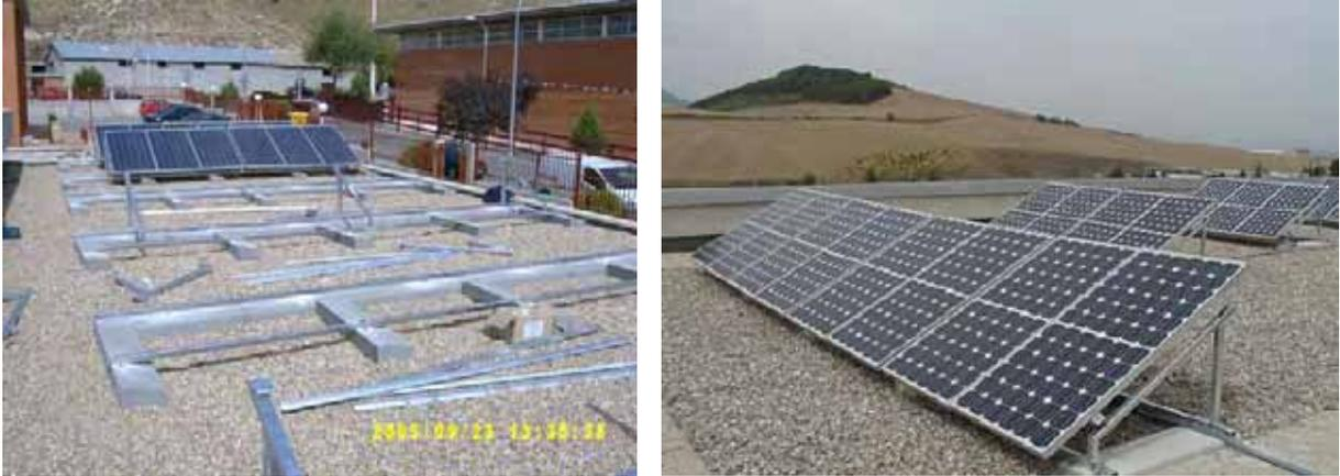
**Foto 6.** Sistema fotovoltaico sobre tejado plano no perforable.
