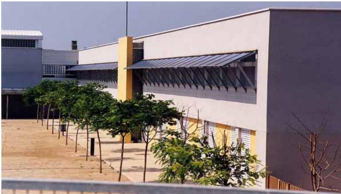
**Foto 11.** Instalación fotovoltaica integrada en parasoles.
