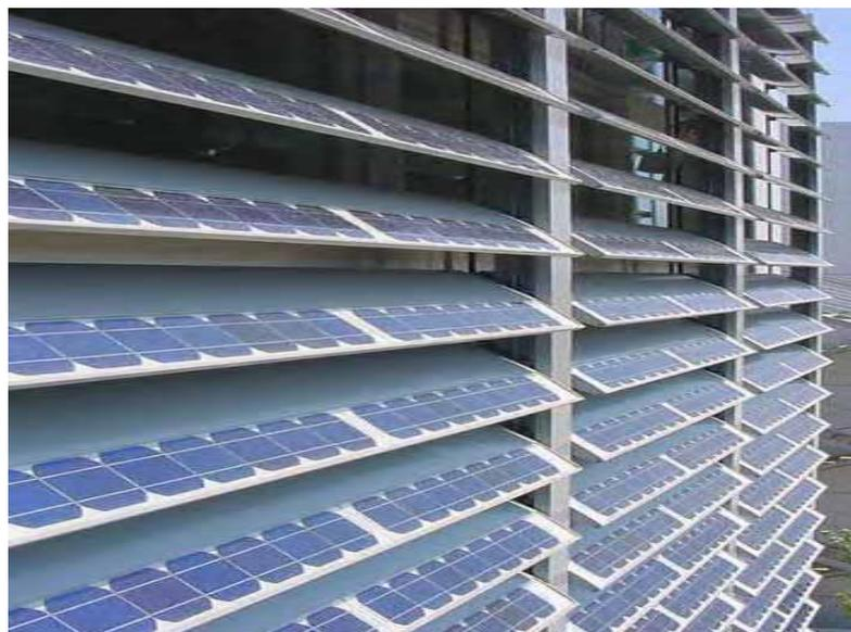
**Foto 10.** Instalación fotovoltaica integrada en lamas.
