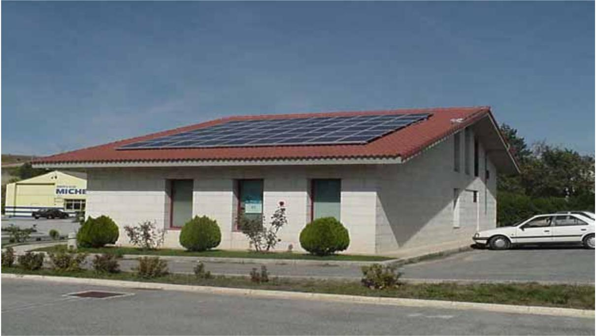
**Foto 3.** Sistema fotovoltaico sobre tejado inclinado.
