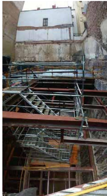
**Figura 16.** Construcción de un aparcamiento robotizado con 39 plazas bajo el patio de un edificio protegido en la C/ Santa Isabel, 21 (Madrid).
