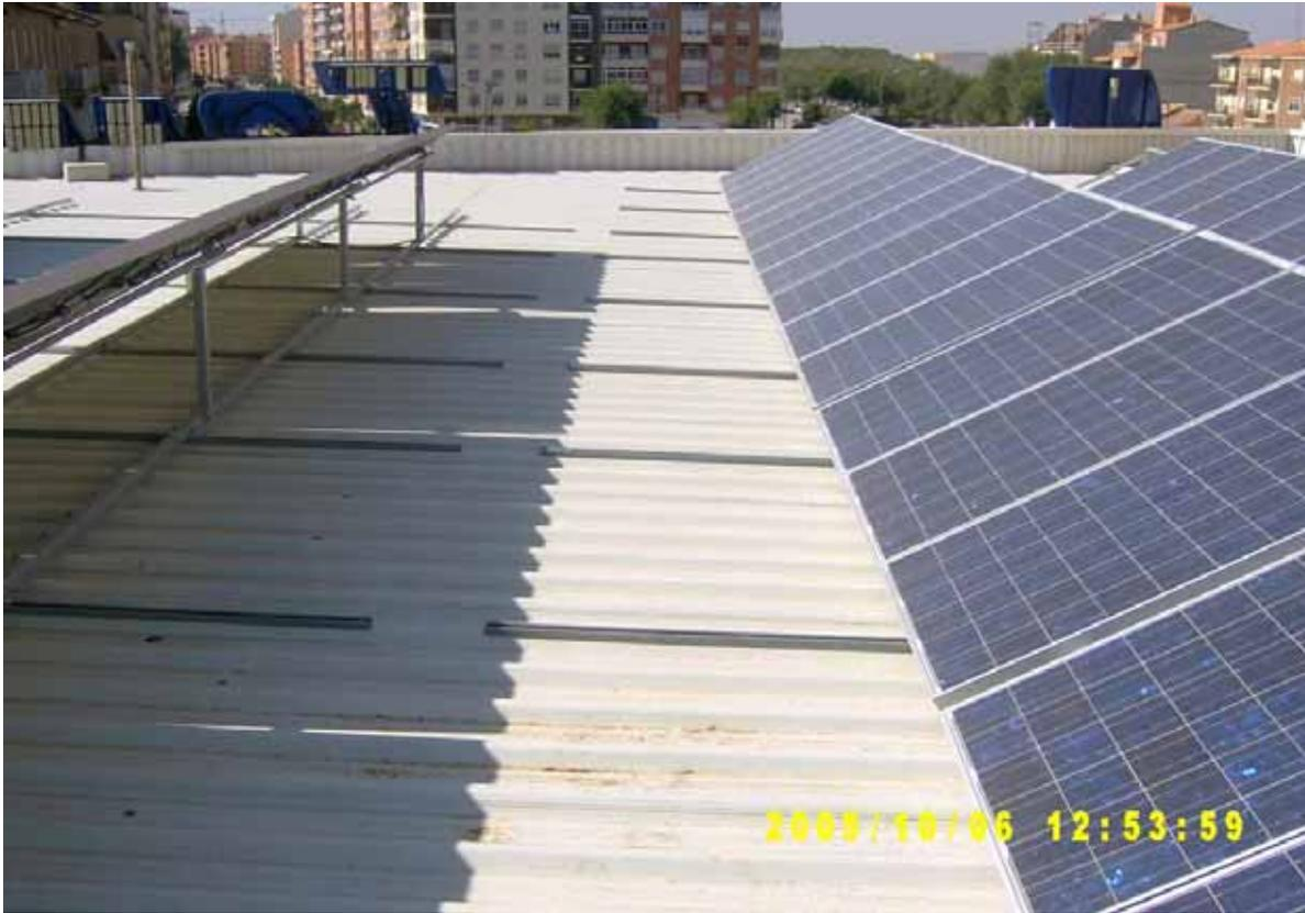
**Foto 5.** Estructura sobre tejado plano de uralita.
