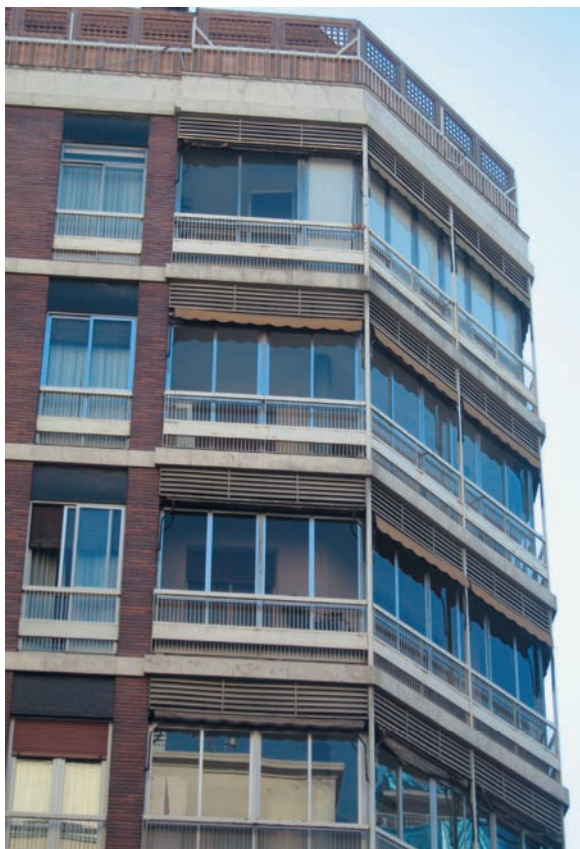
Foto 2. Rehabilitación de huecos de fachada.
