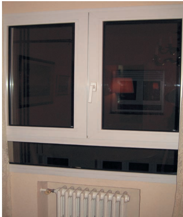
Foto 21. Carpintería PVC con doble acristalamiento banal.
