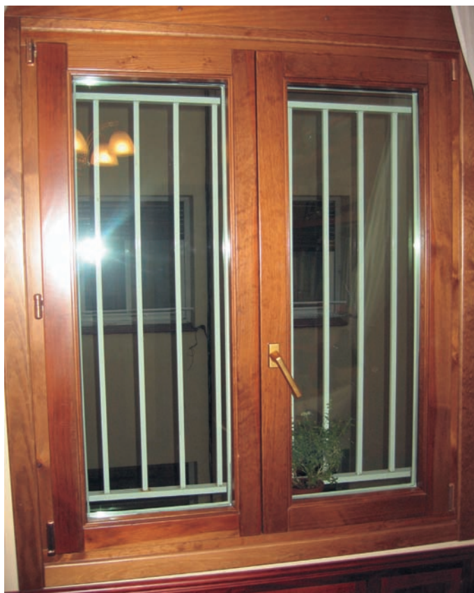
Foto 20. Carpintería de madera con doble acristalamiento bajo emisivo. SGG CLIMALIT con SGG PLANISTAR.
