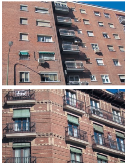
Foto 9. Situaciones dispares susceptibles de intervención.
