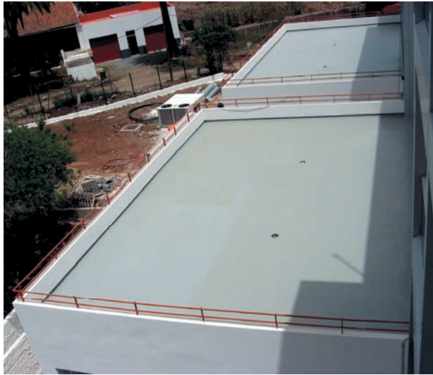
Foto 3. Cubiertas con sistema adherido.
