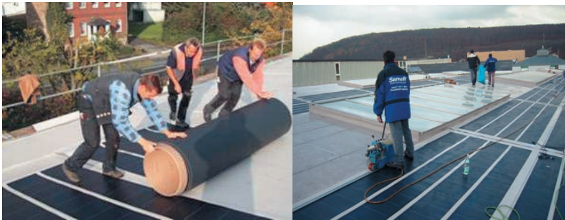
Figura 7. Montaje de los módulos-PV.
