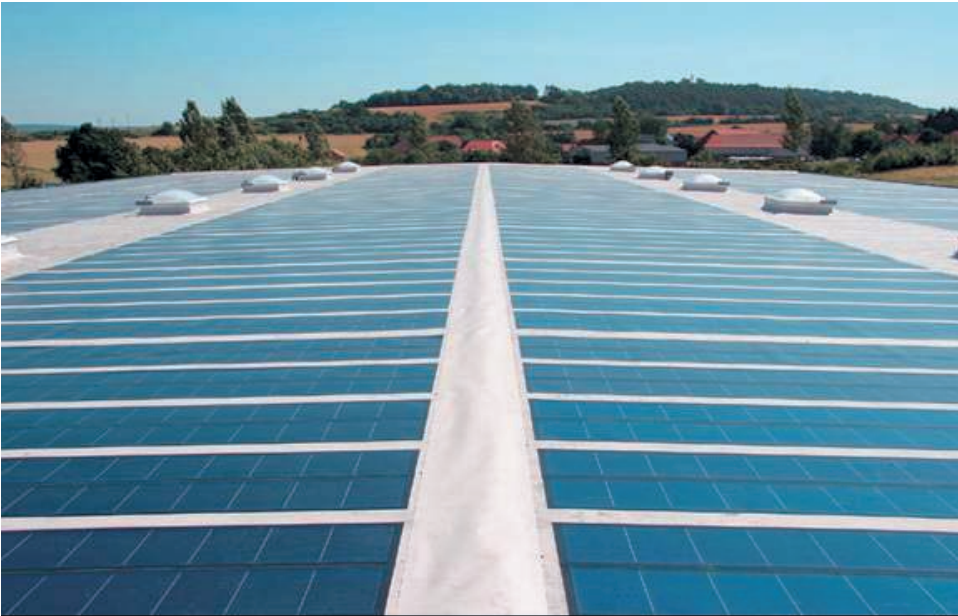
Foto 1. Cubierta solar terminada.
