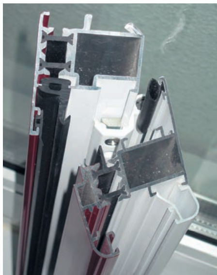
Foto 4. Carpintería metálica RPT. Sección característica.
