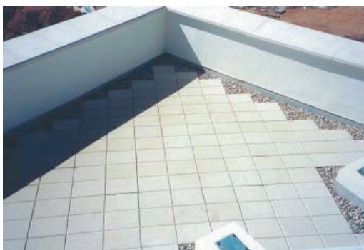
Foto 2. Cubierta invertida transitable.
