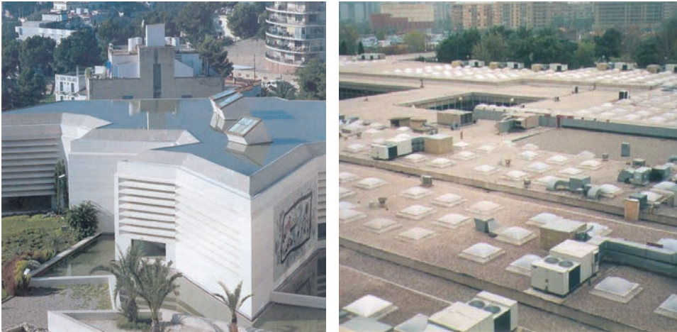
Foto 1. Cubiertas con protección pesada.
