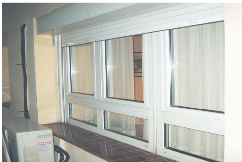
Foto 22. Carpintería PVC con doble acristalamiento bajo emisivo.
