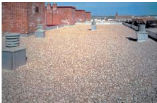
Foto 1. Cubierta invertida no transitable.
