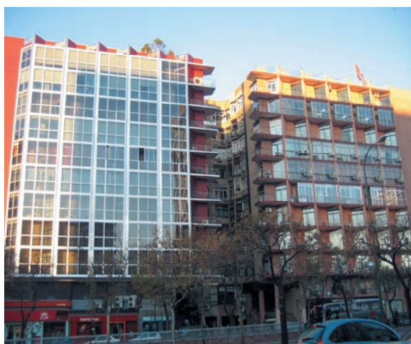
Foto 1. Rehabilitación total de huecos de fachada y situación inicial.
