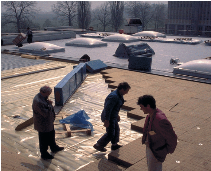
Foto 2. Cubiertas con fijación mecánica.
