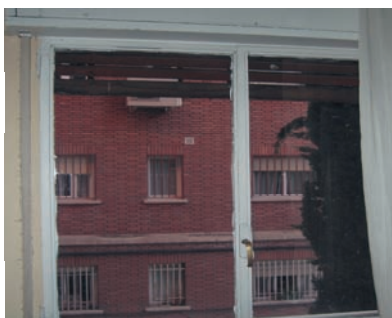
Foto 12. Carpintería metálica “acero Mondragón” con vidrio monolítico.
