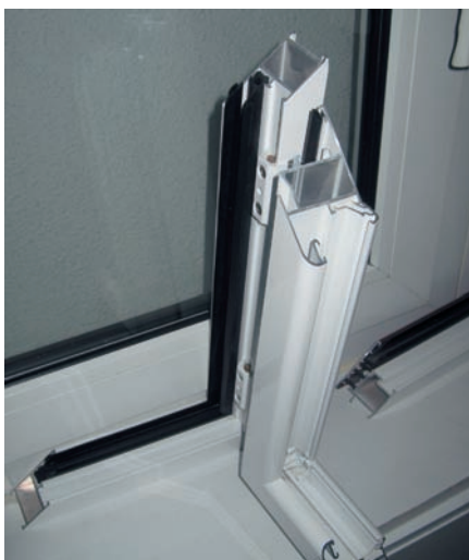
Foto 3. Carpintería metálica. Sección característica.
