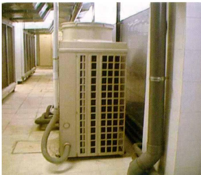
**Foto 4.** Condensador de un grupo de frío.
