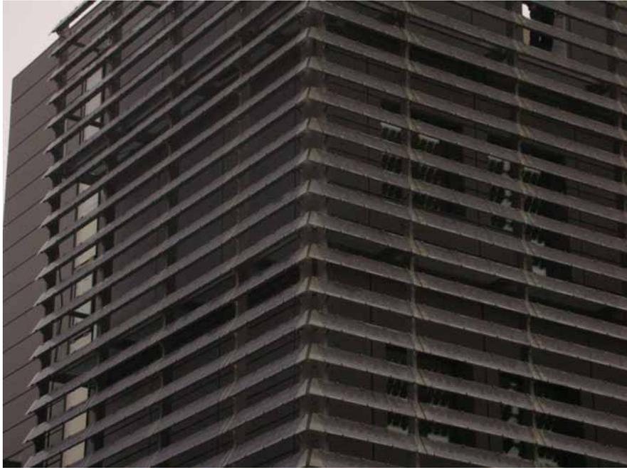
**Foto 1.** Lamas fotovoltaicas. Una forma de integración arquitectónica con generación de electricidad y protección solar del interior. Centro de Estudios del Alzheimer de la Fundación Reina Sofía.
