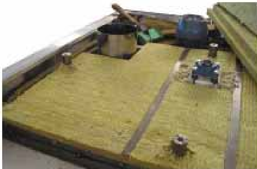
Figura 3. Aislamiento del techo.
