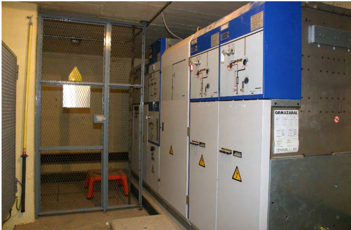
Foto 4. Control y regulación de calefacción y aire acondicionado.
