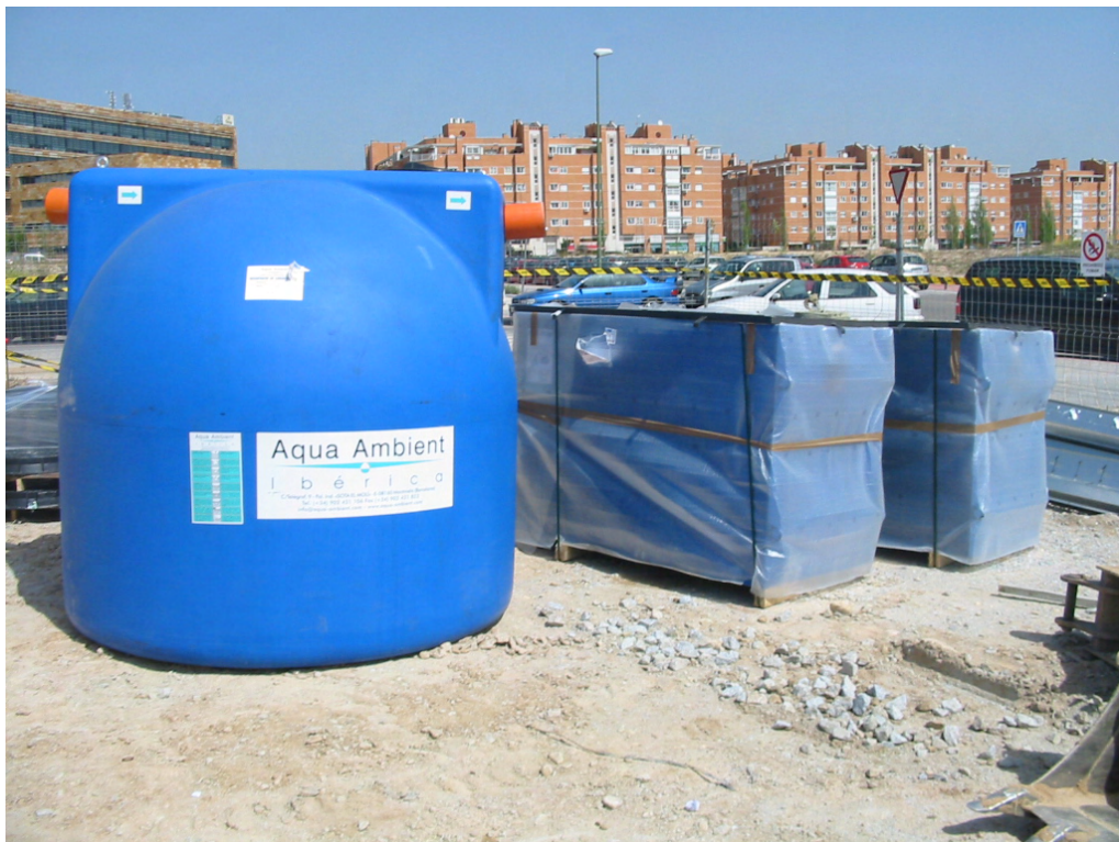
Foto 7. Separador de hidrocarburos.
