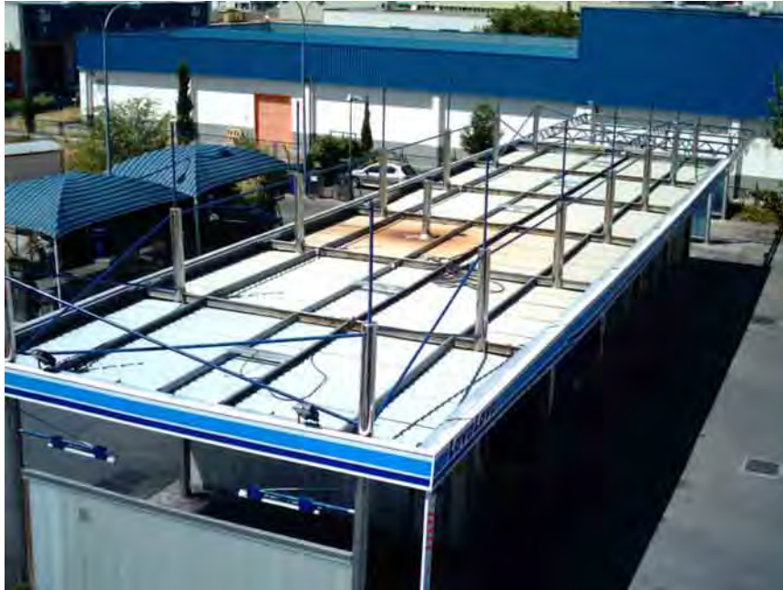
Foto 6. Instalación de paneles solares térmicos en un centro de lavado.
