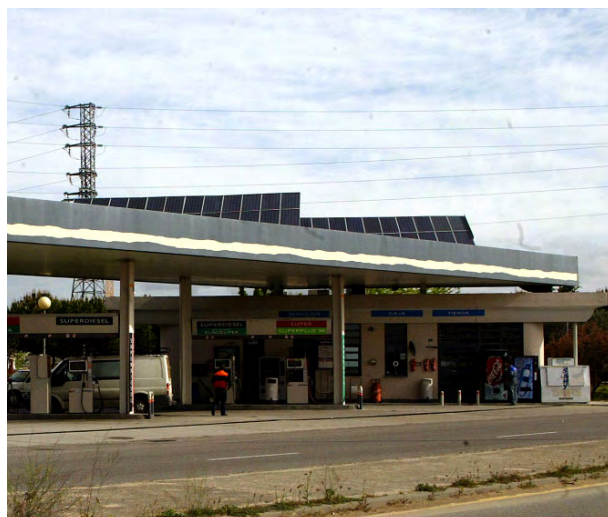
Foto 2. Estación de servicio.
