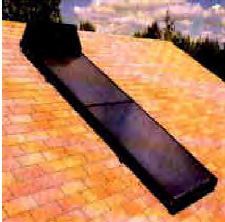
Figura 2. Colector solar térmico de baja temperatura.
