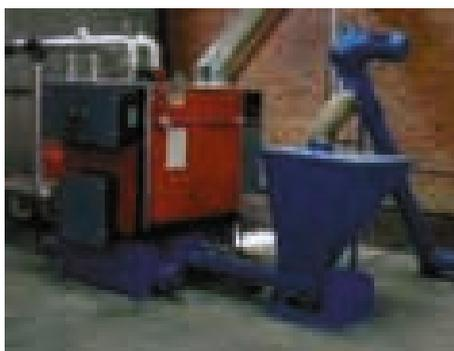
**Foto 15.** Caldera de pellets (admite otros combustibles) de 250 kW de potencia.
