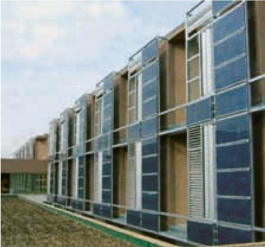
**Foto 2.** *Instalación fotovoltaica integrada.*
