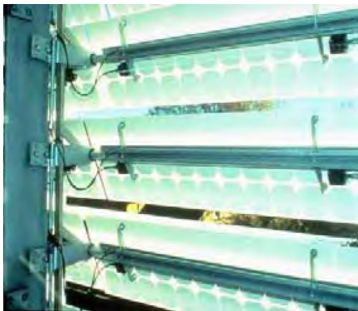
Foto 26. Detalles de las lamas fotovoltaicas del Edificio Winterthur (Alemania).
