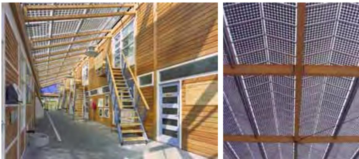
Foto 9. Cubierta acristalada con módulos fotovoltaicos.
