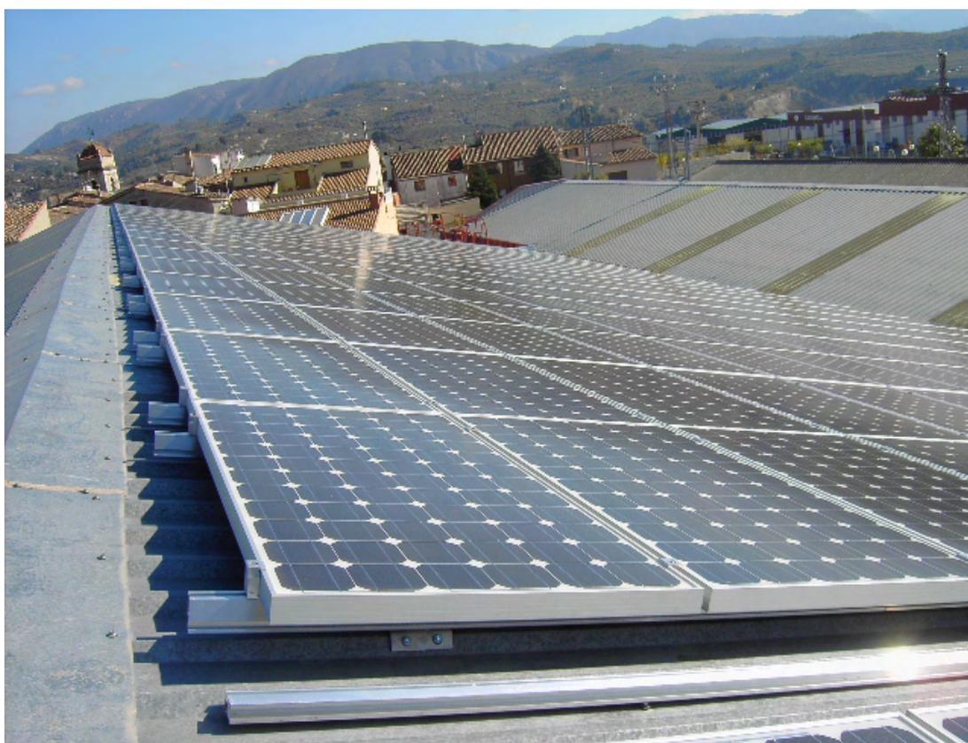
Foto 1. 94,8 kWp en Cocentaina (Alicante) realizada por Conergy- Enersol. Instalación realizada directamente sobre la cubierta.
