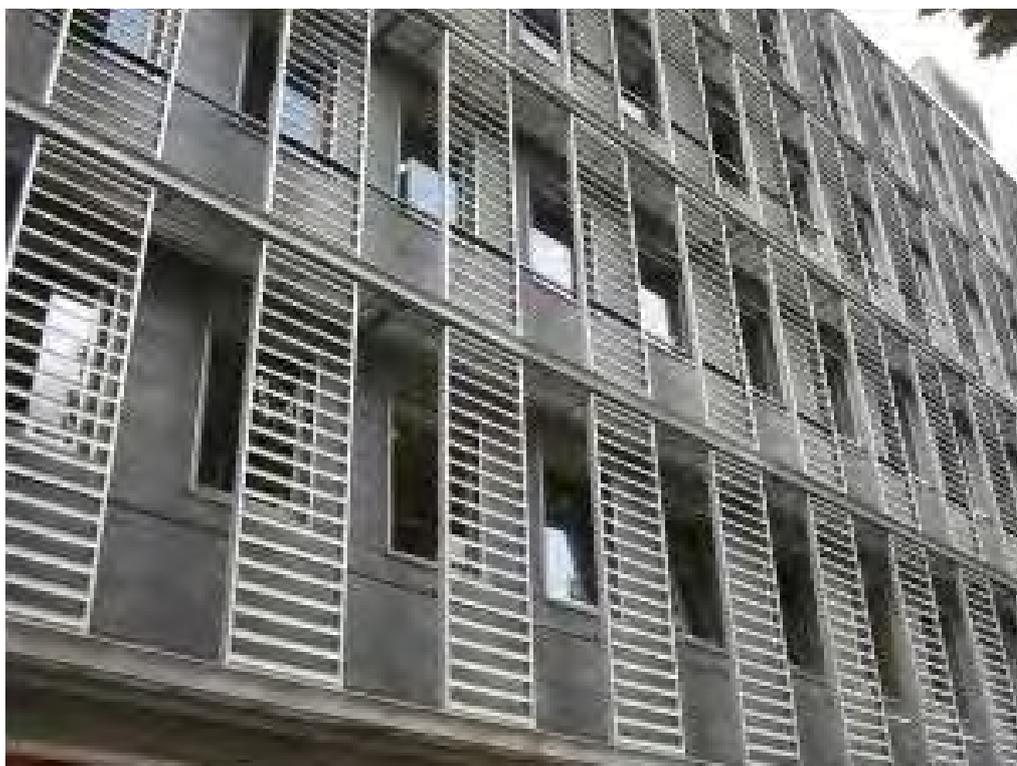
**Foto 32. Fachada ventilada del edificio Trasluz.**
