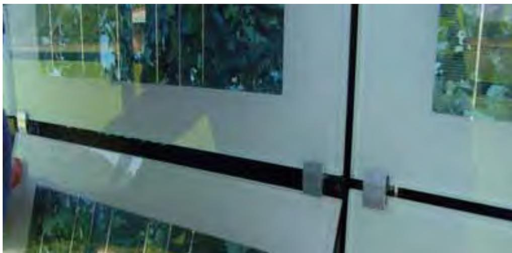
Foto 13. Imagen del fijador tipo clip.
