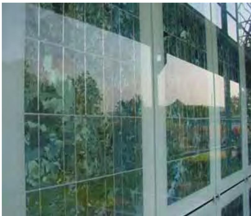
Foto 12. Fachada Fotovoltaica Verde del Polideportivo de Tübingen (Alemania) realizado por Conergy.
