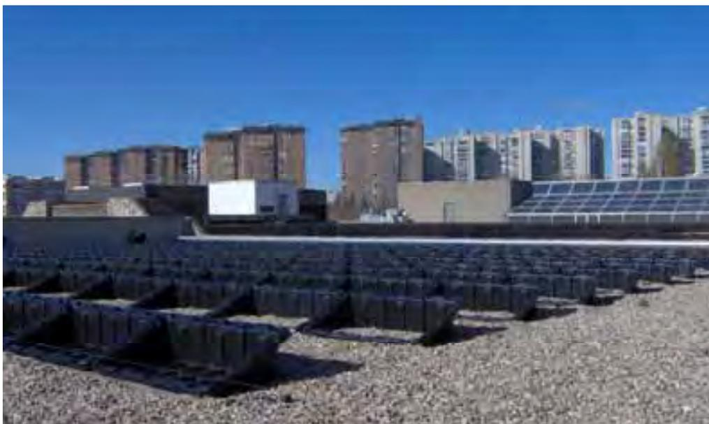
**Foto 44. Estructuras de los módulos fotovoltaicos del campo nº 1.**
