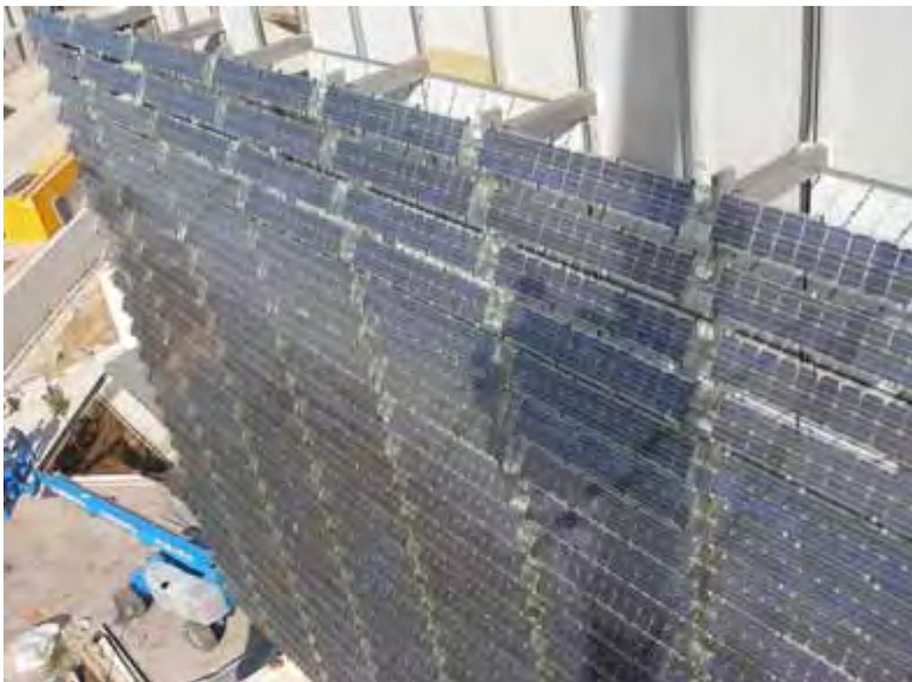
**Foto 38. Lamas fotovoltaicas instaladas en el edificio del Proyecto Alzheimer.**
