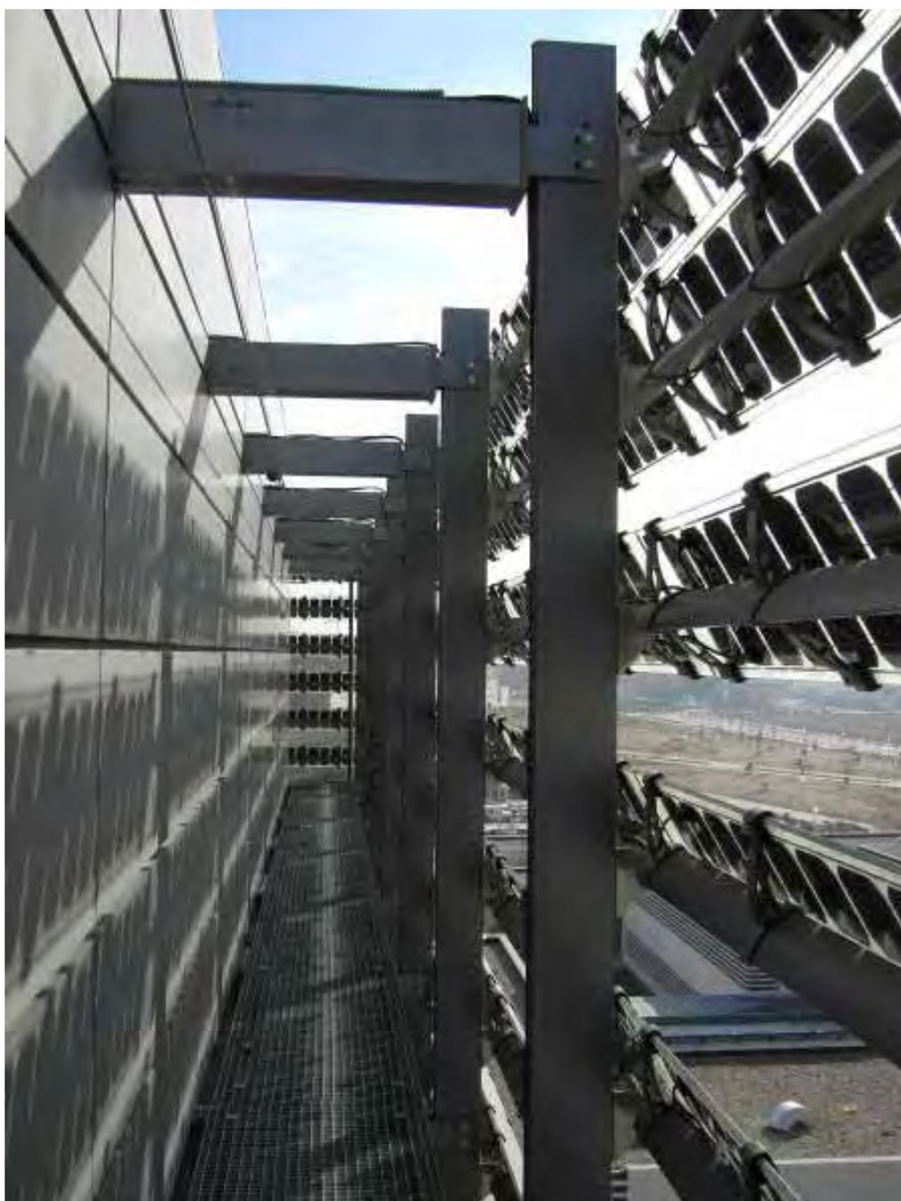
**Foto 39. Montantes verticales para la fijación de las lamas fotovoltaicas.**
