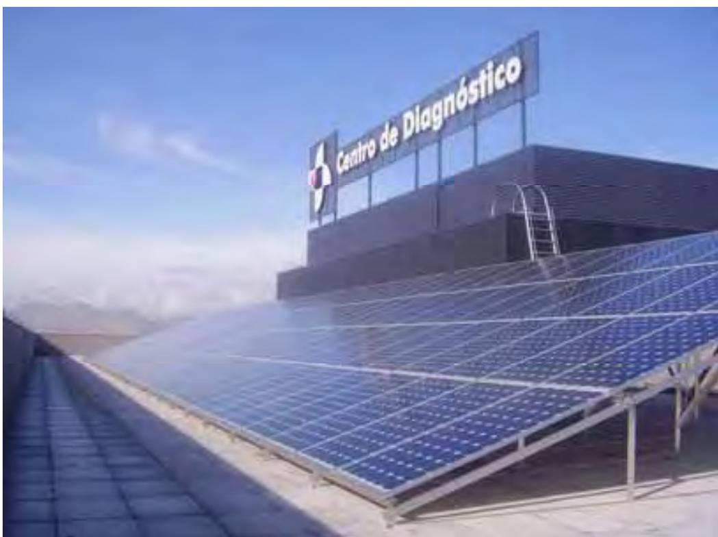
Foto 5. Instalación FV de 34,6 kWp en Granada de Conergy.
