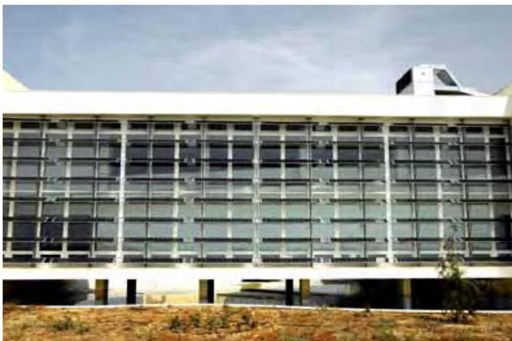
*Vinyl Acetate*) que, entre otras cosas, actúan como una barrera contra la humedad. En la parte anterior se ha colocado un cristal de 8 mm y en la posterior una lámina Tedlar traslúcida para tener un equilibrio entre el sombreado del edificio y la luz natural que dejan pasar los módulos al interior del edificio.
