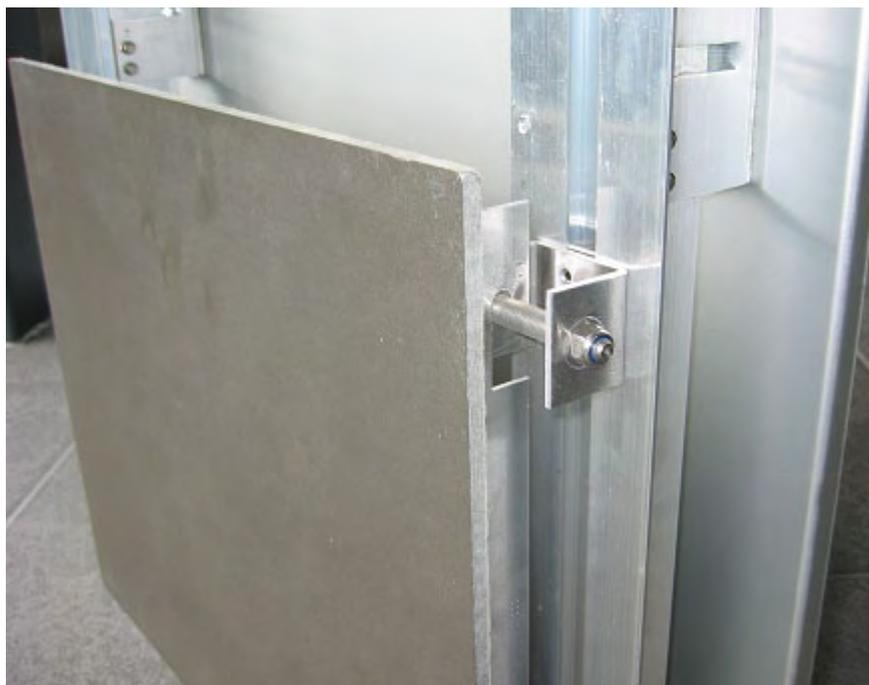
Foto 18. Sistema modular para fachadas ventiladas.
