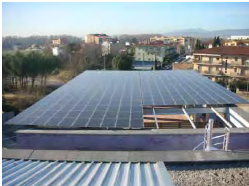
Foto 7. Instalación FV en Girona con módulos de capa fina.
