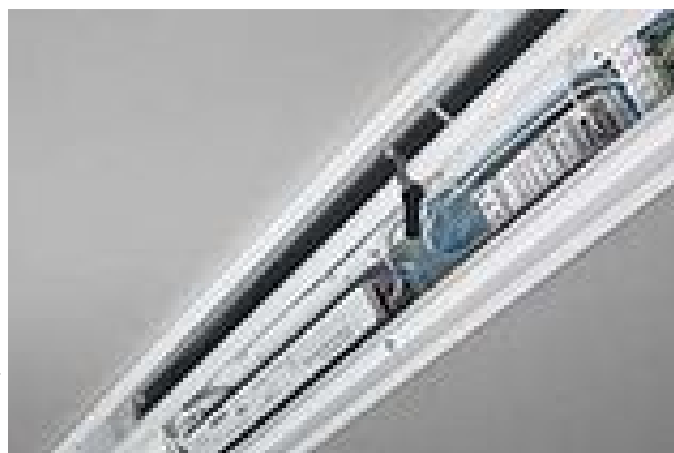
Foto A3.9. Luminaria integrada con sistema DALI (Fuente: Ammann Yanmar).
