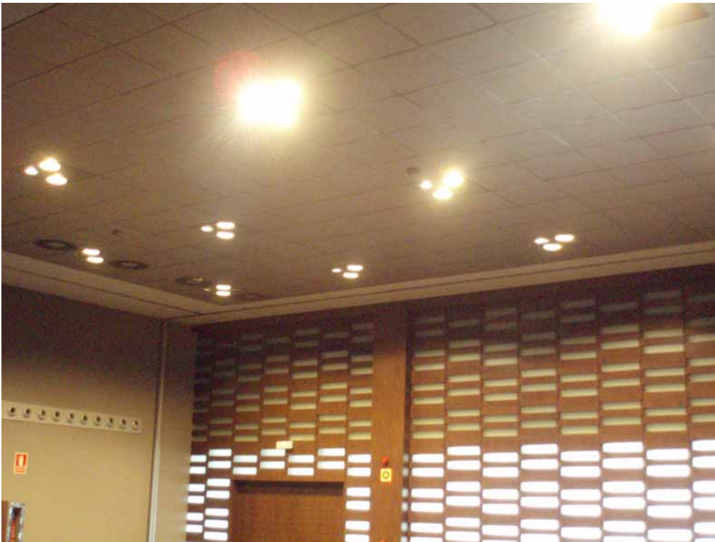
Foto 3.10. Sala de conferencias en el hotel Madrid Norte (Fuente: Rafael Hoteles).
