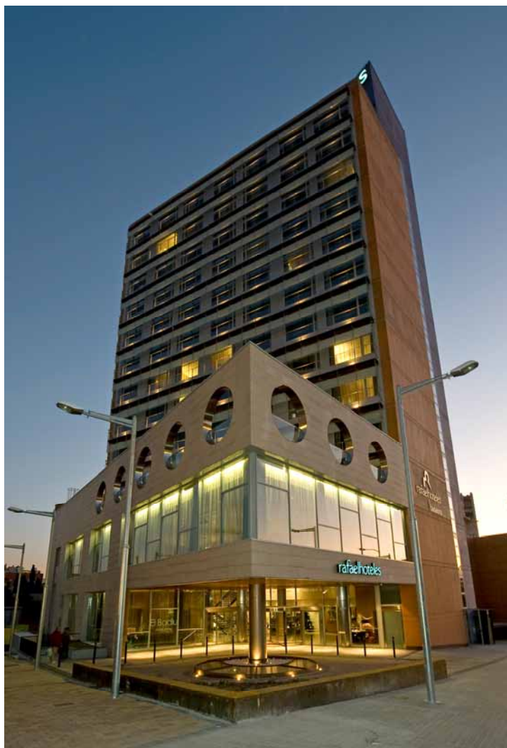
Foto 3.5. Fachada principal del hotel Rafael Badalona (Fuente: Rafael Hoteles).
