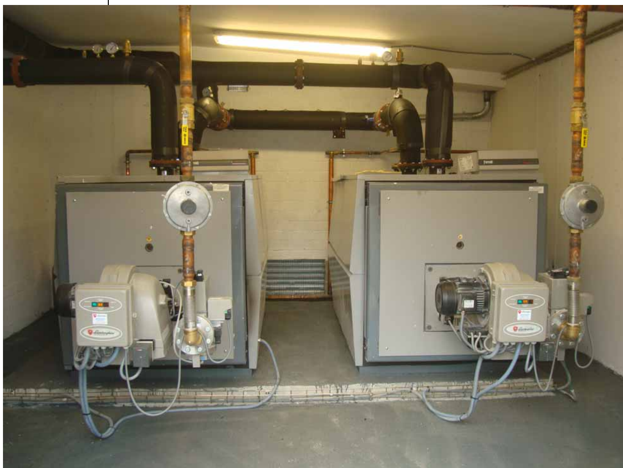
Foto A1.2. Grupo de calderas típicas para instalaciones hoteleras (Fuente: Ferrol).
