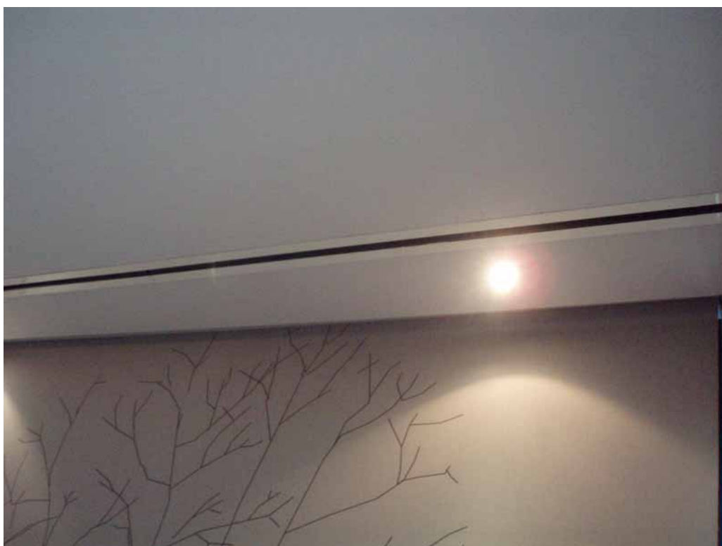
Foto A2.10. Rejilla lineal de climatización en habitación de hotel (Fuente: Rafael Hoteles).
