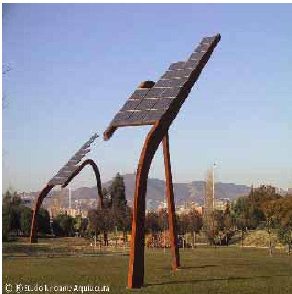
Foto 14. Planta generadora Dinosaurio instalada en Hospitalet de Llobregat (Fuente: Siarq).
