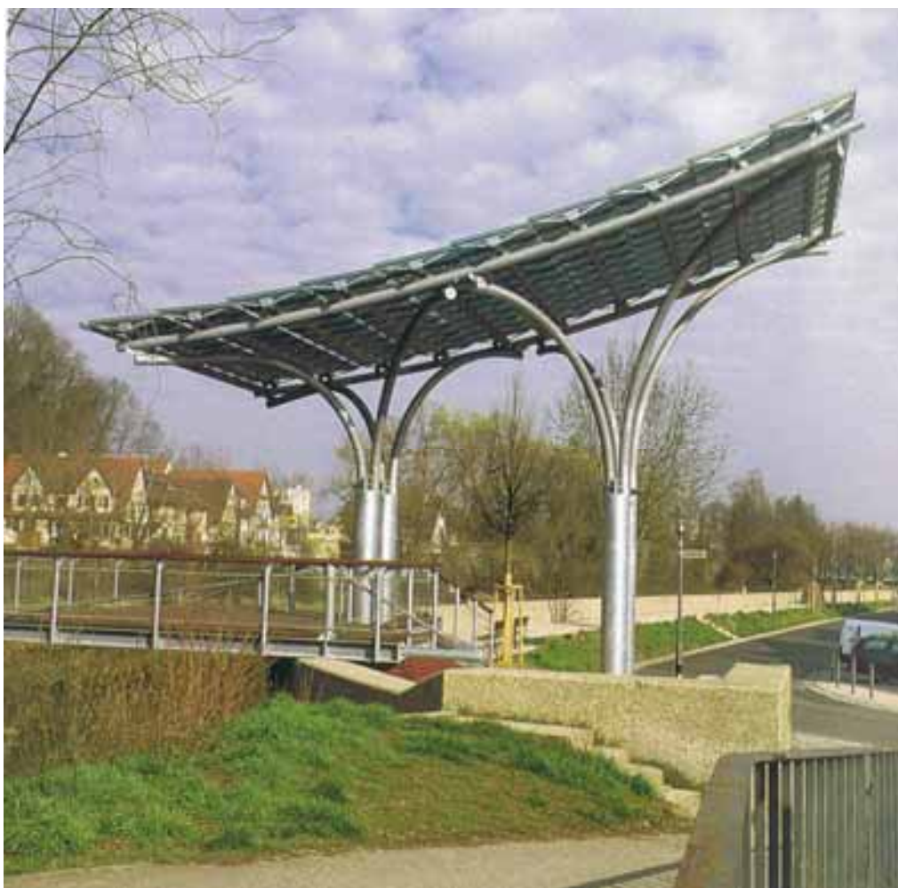
Foto 4. Techo panorámico solar multifuncional ubicado en Remseck, Alemania (Fuente: Würt Solar).
