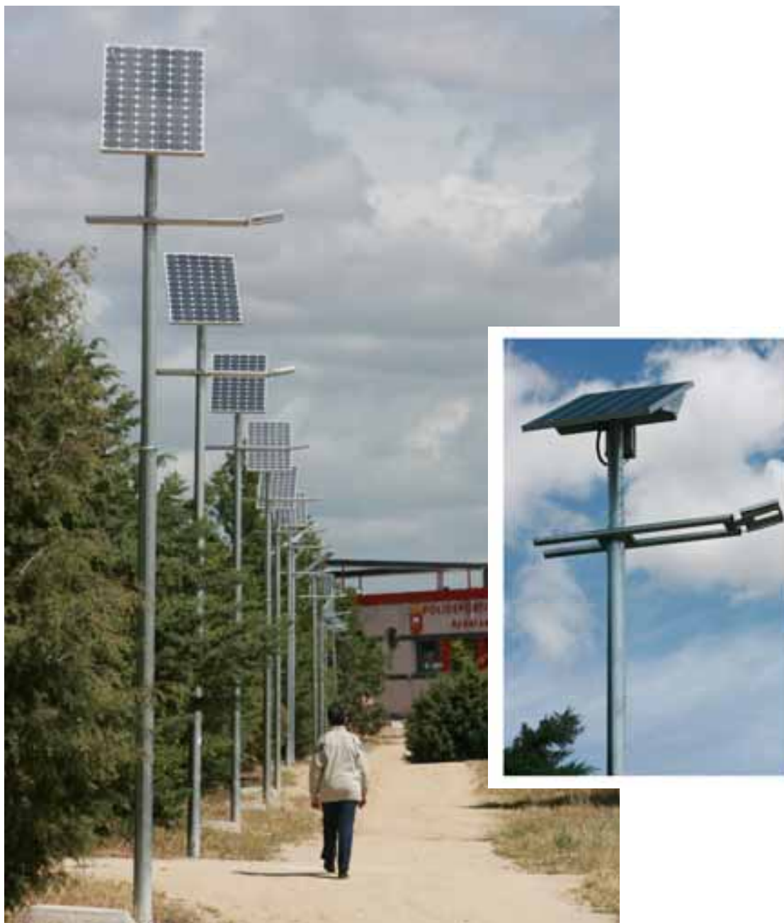
Foto 7. Farola fotovoltaica modelo Isoled I de Isofoton (Fuente: Ayuntamiento de Tres Cantos).
