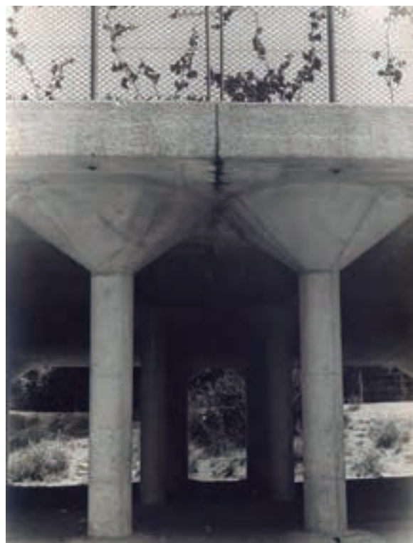
Detalle del puente [CEDEX, I/FC-003/094].
