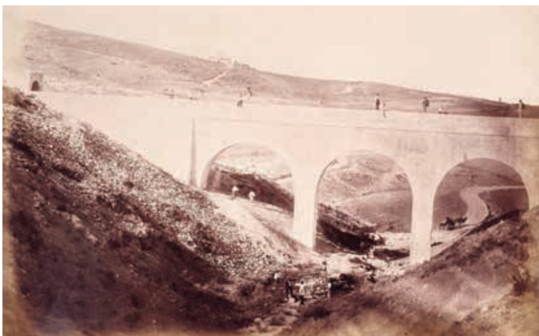
Puente acueducto de Valcaliente, Charles Clifford, 1856. 17/LF/100 (14), BNE.
