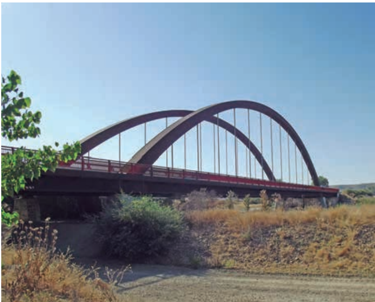
[Fig. 44] Puente de Titulcia sobre el río Jarama, Comunidad de Madrid (92m de luz).
