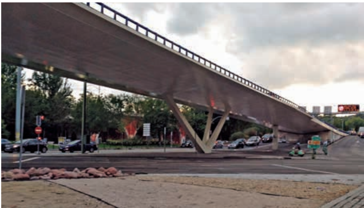
[Fig. 39] Paso sobre la avenida de Valladolid cerca del puente de los Franceses, Madrid, 1998 (42m de luz máxima).
