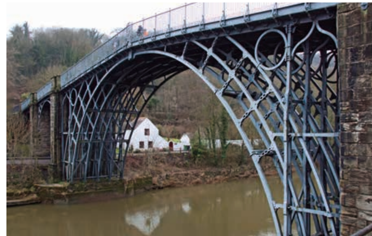
[Fig. 2] Puente de Coalbrookdale sobre el río Severn, Inglaterra (30m de luz).
