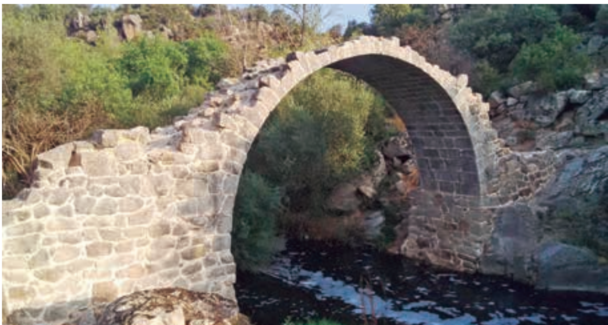
[Fig. 12] Puente de Alcanzorla sobre el río Guadarrama, Comunidad de Madrid (8,80m de luz).
