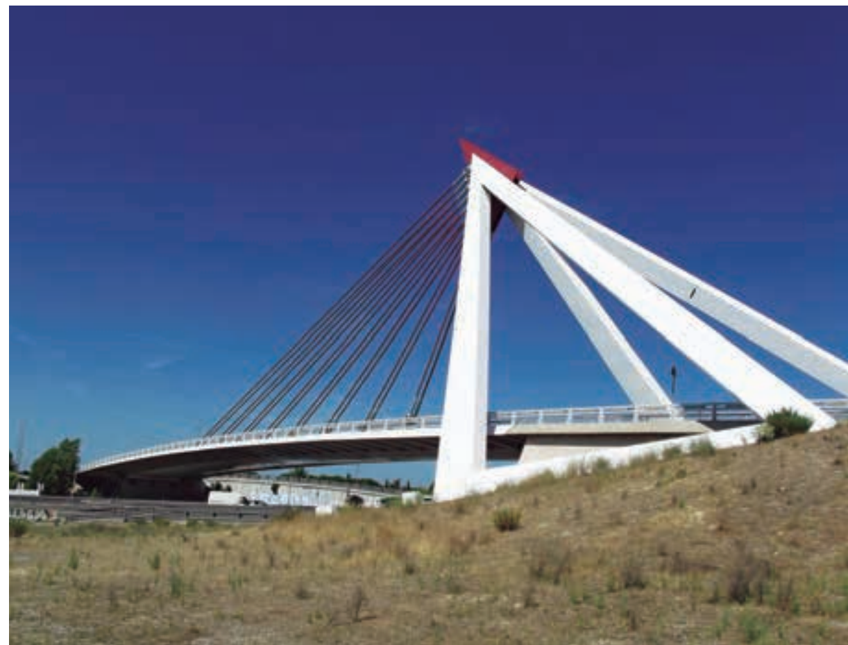
[Fig. 9] Puente 'Puerta de Las Rozas' sobre la autovía del Noroeste A-6, Comunidad de Madrid, 2007 (102m de luz).
