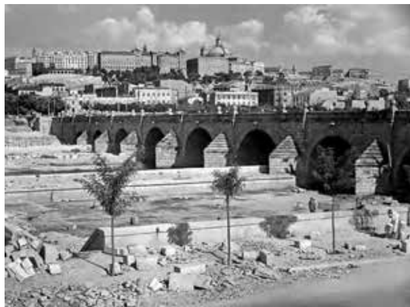
Obras de canalización del Manzanares a finales de los años cuarenta. Manuel Urech.
