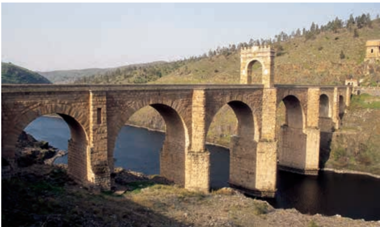
[Fig. 10] Puente romano sobre el río Tajo en Alcántara, Cáceres (28,80m de luz máxima).
