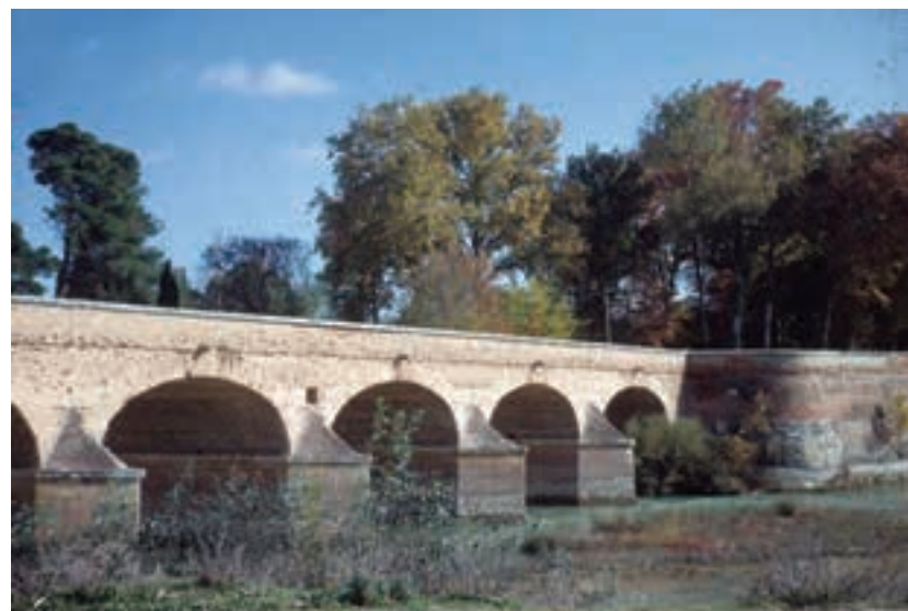
[Fig. 24] Puente Largo de Aranjuez sobre el río Jarama, Comunidad de Madrid, 1781 (7,50m de luz).
