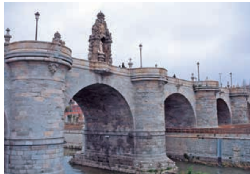
[Fig. 22] Puente de Toledo sobre el río Manzanares antes de la canalización, Madrid, 1732 (11m de luz).
