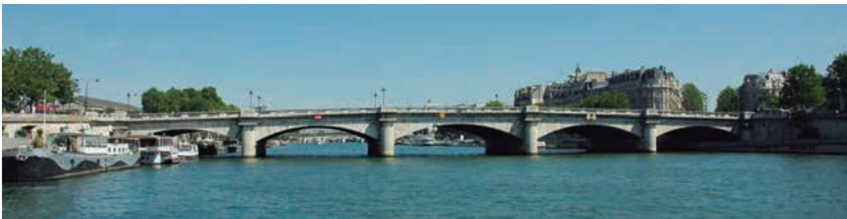
[Fig. 3] Puente de la Concorde sobre el río Sena, París, 1791 (31m de luz).
