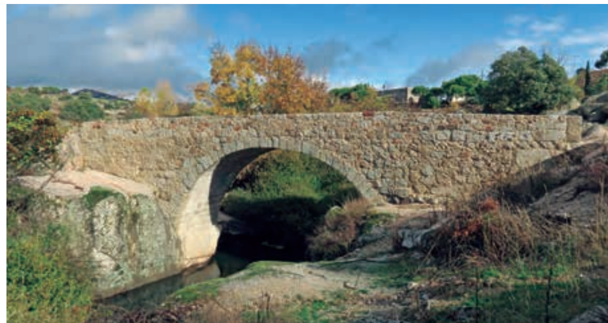
[Fig. 13] Puente del Batán sobre el río Manzanares, Comunidad de Madrid (10,50m de luz).
