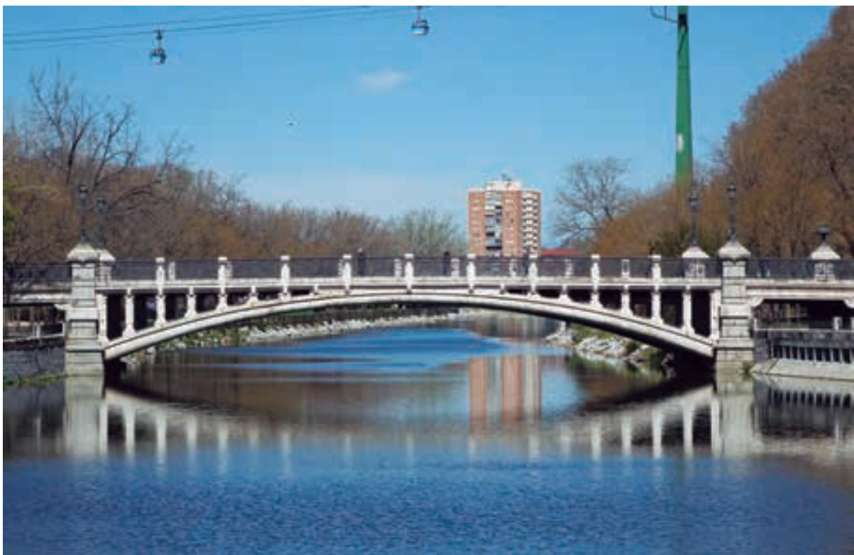
[Fig. 7] Puente de la Reina Victoria, sobre el río Manzanares, Madrid (30m de luz).
