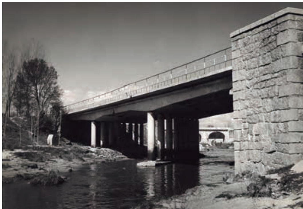
Vista del puente [CEDEX, I/FC-003/039].
