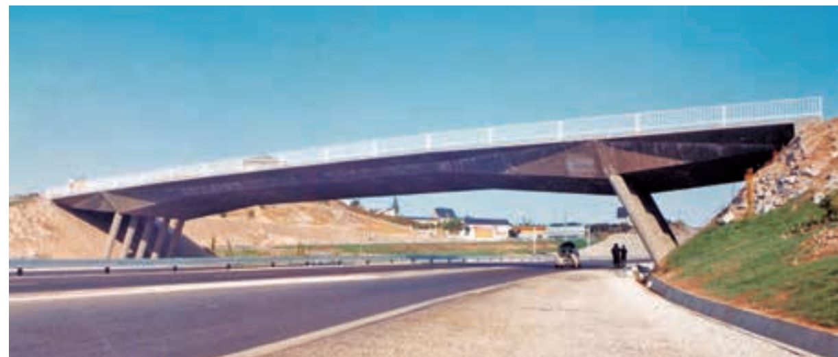
[Fig. 40] Paso sobre la autovía del Noroeste A-6 en Villalba, Comunidad de Madrid, 1964 (50m de luz).
