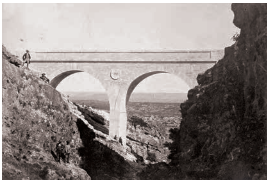
Puente acueducto de las Cuevas. Charles Clifford, 1855. 17/LF/100 (5), BNE.
