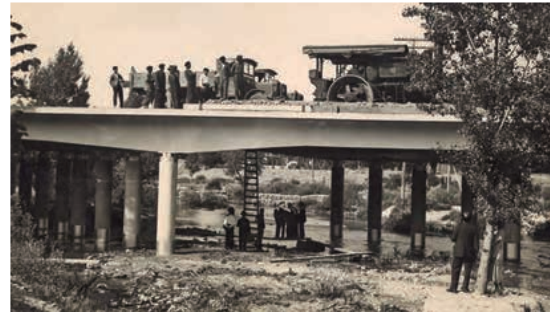
Puente en Puerta de Hierro sobre el río Manzanares. Vista del puente con personas y vehículos [CEDEX, I/FC-003/101].
