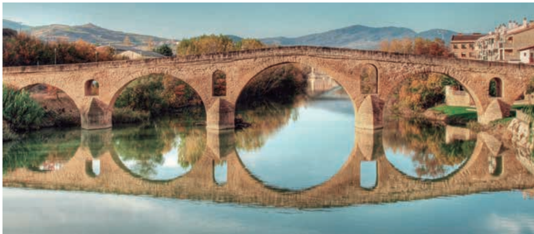
[Fig. 14] Puente la Reina sobre el río Arga, Navarra, siglo XI (25m de luz máxima).
