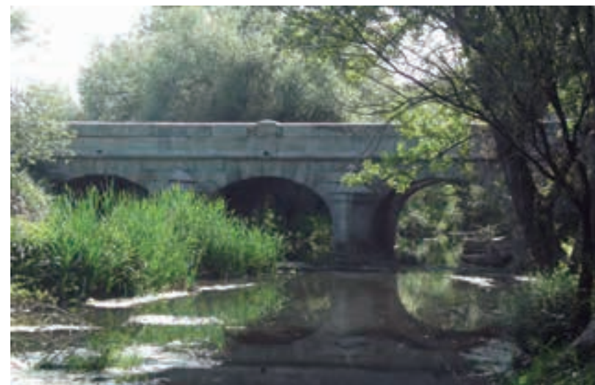
[Fig. 26] Puente del Herreño sobre el río Guadarrama, Comunidad de Madrid, siglo XVIII.
