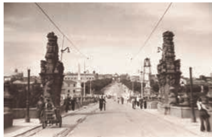
Puente de Toledo en obras (1952), de Cultura.
