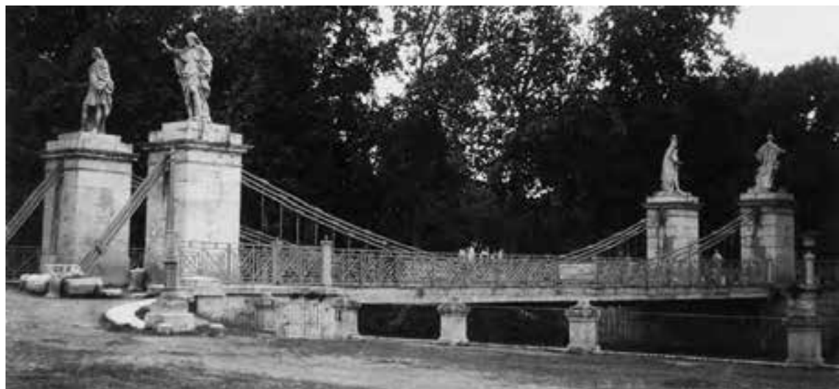
[Fig. 30] Puente de Aranjuez sobre el río Tajo, Comunidad de Madrid, 1833 (35m de luz).
