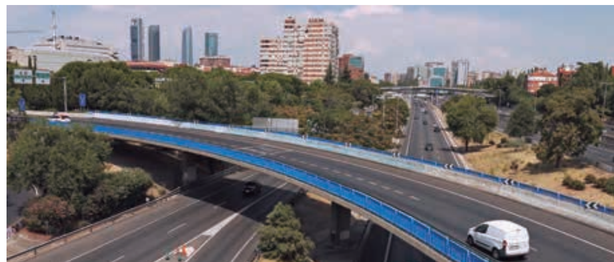
[Fig. 42] Paso del eje Cuzco Barajas sobre la autopista M-40, Madrid, 1976 (48m de luz máxima).
