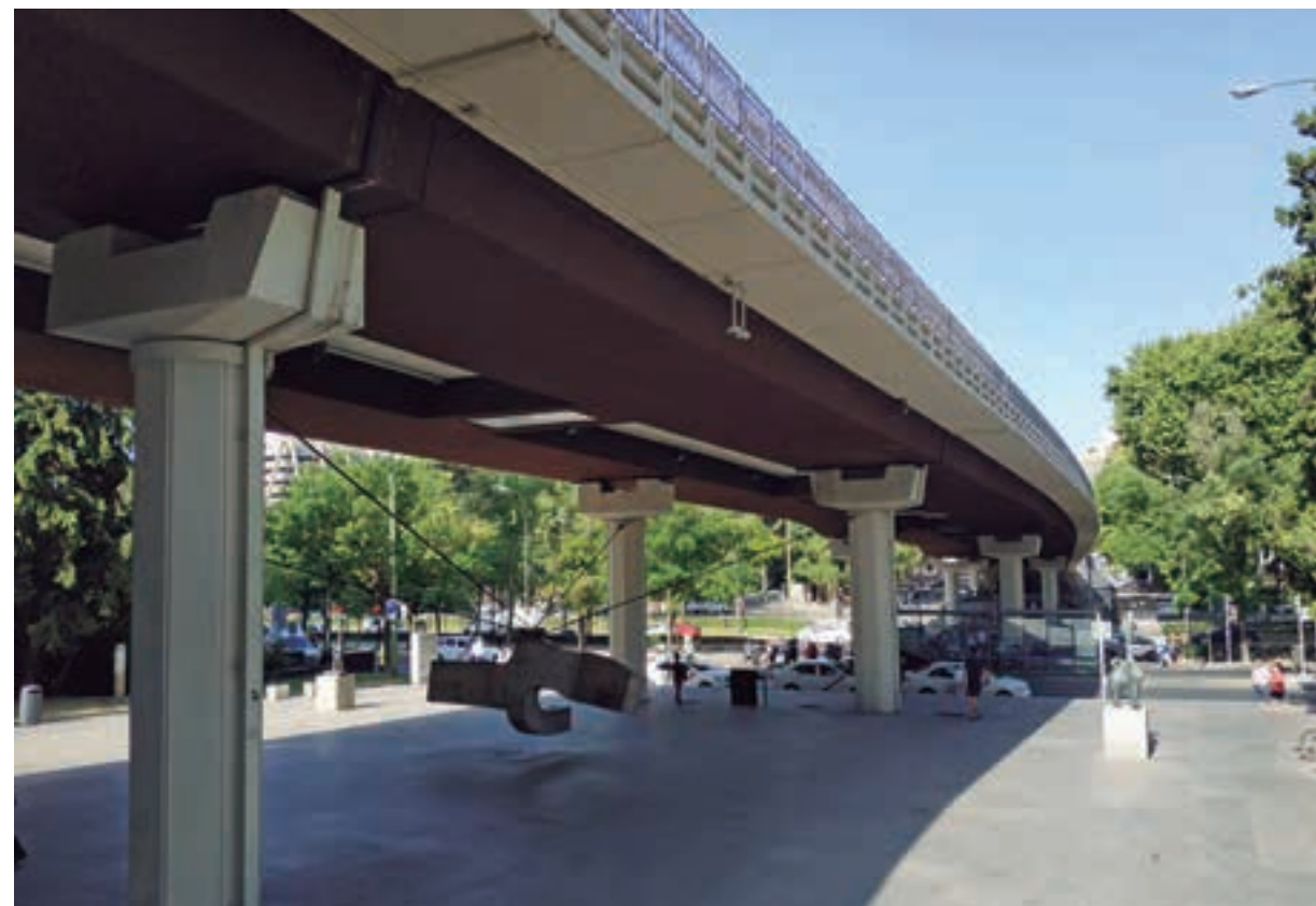
[Fig. 38] Paso sobre el paseo de la Castellana, Madrid, 1970 (38,70m de luz máxima).
