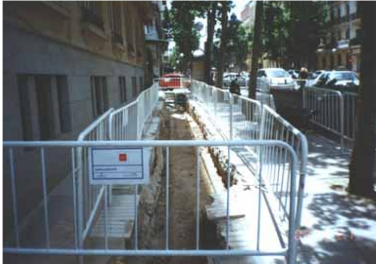
En zanjas en casco urbano las protecciones para los peatones deben mantenerse hasta la reposición del pavimento
