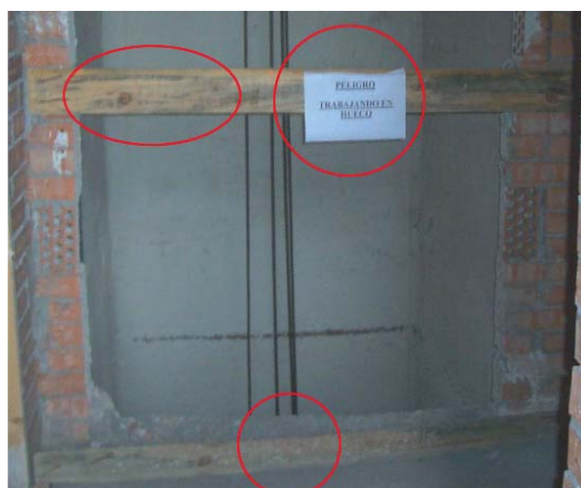
Barandilla, rodapié y señalización. A menudo nos encontraremos en las obras situaciones similares a la mostrada en la fotografía. Se recomienda protecciones colectivas metálicas y señalización normalizada.
