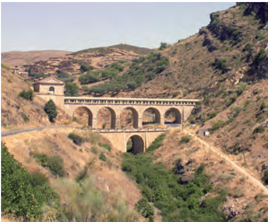
El sifón de Patones del Canal de Isabel II, dentro de la red de distribución de la presa de El Pontón de la Oliva
