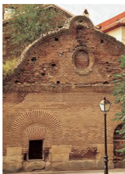
La bodega del Arrabal, junto al arroyo de Valdejudíos
