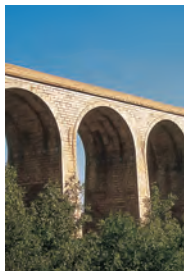
Viaducto de la línea de ferrocarril Madrid-Burgos
