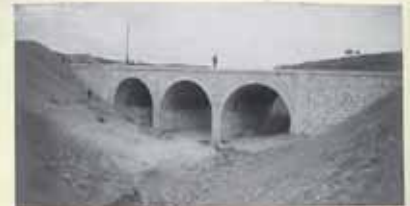
Canal Transversal: Frente a los muros de la Alameda No. 20
