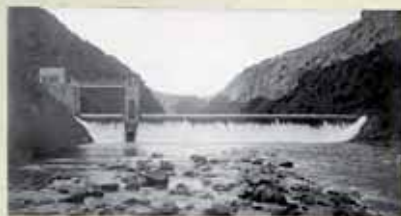
Rio Leroya. Presa de "La Berro" Km. 18
