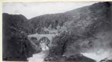
Puente construido sobre el Rio Losoya 1914
