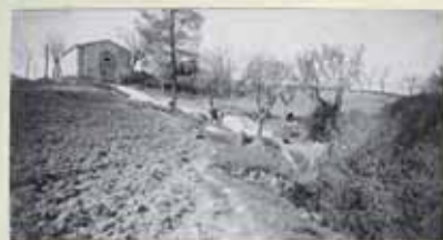
Fuente del Abadial, Camino de entrada de Agón Km 24
