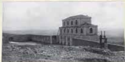
Entrada de agua en el dique y principio del canal. No. 12
