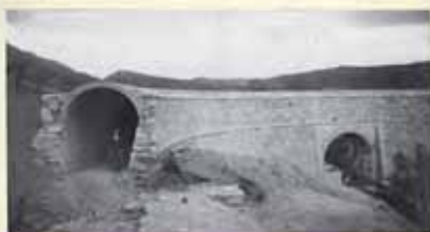
Canal Transversal: Frente a los muros de la Alameda No. 17
