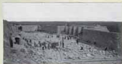
Canal Transversal. Espigón regulador y compuertas. No. 11
