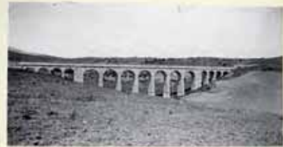
Puente acueducto de Colmenaraje
