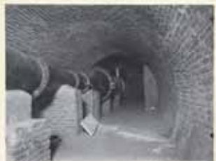
Deposito elevado - Galvan de agua sulfada "Gallati"
