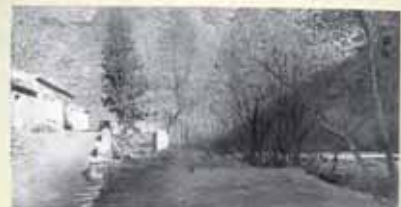
Rio Leroya. Presa de "Amarillas" Km. 11
