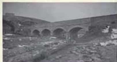
Sifón de "St. Marcial" - Pineda aguas abajo Km 21
