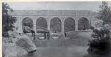
Canal Transversal: Frente a los muros de la Alameda No. 17
