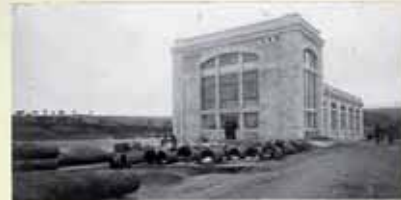
Canal Transversal. Casa de máquinas. No. 18
