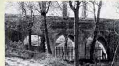
Fuente acueducto de La Traviaca
