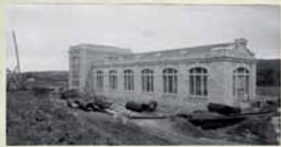
Canal Transversal. Casa de máquinas. No. 17
