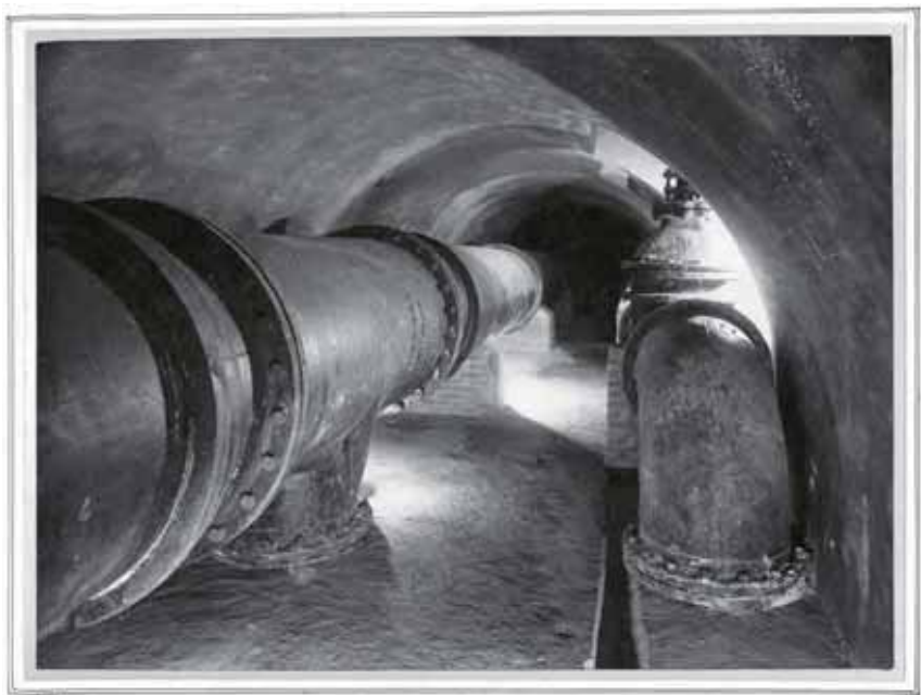
Nº 1. ORIGEN DE LA TUBERIA DE 600 mm. EN EL TERCER DEPÓSITO.
