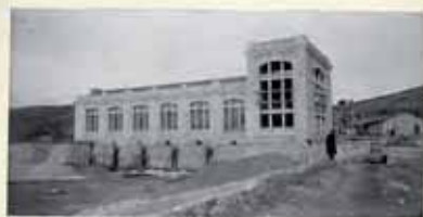
Canal Transversal. Casa de máquinas. No. 16
