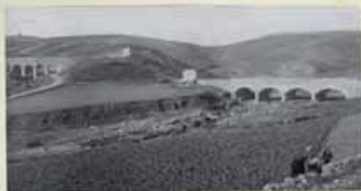
Sifón de "St. Marcial" Km 21
