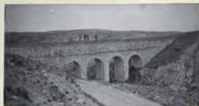
Fuente acueducto de "El Regañuelo"
