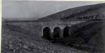
Fuente acueducto de "La Casa y Calinayas" Km. 10
