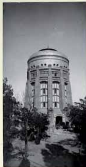
Madrid Deposito elevado
