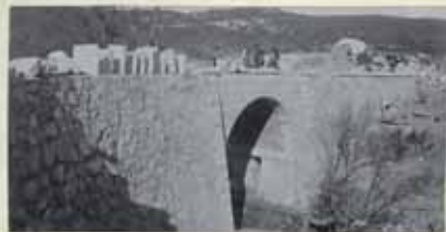
Canal Transversal: Frente a los muros del puente No. 16
