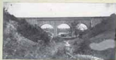
Puente acueducto de Valcaliente Km 33
