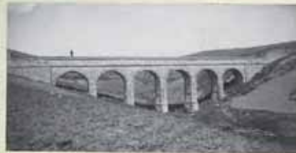
Fuente acueducto de Cabeza-Cana Km 22
