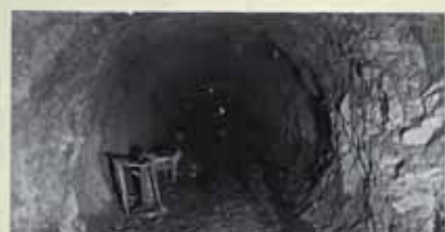
Canal Transversal: Frente a los muros del puente No. 19
