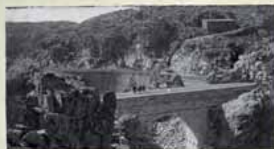
Dique del Canal Transversal 1914
