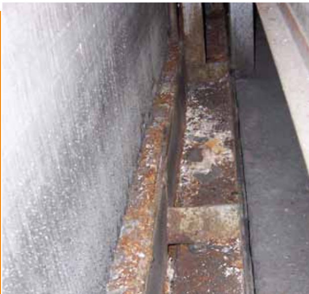
Fotografía: Suciedad en bandeja de condensados. Paulino Pastor.
