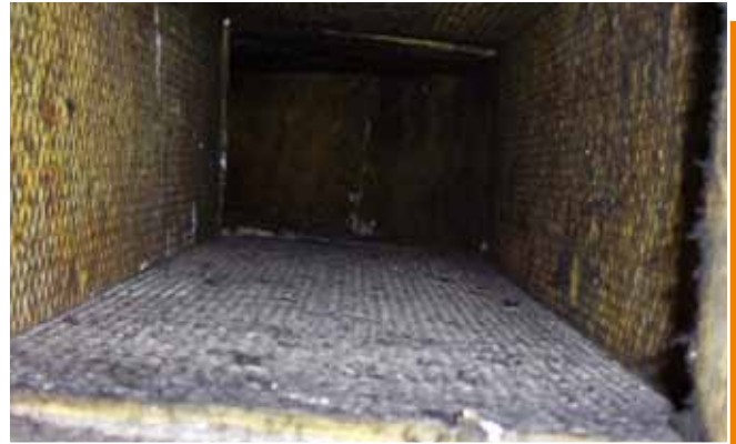
Fotografía: Fibras de vidrio en conductos de aire. Paulino Pastor.
