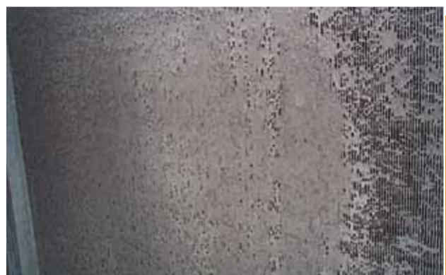
Fotografía: Batería de frío del sistema de climatización contaminada. Paulino Pastor.
