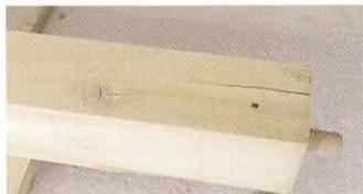
Tubo de un Subbajo 16' con roturas en la parte superior y desajustes del tapón debidos a la sequedad y el calor, tras su cepillado y previo a su restauración. (Santiago Orta)
