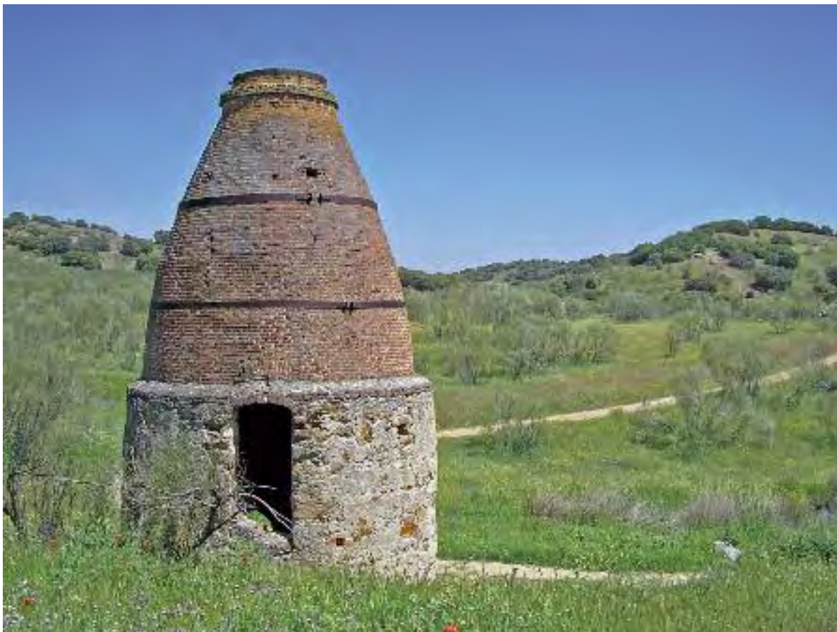
Fig. 7.- La chimenea de la pequeña fábrica Ordovás, situada junto a caleras explotadas de antiguo, es la construcción más característica en las "Casas del Vétago" (Valdemorillo). Sobre el cerro se localiza una de las casamatas del plan 69-B. Fotografía: Pablo Schnell.
