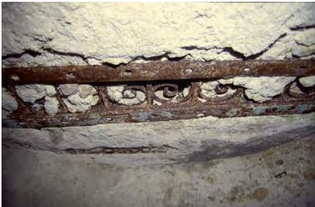
Fig. 123.- Ni siquiera los nidos estandarizados del Plan 69-B escaparon a la penuria de medios. En el interior de este ejemplar de Valdemorillo se usó una verja como armadura. Fotografía: Ricardo Castellano.
