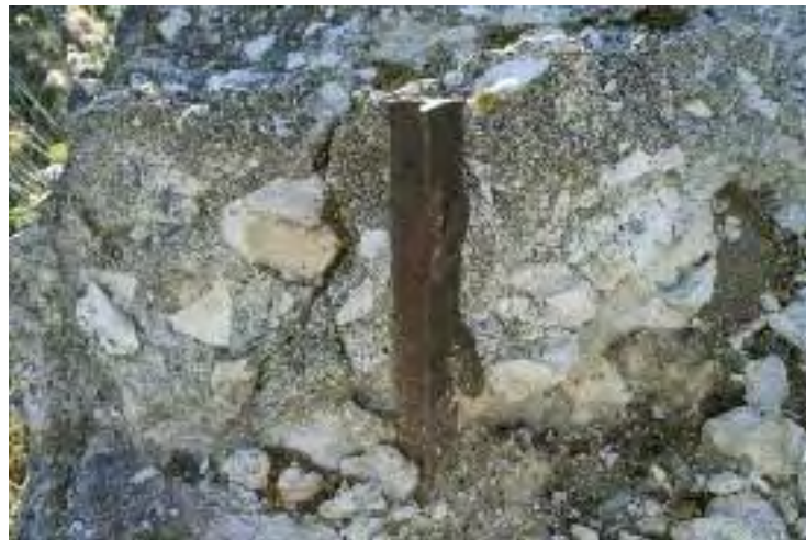
Fig. 103 a-b.- En la construcción de estas fortificaciones era bastante habitual utilizar piquetas de alambrada y el propio alambre de espinos como ferralla. Observando la superficie de los nidos podemos apreciar ocasionalmente estos elementos sobresaliendo de la masa del hormigón. Fotografías: Pablo Schnell (izquierda) y José Latova (derecha).
