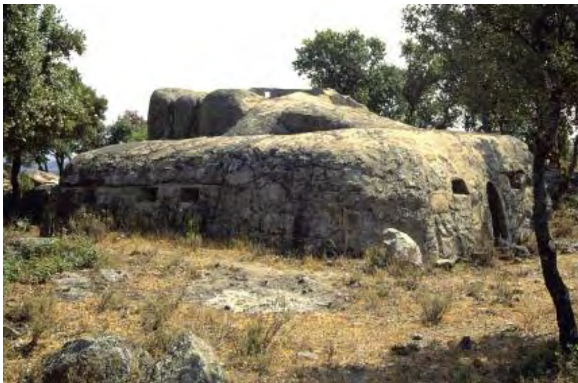
Fig. 71.- El impresionante conjunto fortificado del Cerro de La Longuera , conocido en los informes nacionales como Cota 960 , constituye posiblemente el mejor grupo de construcciones de la guerra en Madrid, tanto por su buen estado de conservación como por su riqueza tipológica. Fotografía: Ricardo Castellano.
