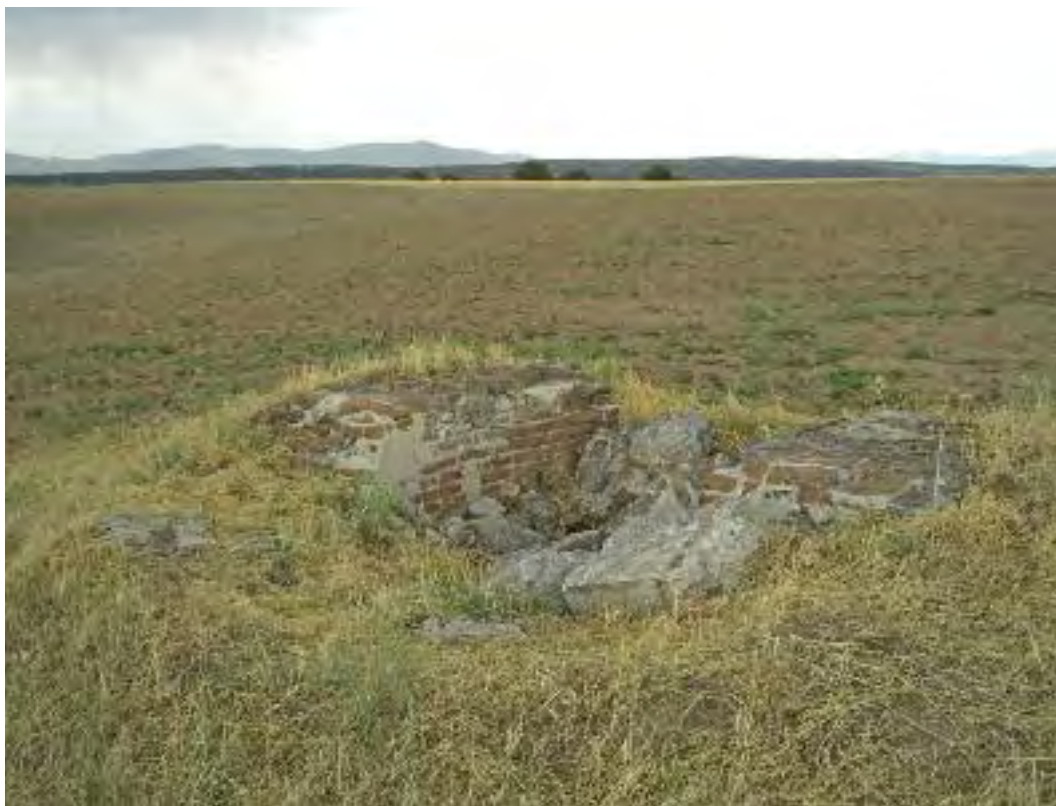
Fig. 81.- Las obras del semicírculo defensivo de Quijorna se encuentran muy deterioradas. Fotografía: Ernesto Viñas.
