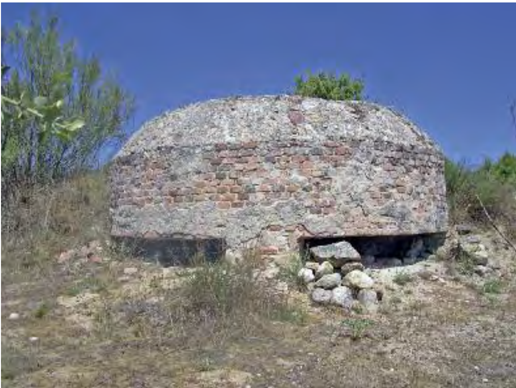
Fig. 36.- Nido republicano del plan 69-B en Valdemorillo en el que se aprecia el uso de ladrillo en la construcción de la obra. Fotografía: Pablo Schnell.
