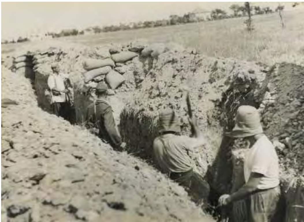
Fig. 40.- Construcción de trincheras republicanas cerca de la carretera de La Coruña en junio de 1937. Foto: Albero y Segovia. (Archivo Rojo). AGA_F_04067_55944_001_01
