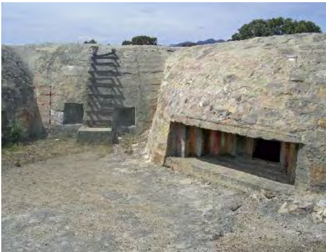
Fig. 37.- Troneras con derrame escalonado – redientes - en el Blockhaus 13 de Colmenar del Arroyo. Fotografía: Pablo Schnell.
