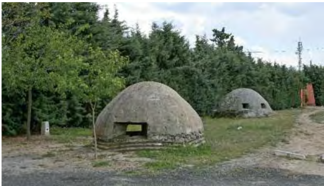
Fig. 100.- Fortines nacionales situados al sur del casco urbano de Brunete. El de tronera horizontal era para arma automática y el otro para fusilería. Detrás del seto, dentro de la finca, hay un tercer ejemplar. Se aprecia el negativo dejado por la chapa corrugada utilizada en el encofrado del primero. Fotografía: Pablo Schnell.
