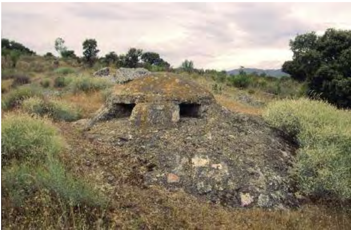
Fig. 68.- Observatorio y nido de ametralladora excelentemente mimetizados con el entorno en Los Roblazos . Fotografía: Ricardo Castellano.
