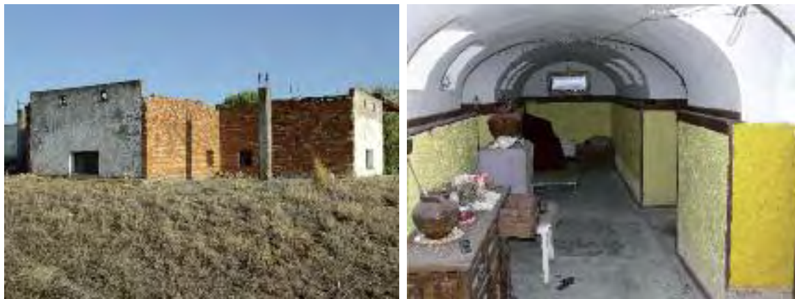
Fig. 89 a - b.- Exterior e interior acondicionado de uno de los nidos conjugados C.G.I.S. levantados por los zapadores de Franco en diciembre de 1938 al este del arroyo de Los Morales, Quijorna. Fotografías: Rubén de la Mata.
