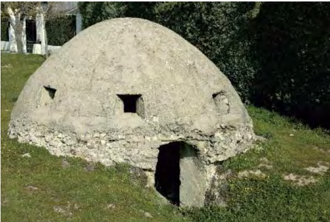
Fig. 101 a-b.- Fortín nacional para escuadra situado al sur de Brunete. En una de sus troneras se aprecia la fecha de construcción: 1939. Fotografías: José Latova.
