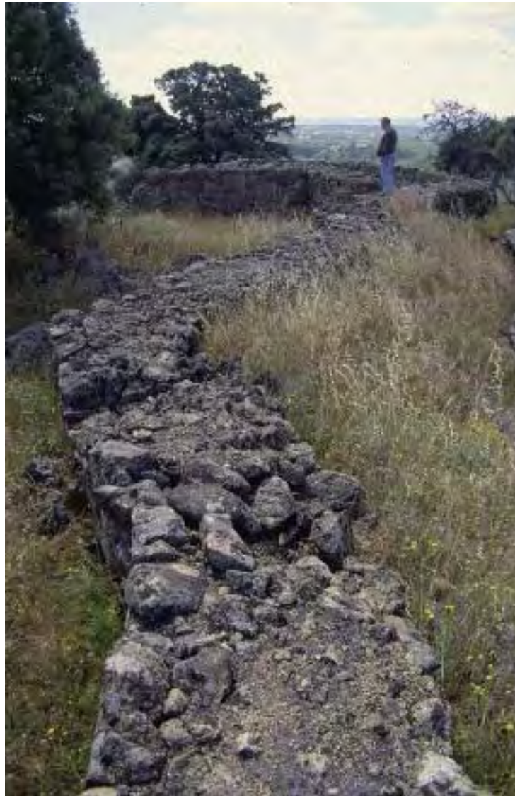
Fig. 26.- Parapeto republicano de mampostería en zig-zag situado cerca de Valdemorillo. Su estructura le daba consistencia como muro anticarro. Fotografía: Ricardo Castellano.
