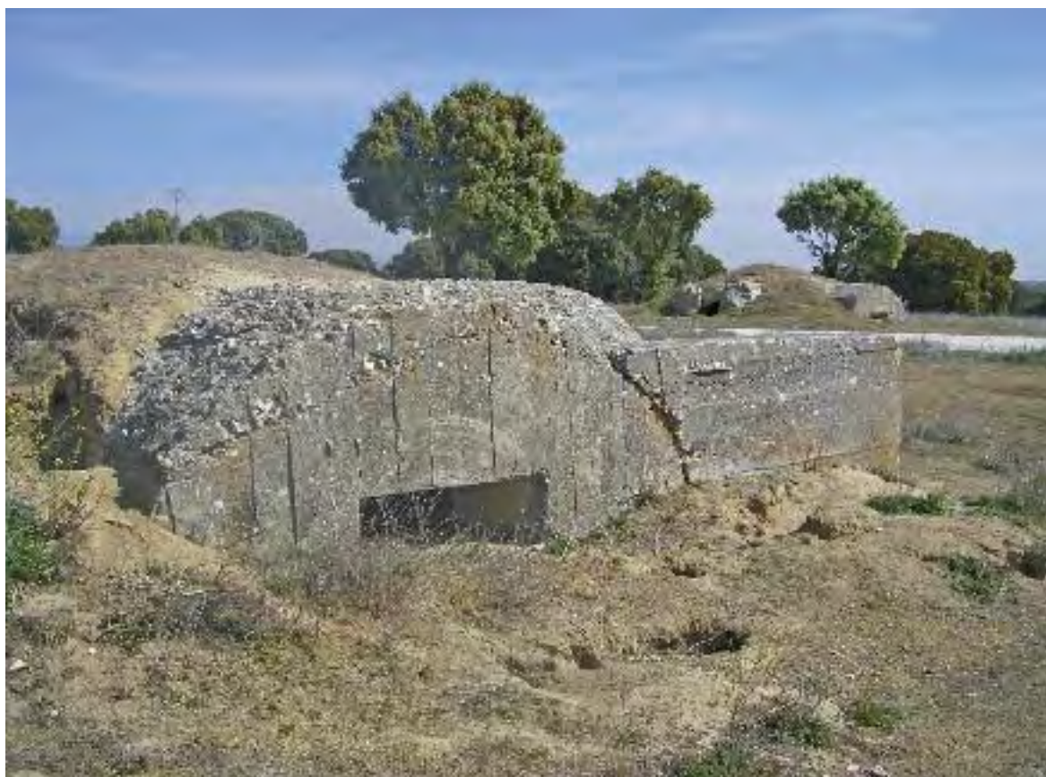
Fig. 93.- Dos fortines cruciformes flanqueando la cañada. Fotografía: Pablo Schnell.
