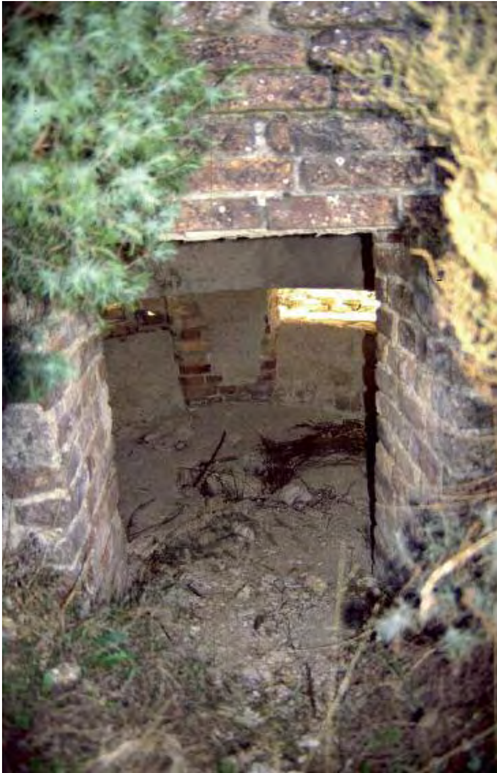
Fig. 124.- Interior del único nido de ametralladora perteneciente al Plan 69-B republicano que se construyó con exterior de ladrillo. Se trata de una excepción en la serie, toda de hormigón visto. Valdemorillo. Fotografía: Ricardo Castellano.
