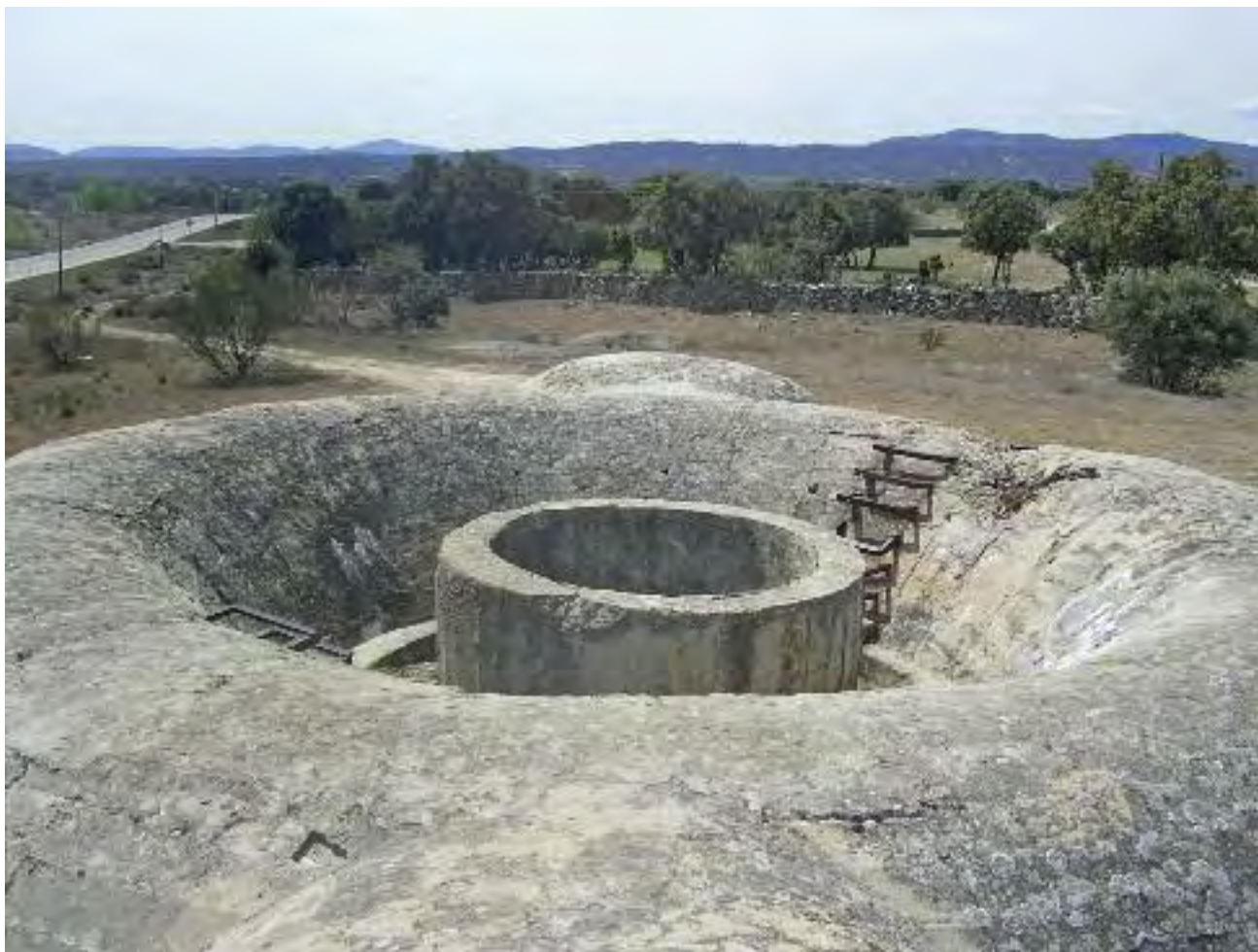
Fig. 35.- El fortín circular de Colmenar de Arroyo ( blockhaus 13 ) fue construido a prueba de proyectiles de 155 mm. El impacto que se aprecia junto a la escalera apenas ha perforado el blindaje. Fotografía: Ricardo Castellano.
