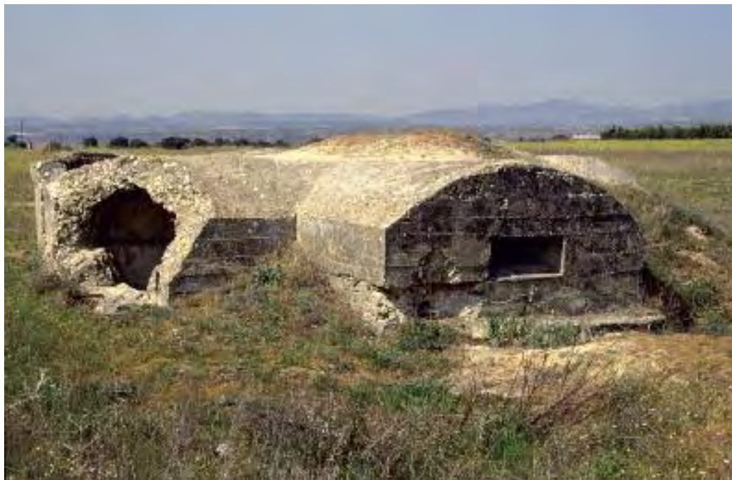
Fig. 96.- Exterior de uno de los nidos nacionales CGIS conjugados situado al norte de Brunete. La demolición de uno de sus extremos es generalizada en los ejemplares de la zona. Diciembre de 1938. Fotografía: Ricardo Castellano.
