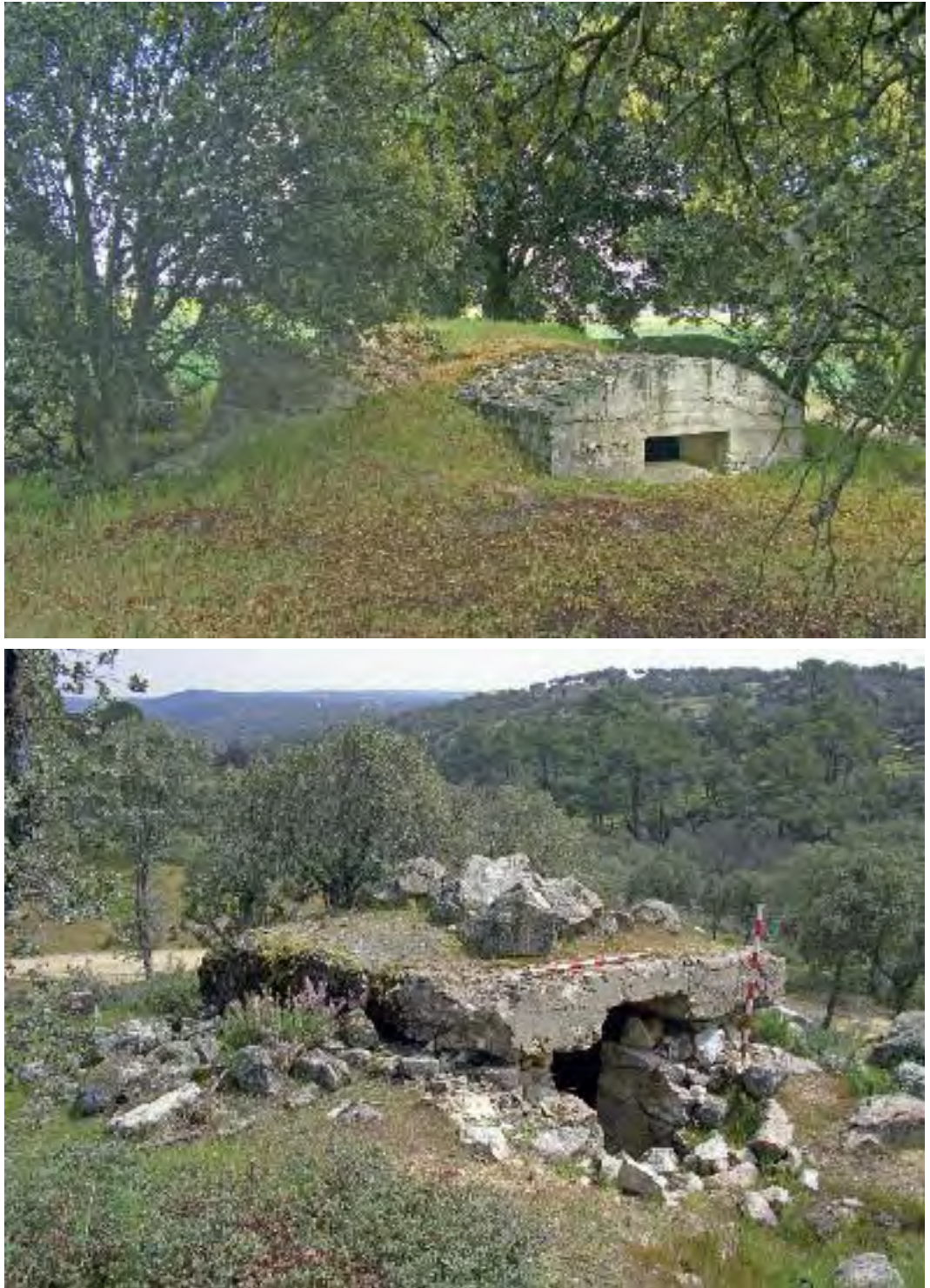
Fig. 33 a-b.- Dos tipos de enmascaramiento de obras. El fortín de arriba (Posición Encrucijada , en Villanueva de Perales) ha sido cubierto parcialmente por un túmulo de tierra. El nido de abajo tiene piedras incrustadas en su losa de blindaje superior (Barranco Hondillo, Navalagamella). Fotografías: Pablo Schnell.
