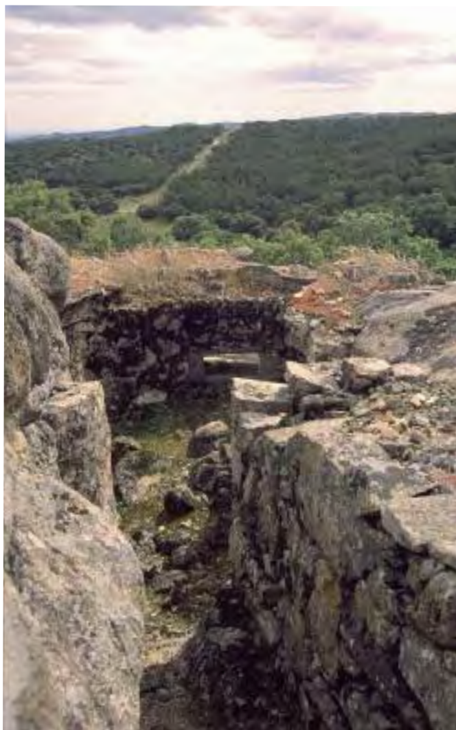
Fig. 118.- Vista desde uno de los fortines republicanos ubicados al norte del camino viejo entre Valdemorillo y Robledo de Chavela. Como el resto de la línea, fue erigido a partir de julio de 1937 por el Batallón de Zapadores de la 3ª División, que luego saldría de línea para ceder su terreno a la 69 División. Valdemorillo. Fotografía: Ricardo Castellano.
