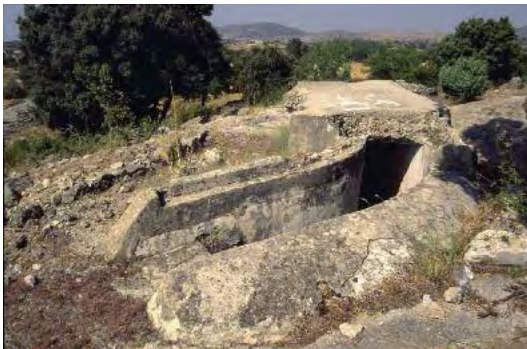
Fig. 75.- Nido de hormigón republicano con acceso trasero mediante escaleras. Batía la carretera entre Zarzalejo y Fresnedillas de la Oliva. Fotografía: Ricardo Castellano.
