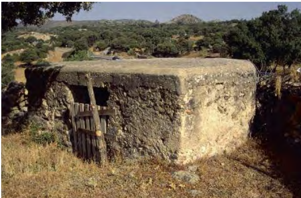
Fig.- 72.- Fresnedillas de la Oliva contaba con emplazamientos para armas automáticas en todas sus vías de acceso. En este caso se trata del que barreaba la carretera de Robledo de Chavela, también en manos nacionales. Fotografía: Ricardo Castellano.
