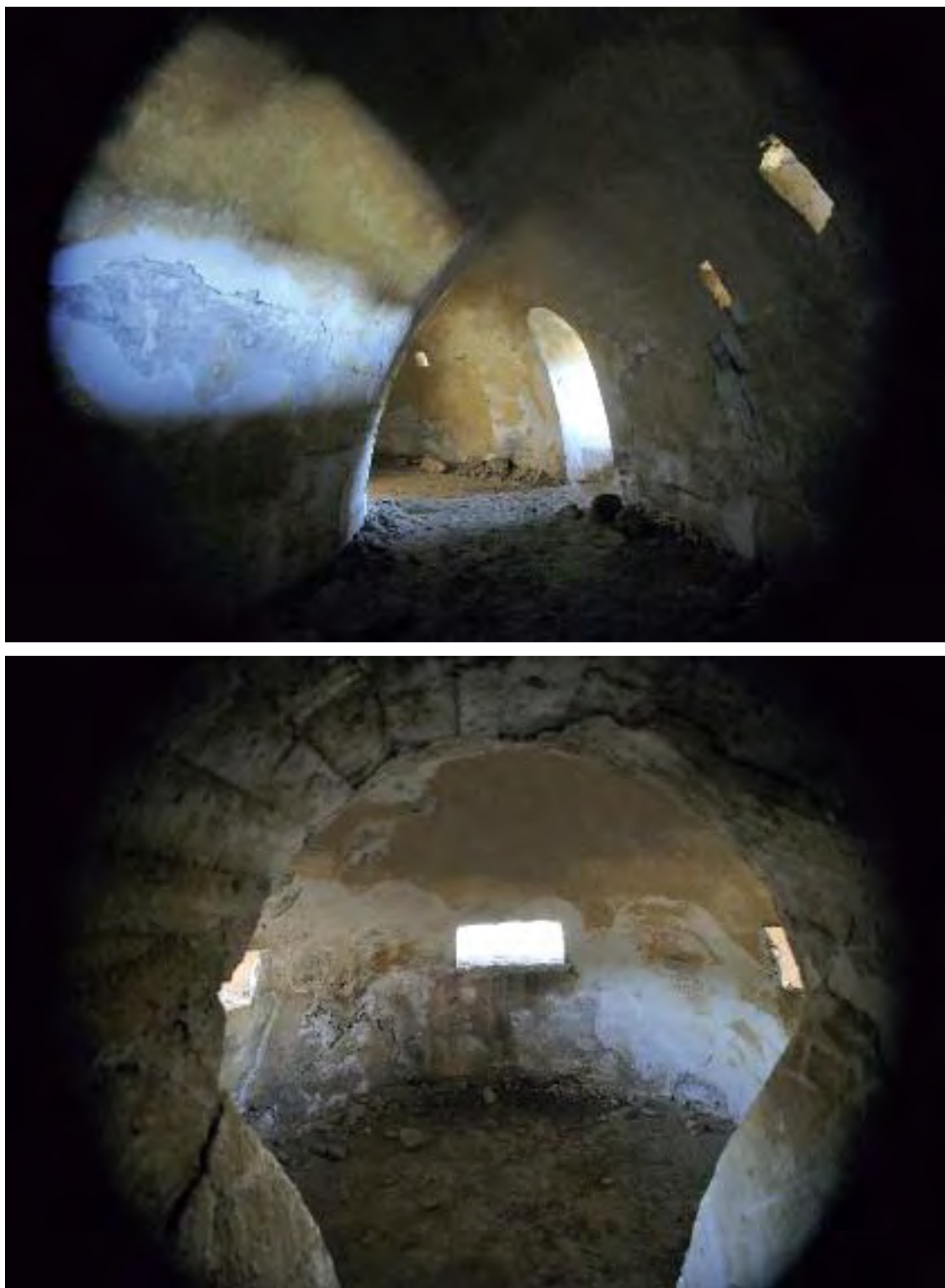
Fig. 131 a-b.- Vistas del interior del Blockhaus 13 (Colmenar de Arroyo). Fotografías: Juan Carlos Martín Lera. Archivo de la Dirección Gral. de Patrimonio Histórico.
