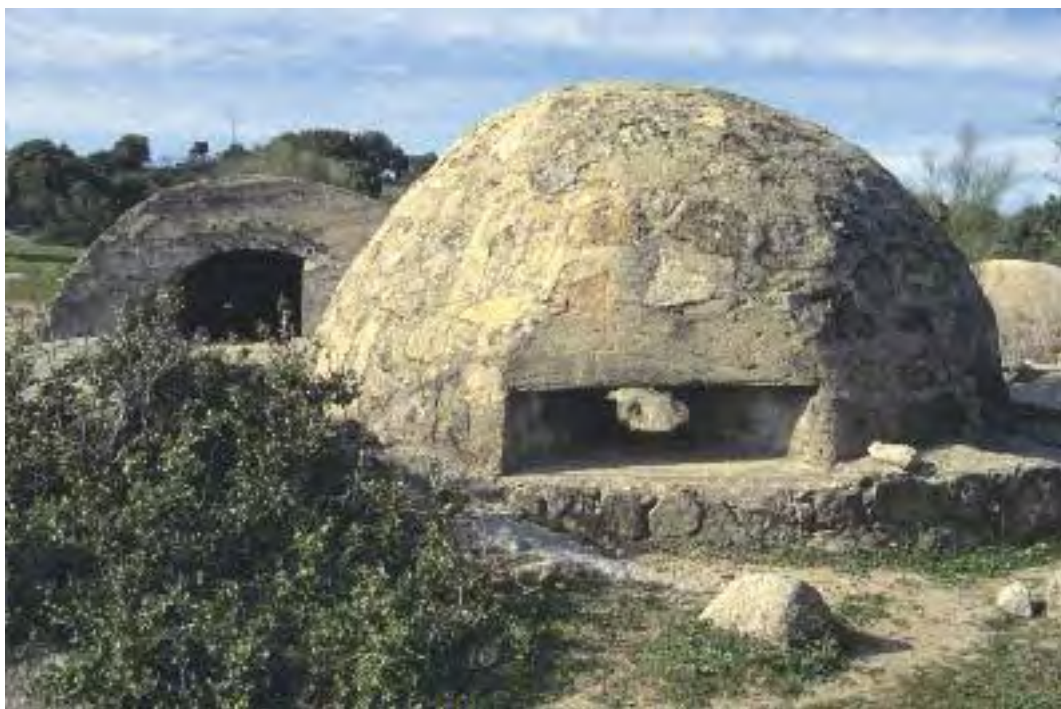
Fig. 52.- Construcción tipo Blockhaus en la Posición Calvario (Navalagamella) iniciada a finales de 1938. Está inconclusa y no aparece en los listados nacionales del plan de Blockhaus, por lo que probablemente se trate de una modificación sobre la marcha aplicada a un emplazamiento previo. Fotografía: Ricardo Castellano.
