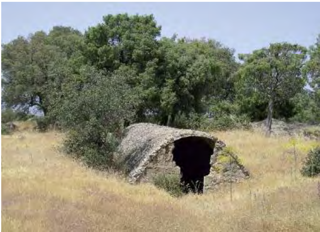
Fig. 57.- Vivienda nacional catenaria en la Posición Los Pradillos . Fotografía: Pablo Schnell.
