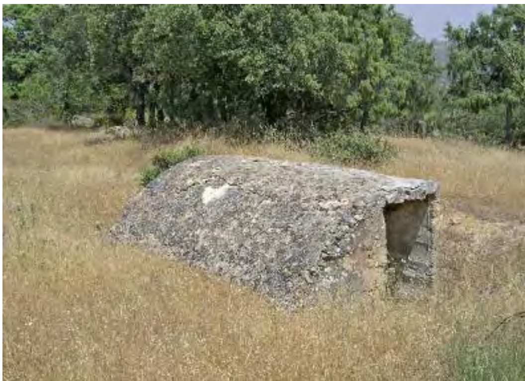
Fig. 56.- Vivienda nacional en media catenaria en la Posición La Muela. Fotografía: Pablo Schnell.
