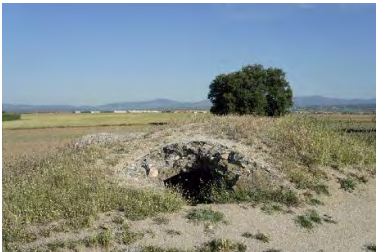
Fig. 99.- El fortín de Los Rosales no presenta la habitual planta de cruz, sino en T. La destrucción intencionada de sus frontales, posterior a la guerra, nos permite apreciar el espesor del blindaje superior. Fotografía: José Latova.
