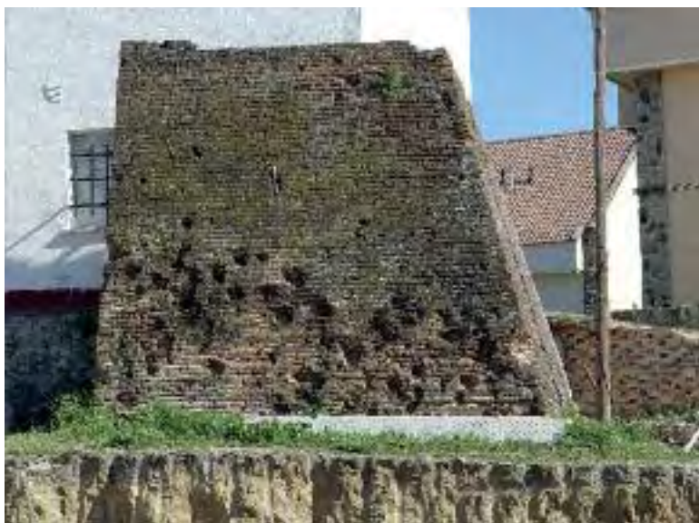
Fig. 78.- Contrafuerte con impactos de proyectiles en Quijorna. Fotografía: Ricardo Castellano.
