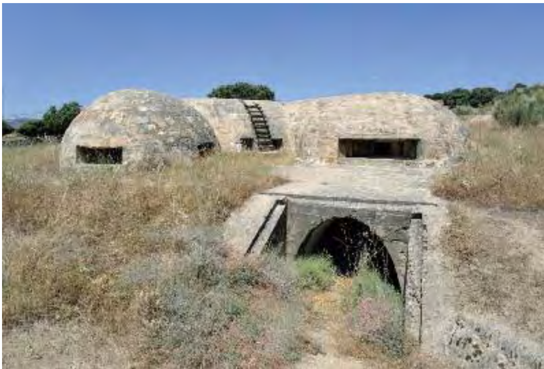
Fig. 129.- El Blockhaus 13, de Colmenar de Arroyo. Único ejemplar concluido de los 7 iniciados a partir de un plan de noviembre de 1938. Fotografía: Juan Carlos Martín Lera. Archivo de la Dirección Gral. de Patrimonio Histórico.
