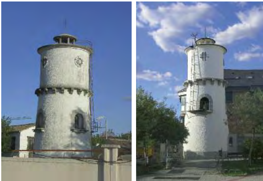
Fig. 109 a-b.- El depósito de agua de Villanueva de la Cañada (izquierda) es idéntico al construido en la vecina localidad de Villanueva del Pardillo (derecha). Fotografías: Pablo Schnell.
