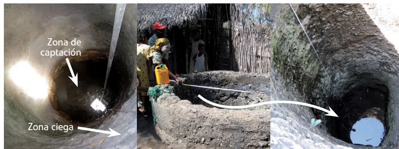
Figura 9.5. Izquierda. Partes de un pozo abierto. Centro y derecha. Pozo excavado de forma manual.
