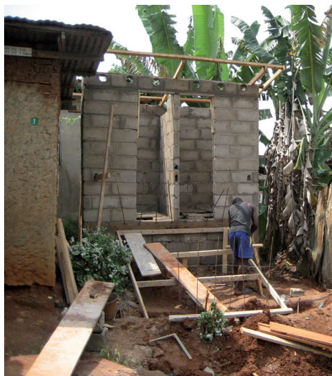
Foto 10.1. Construcción de una letrina ecosan ventilada. Yaundé, Camerún 2006.
