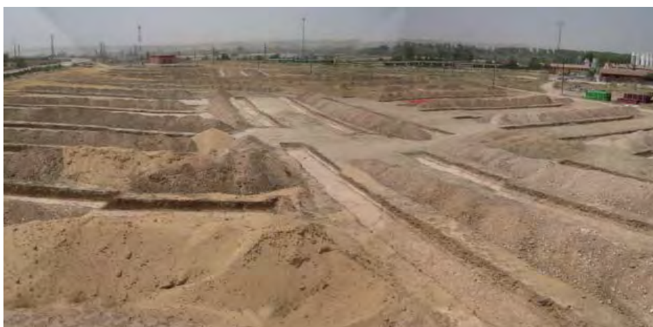
Fig. 2. Vista general de las zanjas realizadas.
