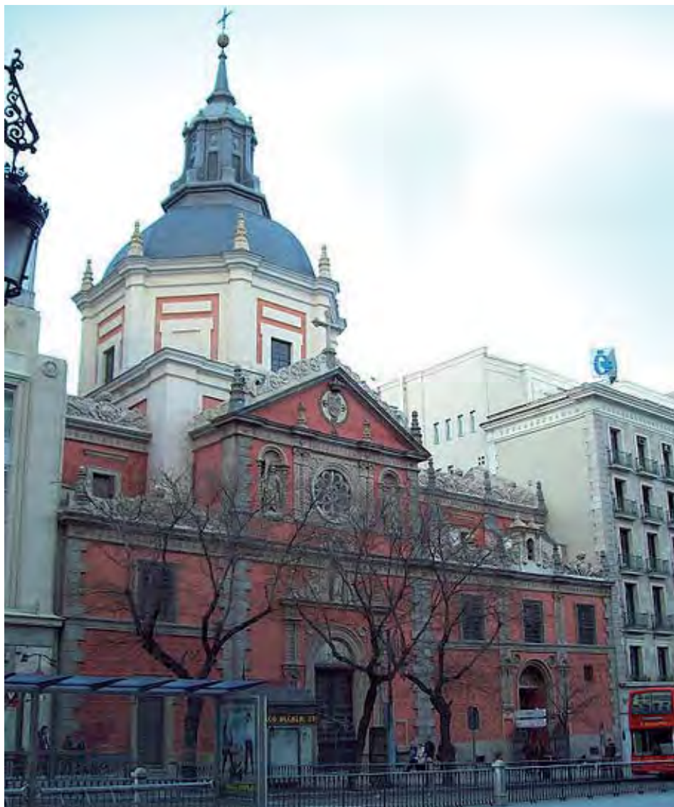
Fig. 1. Fachada principal de la iglesia en su estado actual.
