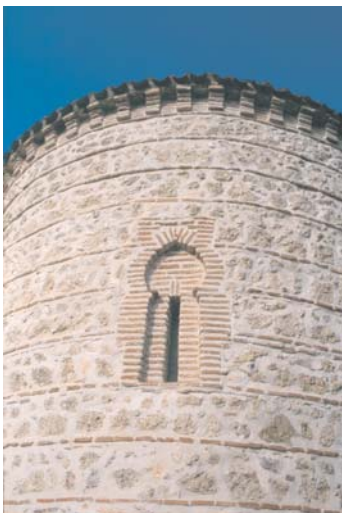
Detalle de la ventana del ábside de la Ermita de Santa María la Antigua en Carabanchel.
