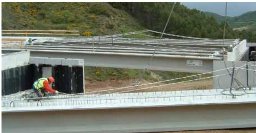
*Fig. 39. Línea de vida en cargadero para el montaje de vigas. Con arnés y doble cuerda se pasa a la línea de vida de la viga para desenganchar las eslingas de la grúa.*
