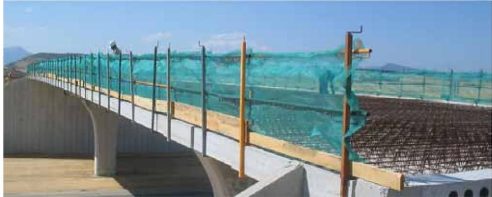
En los trabajos de **montaje de las prelosas** deberá preverse y planificarse la **protección de los perímetros laterales del puente**, tanto para proseguir con el montaje como para los trabajos posteriores de ejecución del tablero. En el caso de que los bordes de la estructura coincidan con una viga, esta previsión deberá considerar la colocación de la correspondiente protección en el borde exterior de la viga.
