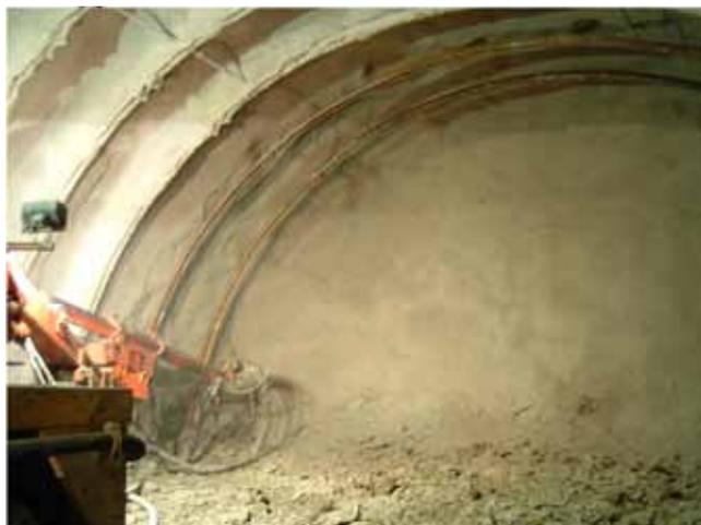
7. En el caso de túneles excavados mediante el *Método Belga* con excavación manual, debe existir una buena **coordinación entre los operarios encargados** del picado con martillo neumático y los encargados de la retirada del material con pala para evitar los golpes con terrones del material excavado.
