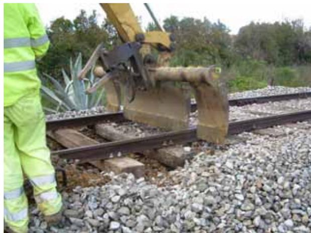
La renovación con medios mecánicos utiliza el **tren de desguarnecido** que consta de los siguientes elementos: locomotora tractora, vagones tolva con cintas transportadoras (para acopiar el material retirado) y la desguarnecedora (que capta, criba y retira la piedra) al final del convoy.
