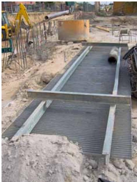
7. Antes del izado de las armaduras debe comprobarse que **no queden restos de armadura sueltos** que puedan desprenderse durante el posicionamiento en el batache. Del mismo modo deberá comprobarse el correcto atado de tuberías y elementos de exploración para evitar su desprendimiento durante la fase de colocación de la armadura.
