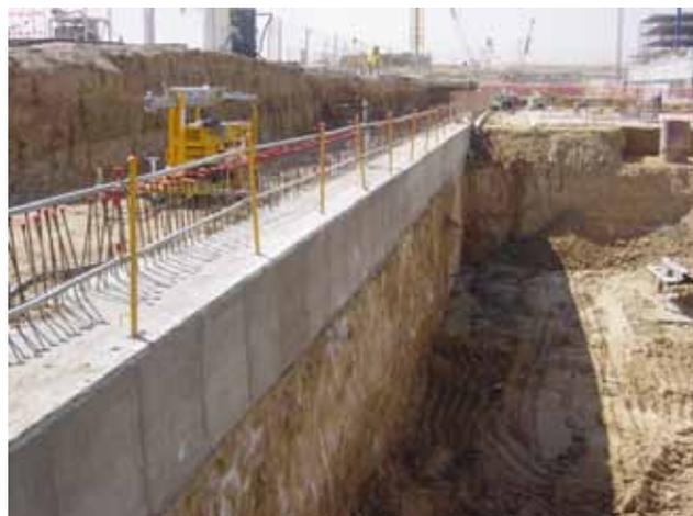
1. **Colocar la línea de vida retranqueada y situada a una altura del suelo de 1 m aproximadamente.** De esta forma se permite la separación entre la zona de anclaje del arnés de la zona de acción de la máquina. La posición ideal de esta línea de vida sería **en el lado opuesto donde se sitúa la pantalladora** para evitar interferencias.
