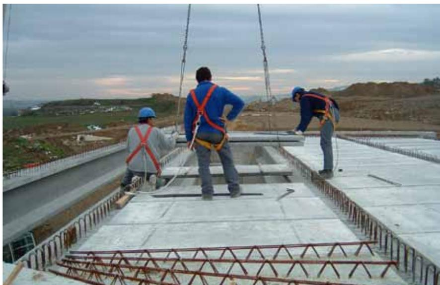
Fig. 41. Prelosas con tabica de borde sobre viga artesa. Barandilla montada junto a la prelosa.
