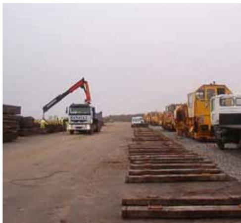
Fig. 54. Colocación de vía auxiliar en traza con acopio de traviesas para su posterior colocación.
