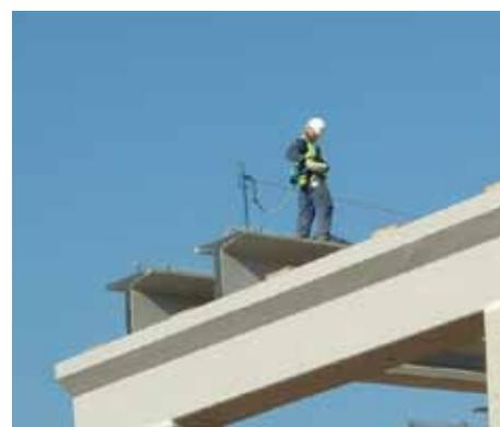
*Fig.40. Montaje de prelosas sobre vigas doble T. Línea de vida en eje de vigas y arnés de seguridad para protección del riesgo de caída en altura.*
