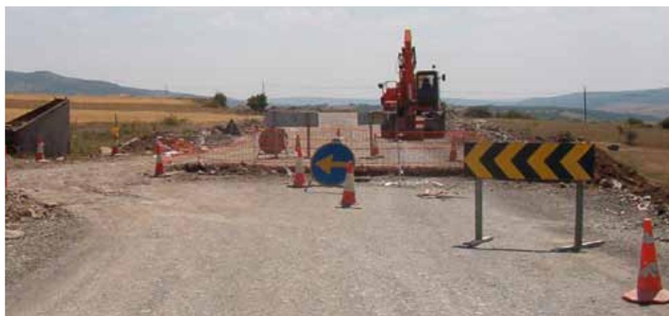
Igualmente, las **cabezas de los taludes deberán balizarse a una distancia de seguridad del borde** (como mínimo 2 metros). En caso de que el desmonte afecte a una zona de paso o transitada por vehículos (por ejemplo, corte de un camino), este balizamiento debe anticiparse y colocar topes para evitar el paso de vehículos (caballones de tierra o similar).
