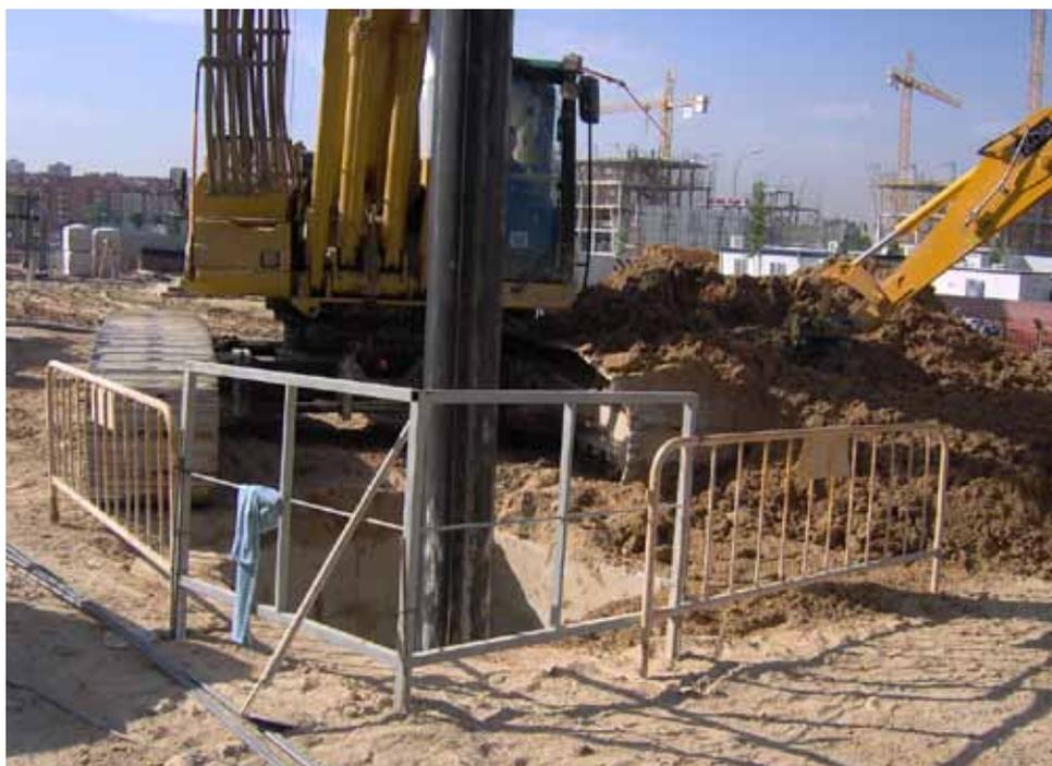
2. Puede **planificarse el posicionamiento de la pila con una mesa de centrado que proteja todo el hueco**, salvo el espacio correspondiente a la pila y unos pequeños huecos para realizar el relleno perimetral de grava.
