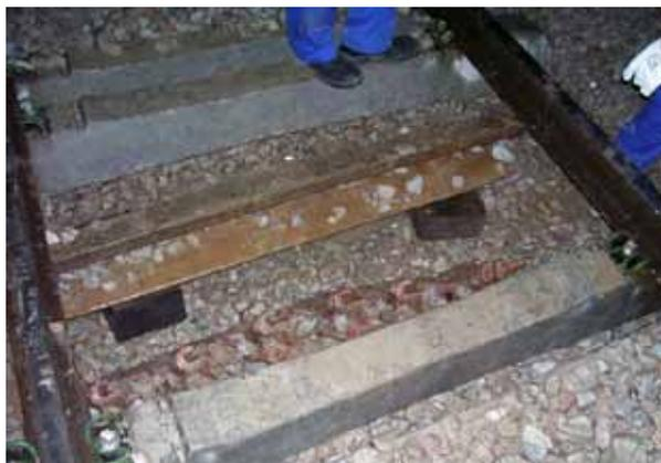
En este procedimiento, al inicio es necesario **ejecutar manualmente una zanja transversal** para la colocación de la teja de la propia desguarnecedora. En cuanto a la mano de obra habitualmente involucrada en la operación, es aproximadamente de 10 personas, repartidas entre el control de la teja y el funcionamiento, el llenado de las tolvas y la conducción de la locomotora.
