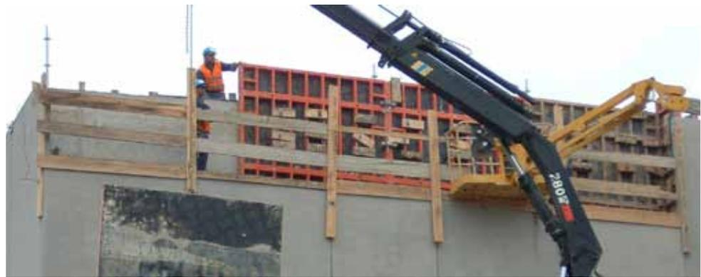
Fig.32. Barandillas en estribos para ejecución de viga cargadero, espaldines y mortero de nivelación. Línea de vida para los trabajos de colocación de neoprenos y el montaje de vigas.
