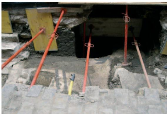
Para este tipo de trabajos, únicamente se realizarán excavaciones por medios manuales o mediante maquinaria-herramienta de poca potencia; las excavaciones por medios mecánicos sólo se utilizarán excepcionalmente y siempre que la estabilidad de la estructura esté asegurada (este extremo será controlado por los técnicos que ejecutan y dirigen la obra).
