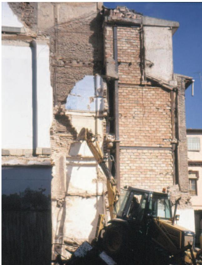
*Figura 37. Derribo utilizando una pala mixta.*
