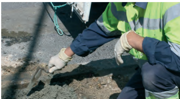
Figura 73. Manipulación de cemento.
