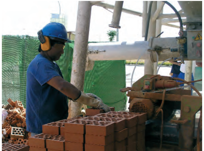
Figura 21. Trabajo con sierra de corte cerámico.
