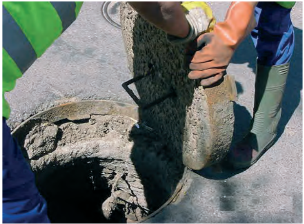
Figura 79. Trabajo en colectores.
