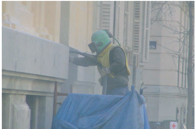
Figura 50. EPR aislante con capuz. Se está realizando limpieza de fachada con chorro de arena.
