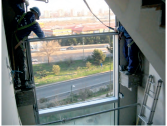
Figura 84. Instalación de ventanas.
