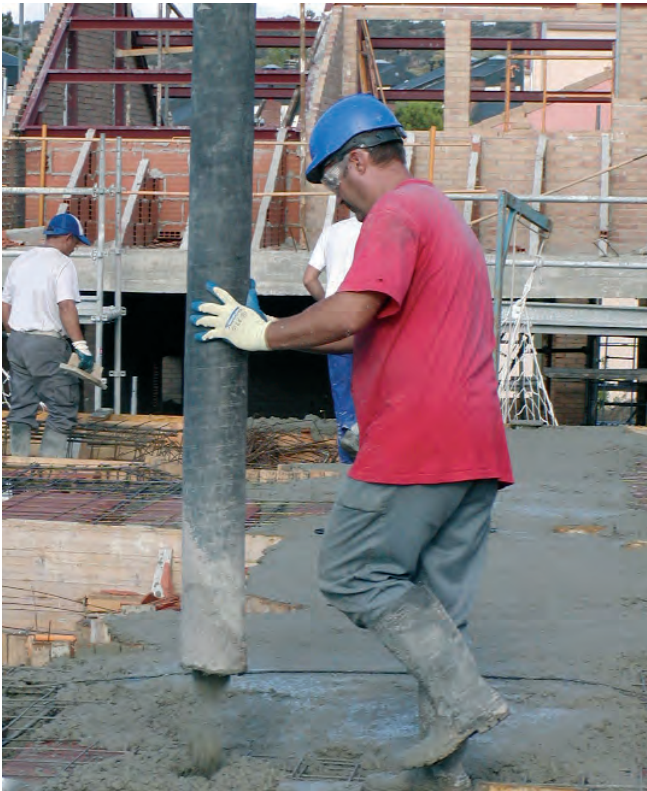
Figura 41. Hormigonado con bomba. Pueden producirse salpicaduras de hormigón.
