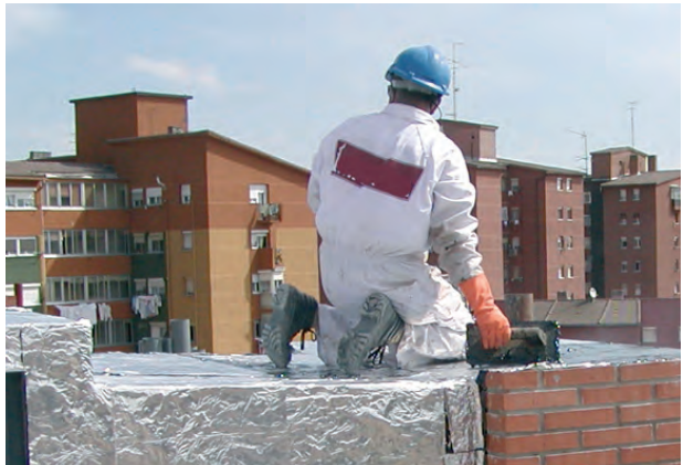
Figura 76. Impermeabilización con betún en caliente.
