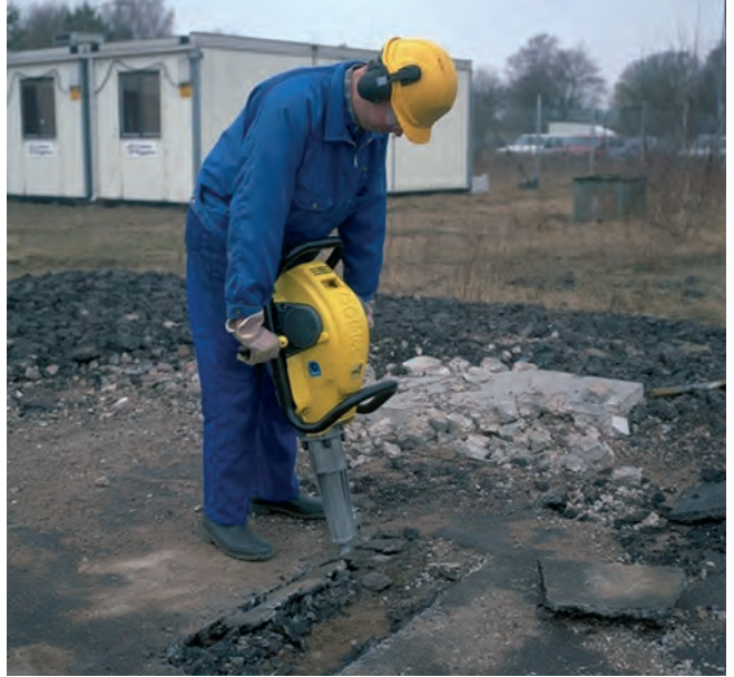
Figura 12. Orejeras acopladas a un casco de protección.
