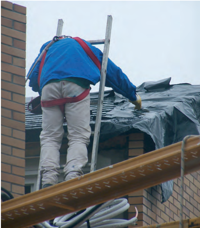
Figura 83. Trabajos en cubierta.
