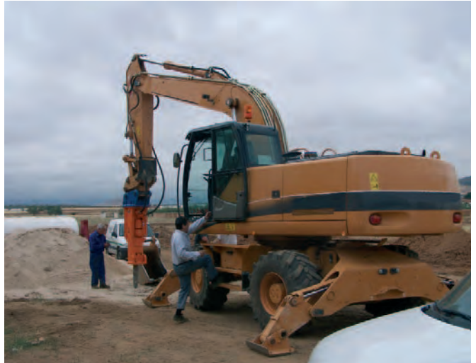
Figura 10. Retroexcavadora con martillo rompedor.
