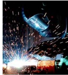
Soldadura de corte
