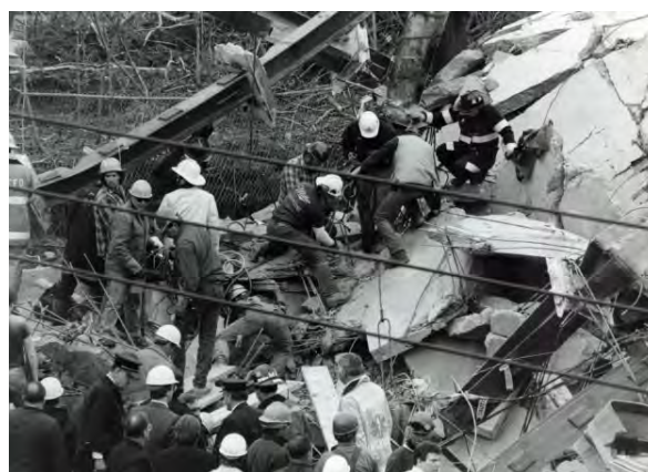
Imágenes del colapso de la construcción de la torre del L'Amiance Plaza.
