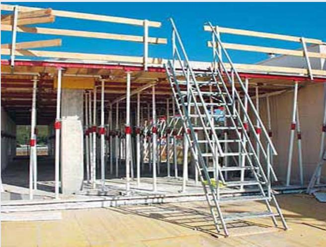
**S-5. Hormigonado de la losa.** El hormigonado se realiza con bomba de hormigón. Para esta actividad resulta importante la disposición de plataformas sobre la armadura.
