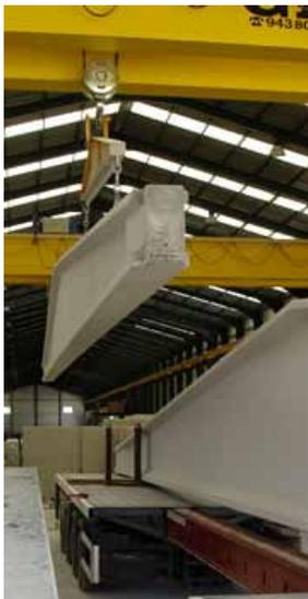
En dichas fases, la **manipulación de las piezas** prefabricadas para su colocación en los vehículos de transporte se realiza mediante **equipos y maquinaria de elevación de cargas**, eslingándose los prefabricados de varios puntos específicos mediante elementos concretos para éstas labores hasta el posterior posicionamiento y deslingado sobre la plataforma de transporte.
