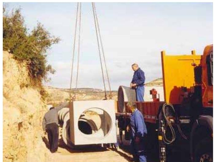
Igualmente, tal circunstancia también se puede producir como consecuencia del **mal estado de conservación de los elementos de sujeción y elevación**, los cuales, al recibir el peso de la pieza, se rompen y producen el golpe o atrapamiento del trabajador que realiza su guiado.
