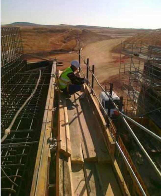
Aunque lo ideal es realizar el montaje de las plataformas de hormigonado de forma solidaria al encofrado, en ocasiones estos elementos auxiliares para realizar el hormigonado del muro se realizan a posteriori. Estos trabajos se realizarán con plataformas elevadoras o desde andamios. Si se ha utilizado el andamio continuo para el armado del muro puede utilizarse este para la colocación del encofrado y como plataforma de trabajo para el hormigonado.
