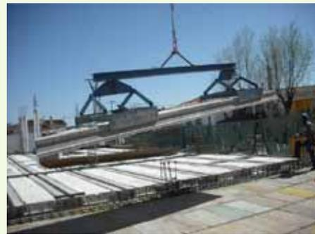
Para el montaje de las placas de inicio será necesario disponer líneas de vida, con puntos de anclaje previstos en los pilares y jácenas de la estructura.
