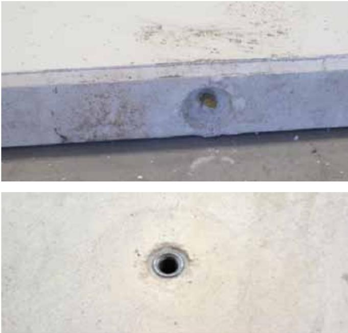
Igualmente, la incorrecta fijación del anclaje puede ser debida también a la **falta de especificidad** del elemento de sujeción utilizado, el cual, por la diversidad de piezas fabricadas en la planta es **utilizado indistintamente** para la manipulación de todas ellas debido a la problemática que supone el cambio de la misma de acuerdo a la pieza a manipular.
