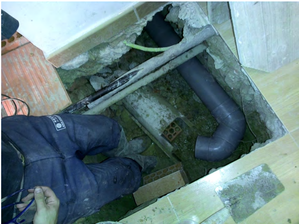
Fig. 9: Apertura realizada en el suelo, para acceder a una conducción y así procede a la reparación de una avería. Obsérvese la presencia de servicios afectados.
