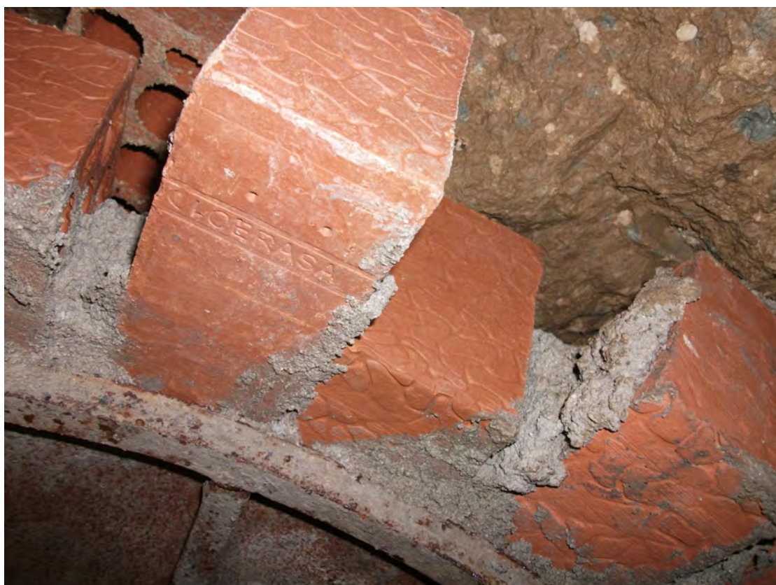
Fig. 48: Ladrillos dispuestos sobre el camón, en espera de adquisición de la resistencia que permita la retirada del elemento de sustentación.
