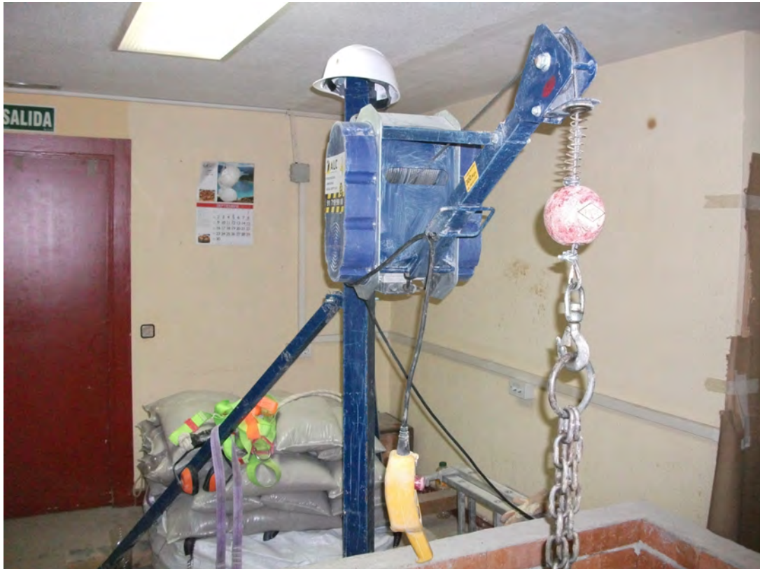
Fig. 22: Detalle del maquinillo de la imagen anterior, en el que se aprecian los elementos de seguridad de los ganchos.
