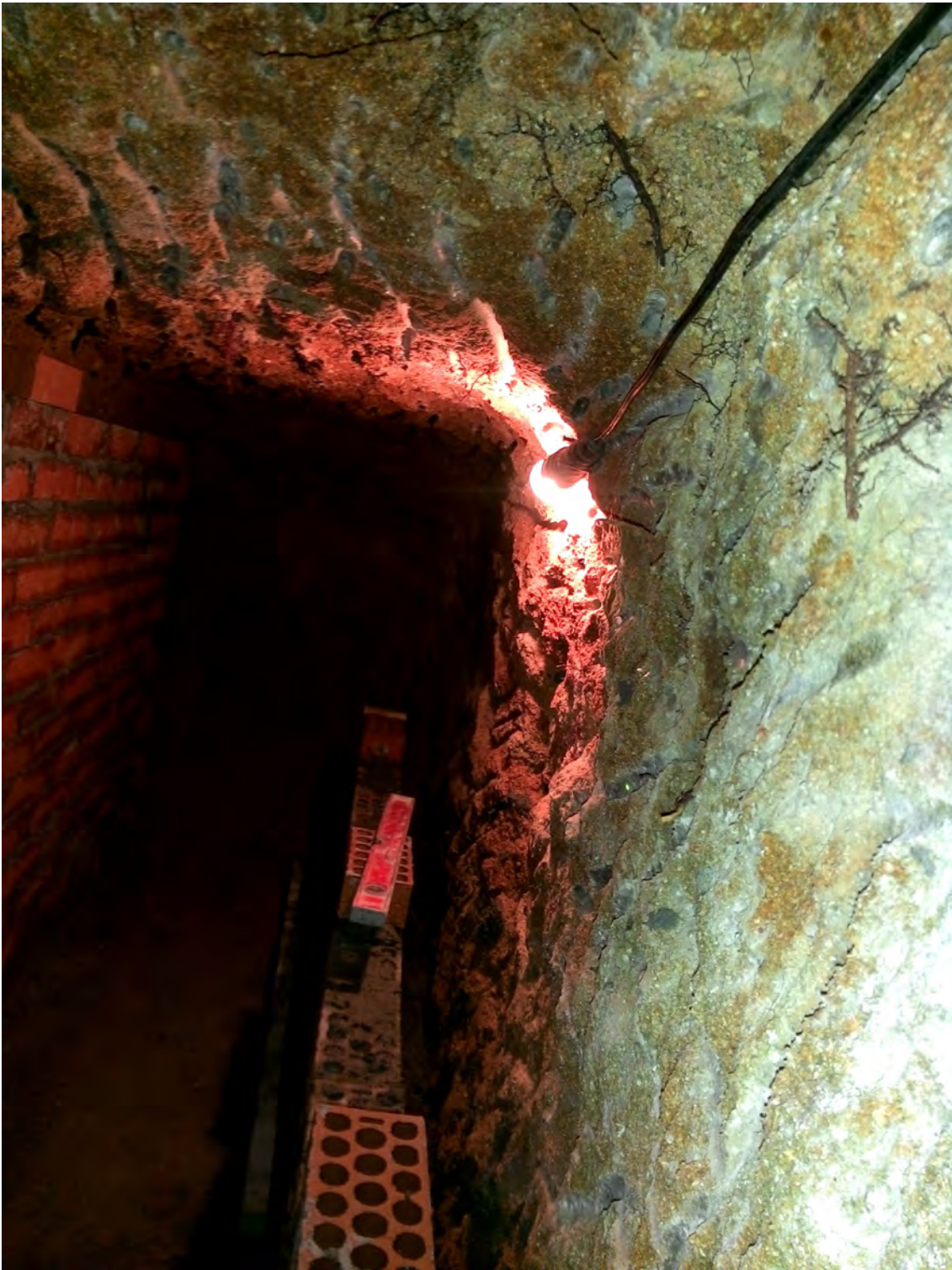
Fig. 41: Dispositivos de alumbrado en el interior de la galería anterior.
