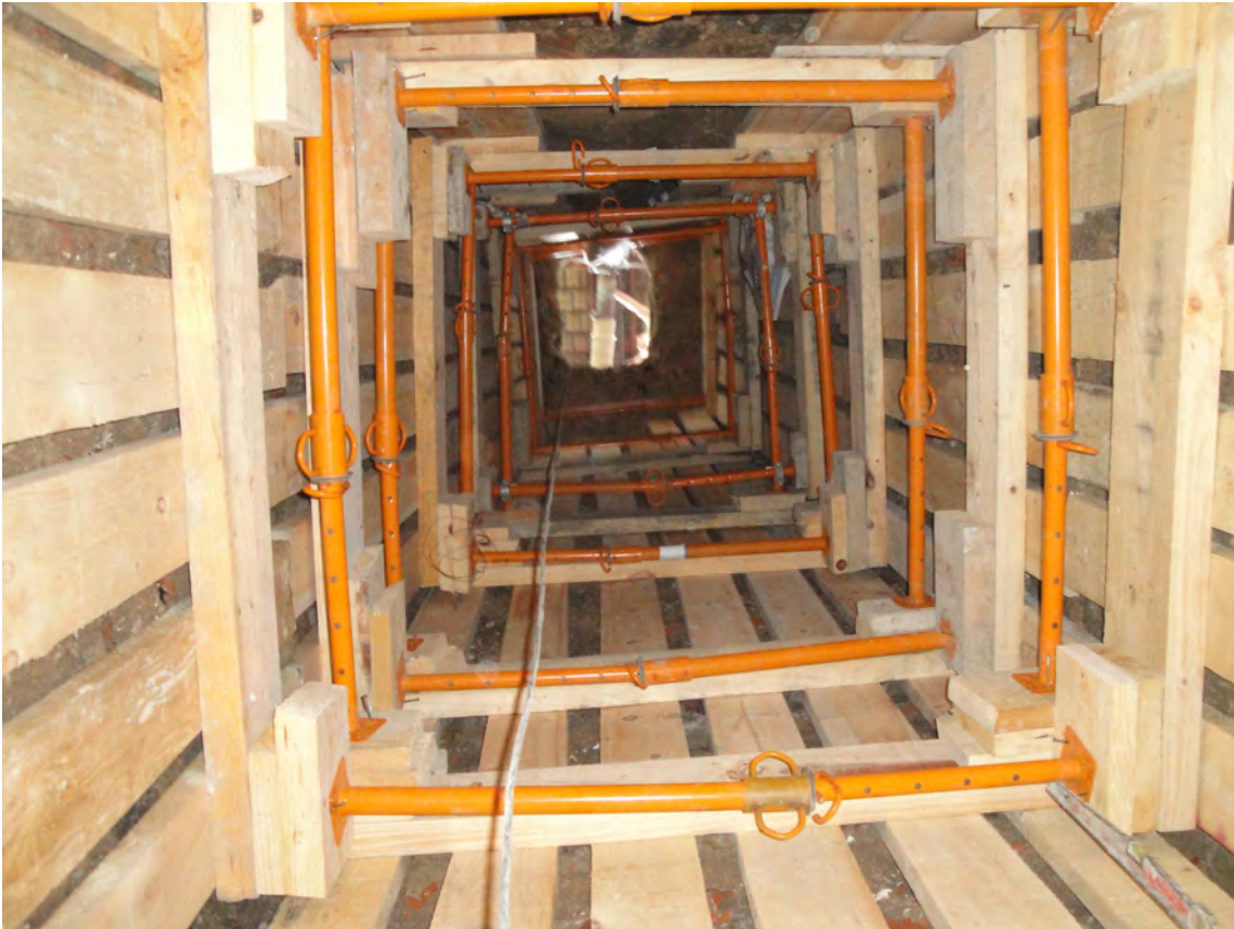
Fig. 37: Sistema de entibación semicujada, empleado para sostener el terreno y facilitar el tránsito de operarios.
