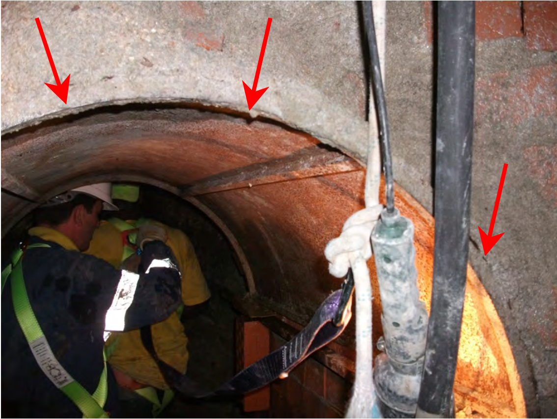
Fig. 40: Camón dispuesto en una galería en fase de ejecución.
