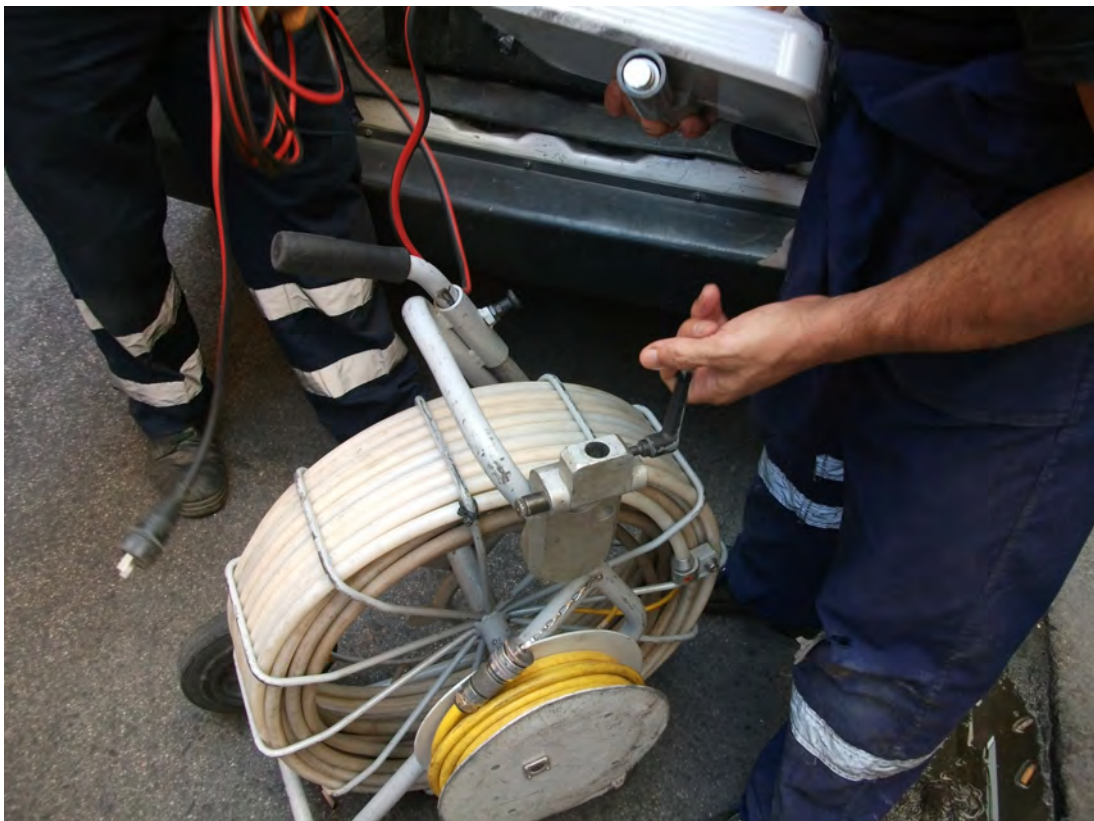
Fig. 15: Dispositivos de monitorización de menor tamaño, para acceder a conducciones de menor sección.
