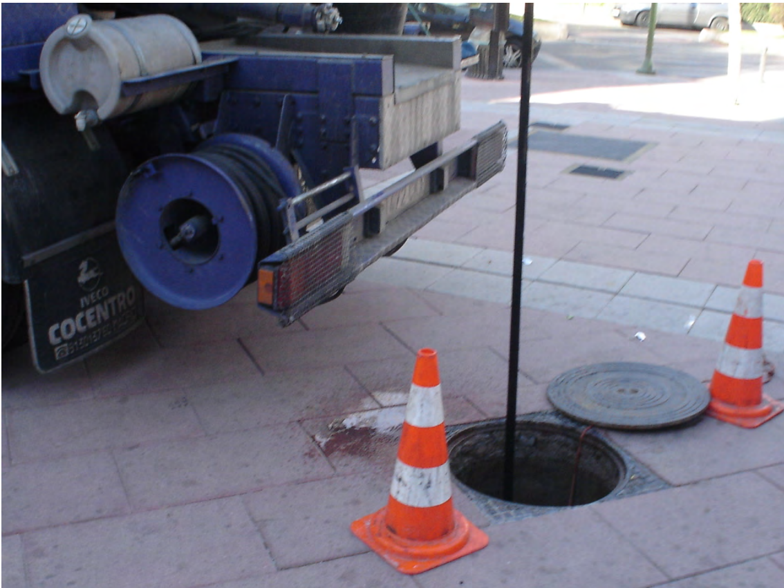
Fig. 1: Operaciones de introducción del dispositivo de agua a presión en el interior de una alcantarilla.
