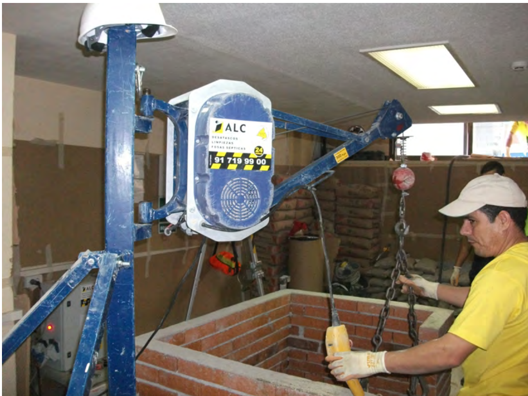
Fig. 21: Maquinillo dispuesto para permitir la entrada y salida de material a través de un pozo.
