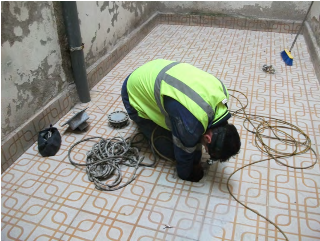
Fig. 12: Operario extrayendo el dispositivo robótico de una conducción.
