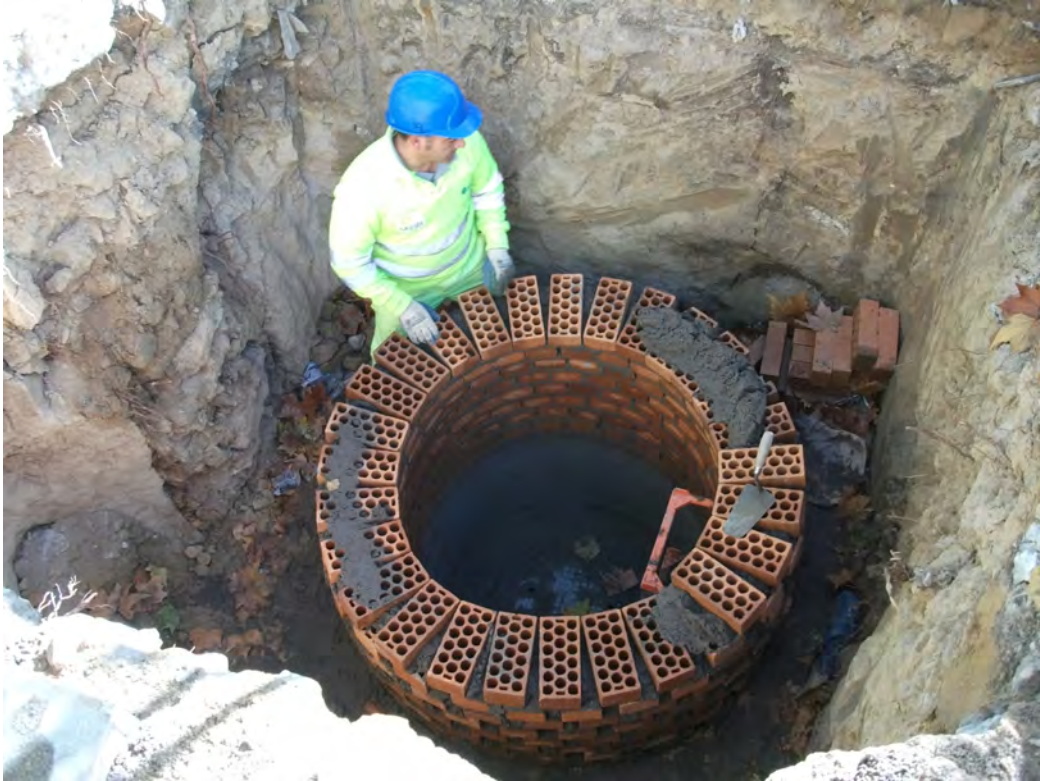
Fig. 18: Trabajos de ejecución de un pozo.
