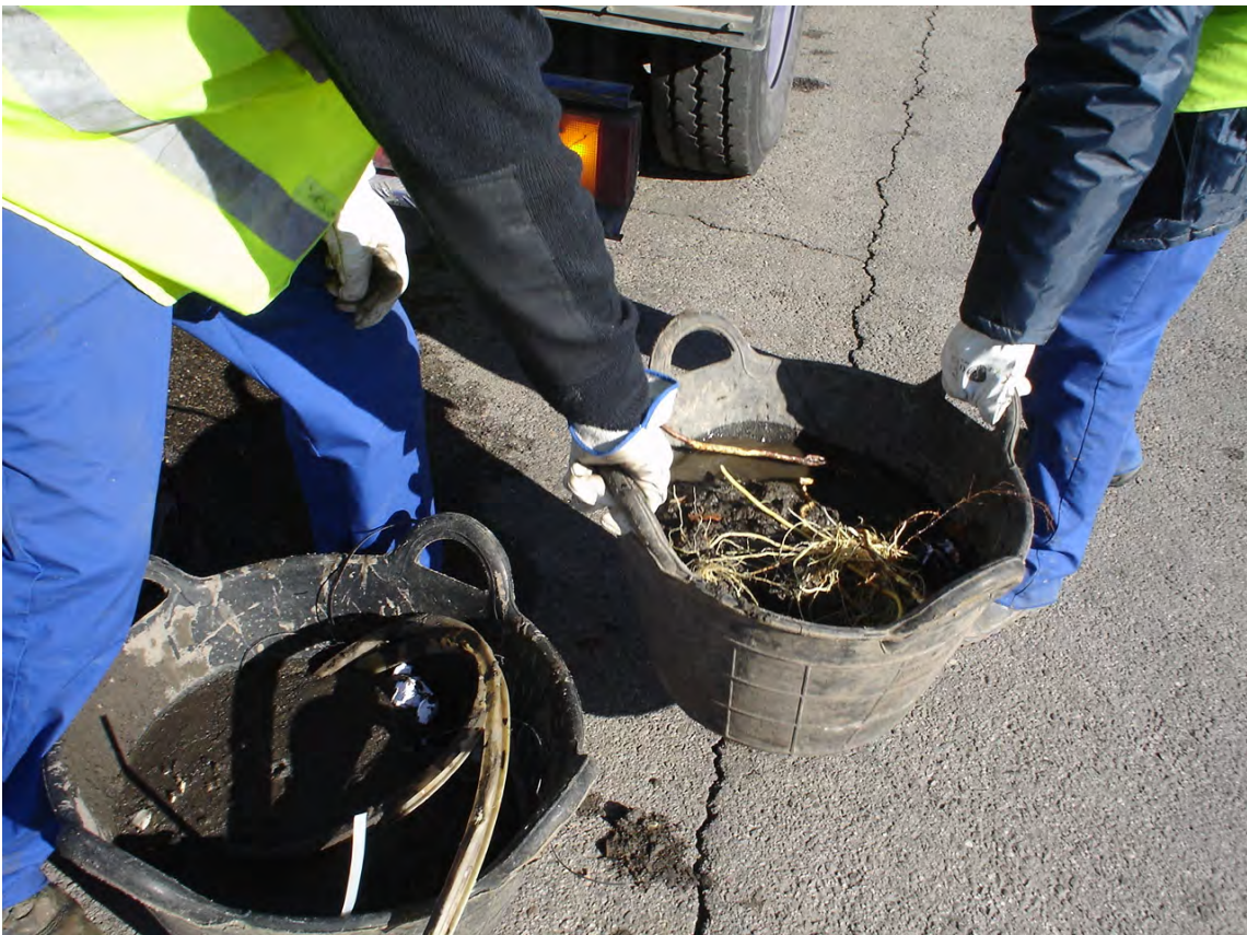
Fig. 6: Operarios retirando material procedente de la limpieza de varias conducciones.
