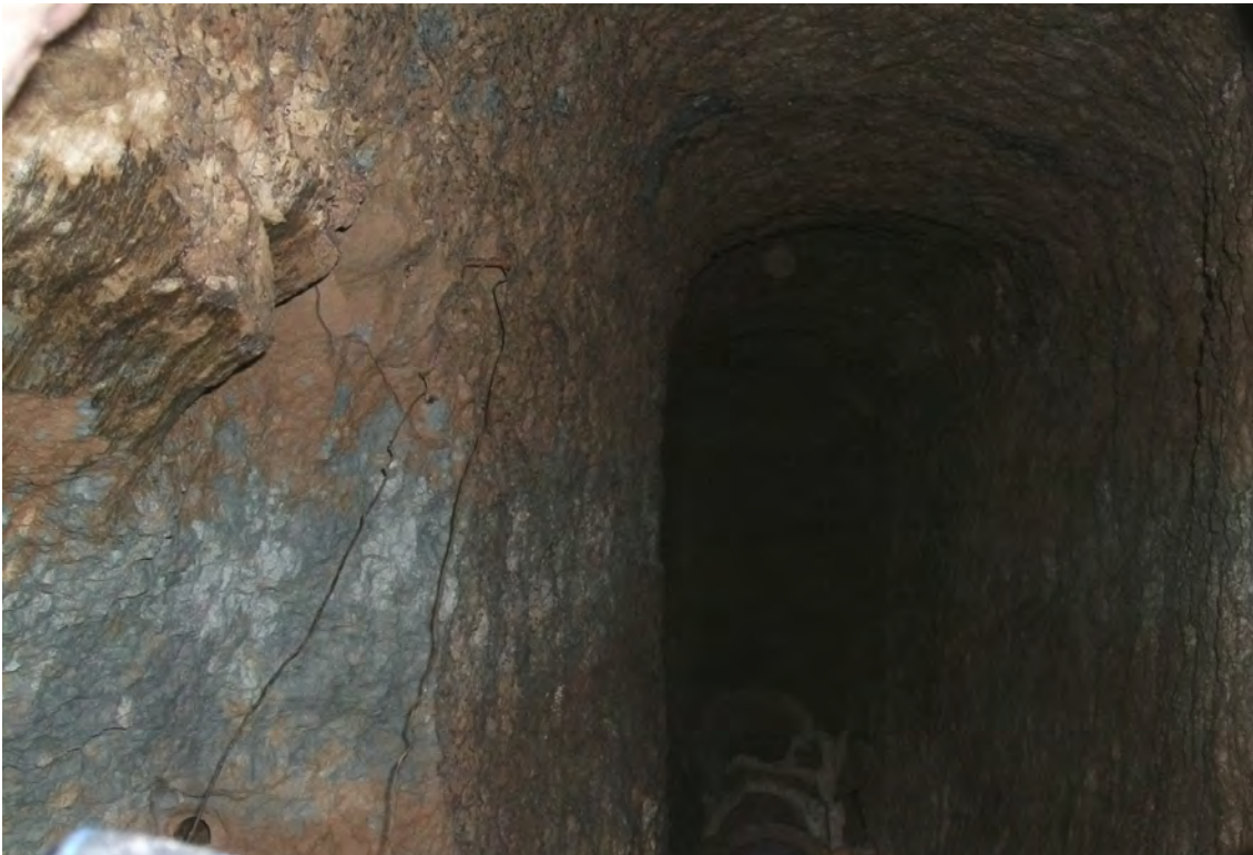
Fig. 50: Galería en proceso de excavación, al encuentro con otra galería.
