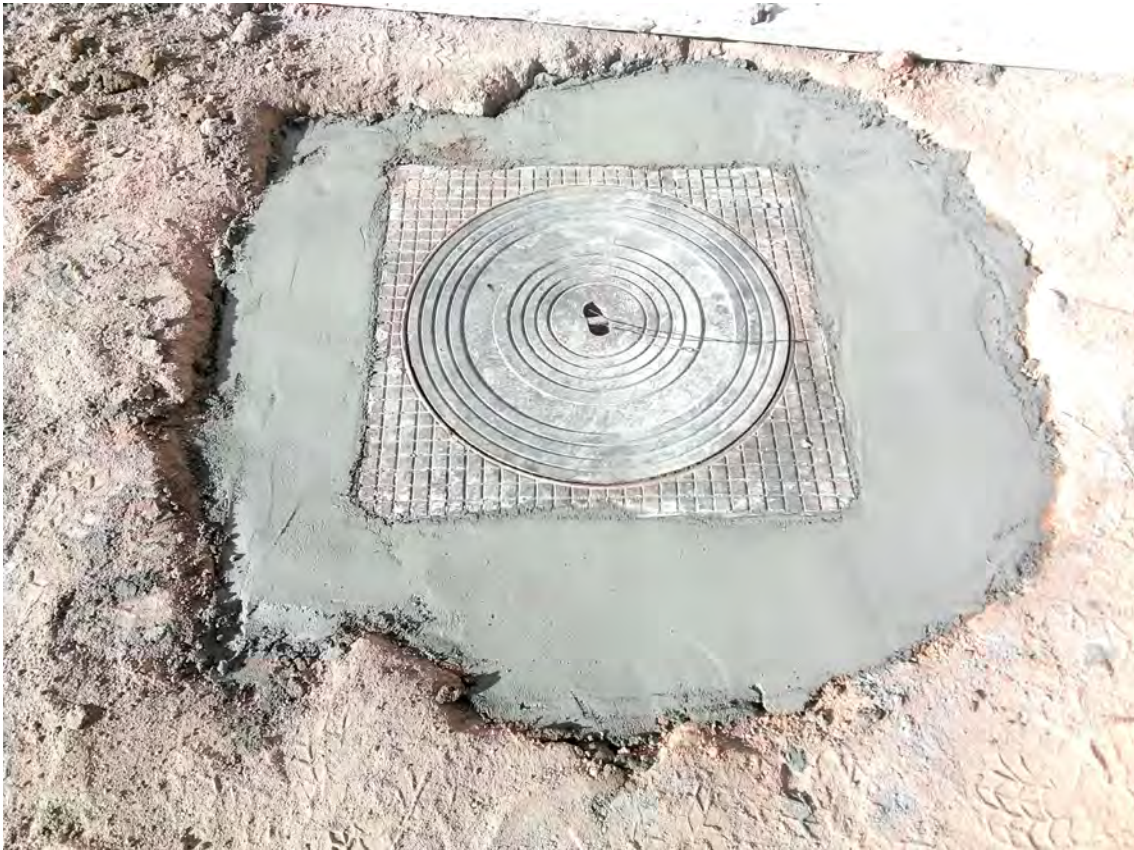
Fig. 32: Pozo clausurado a la finalización de los trabajos correspondientes.
