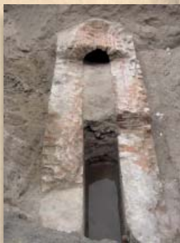
Canalización de suministro de agua a la Cabecera del Real Canal del Manzanares (Parque de la Arganzuela).
