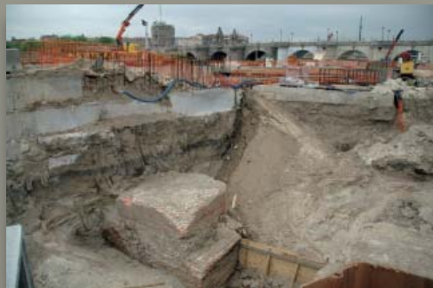
Pilas de La Puente Toledana halladas en la margen izquierda del río Manzanares, aguas abajo del Puente de Toledo.
