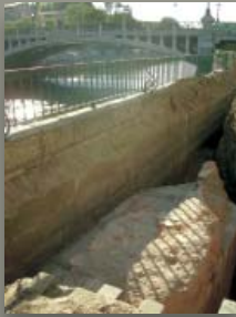
Tajamar del Puente Verde hallado en la margen izquierda del río Manzanares.
