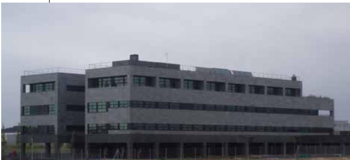
Foto 3.3. Edificio de oficinas en el parque empresarial La Carpetania en Getafe.
