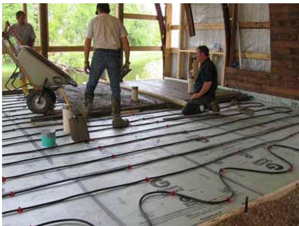
Foto A2.9. Proceso de instalación de suelo radiante (Fuente: Sunburst).
