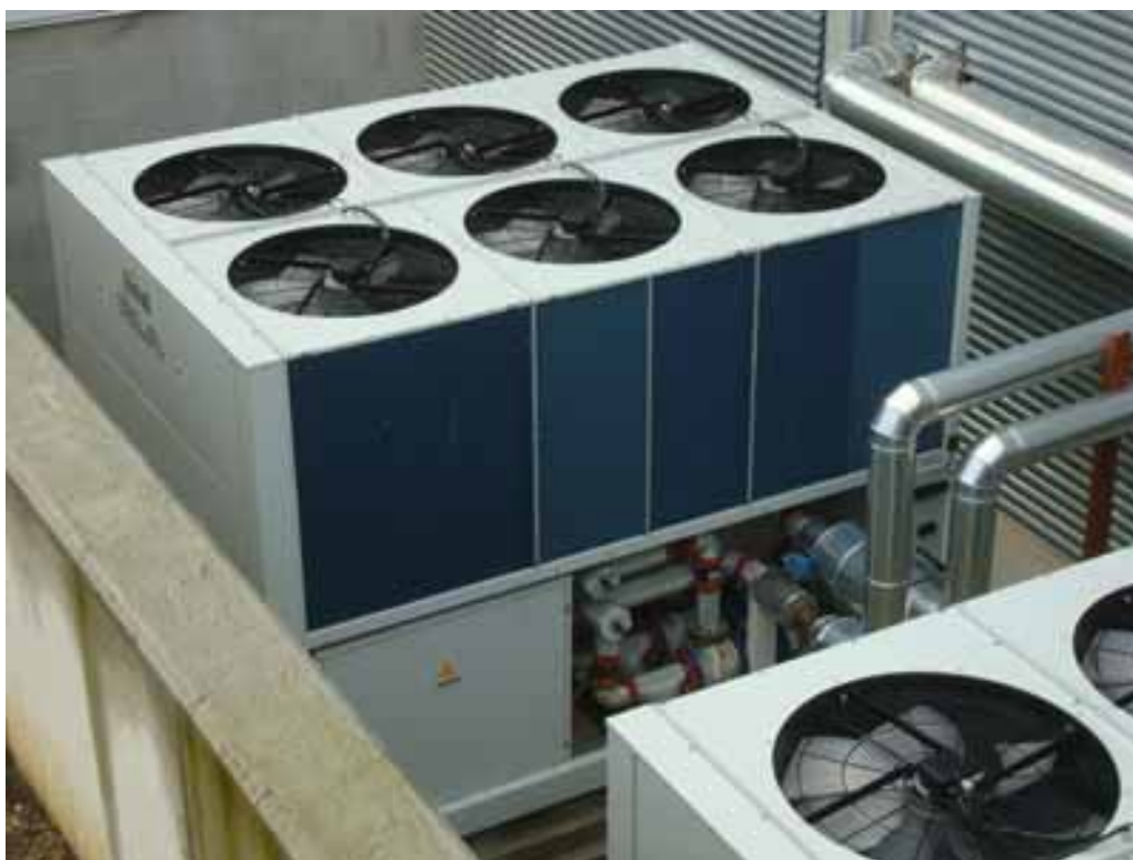
Foto A1.7. Enfriadora para grandes instalaciones tipo RLA (Fuente: Ferroli).
