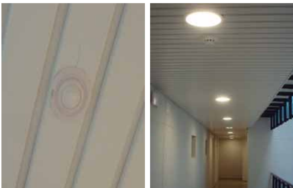
Foto A3.11. Sistema detector de presencia para iluminación en un edificio empresarial e iluminación de zonas comunes.
