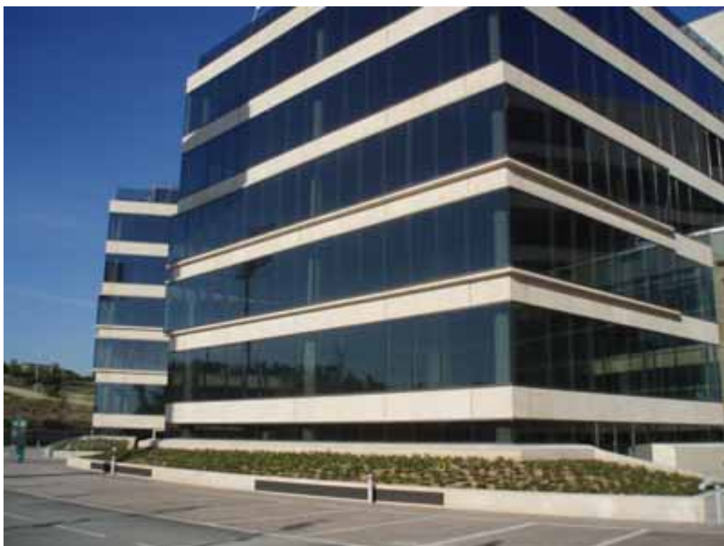
Foto A2.4. Edificio de oficinas acristalado en el complejo empresarial Parque Omega de Alcobendas.
