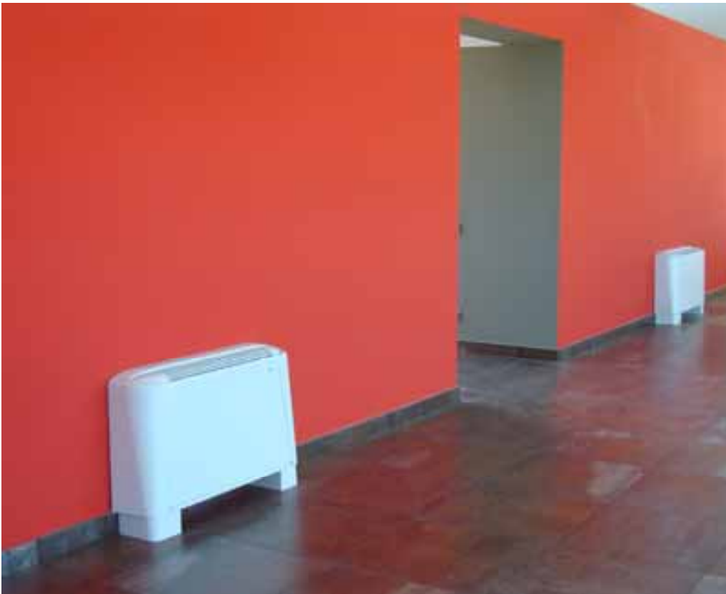
Foto A2.13. Fancoils de pared (Fuente: Ferroli).
