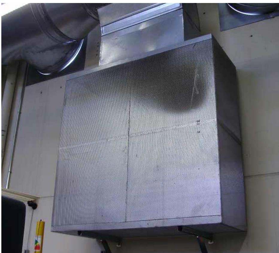
**Foto 3.** *Plenum* para difusión del aire por desplazamiento.
