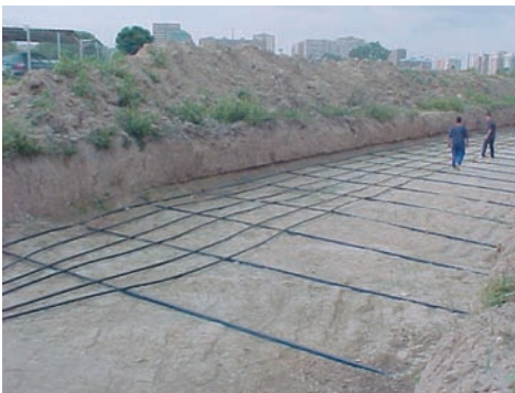
Figura 8. Intercambiador de calor horizontal enterrado. (Fuente: PROFIT).
