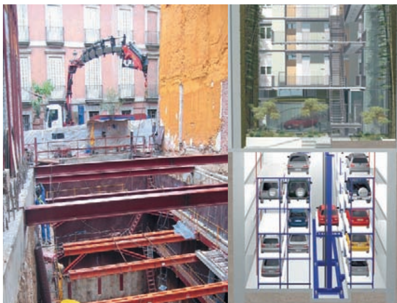
Figura 6. Construcción de un aparcamiento robotizado con 55 plazas bajo un edificio en rehabilitación integral en el casco histórico. C/ Huertas 39, Madrid.
