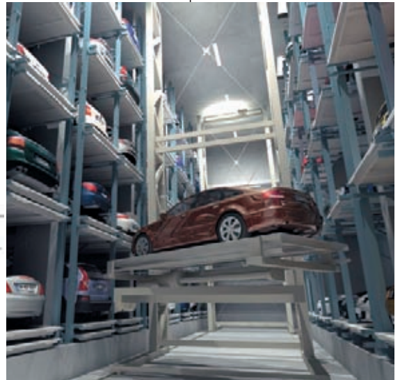
Figura 4. Sección, planta y vista de un sistema Multiparker con disposición transversal de los vehículos aparcados.
