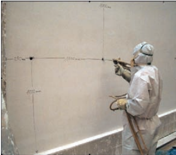
Figura 5. Fotografía de una rehabilitación de fachadas con aislamiento térmico por inyección en cámaras.
