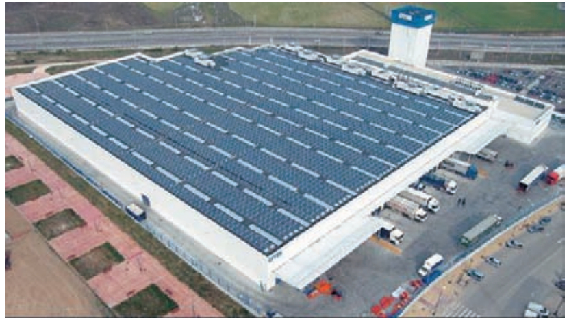
Figura 16. Ejemplo de fabricación eficiente. Nuevo Centro Industrial de Zardoya OTIS, S.A. en el Parque Tecnológico de Leganés.
