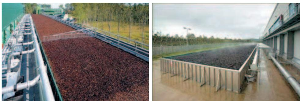
**Foto 2.4.** Biofiltros colocados en el techo de la planta y en el suelo.
