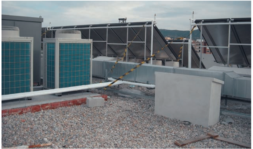
Foto 3.3. Apantallamiento de los equipos exteriores por captadores solares.
