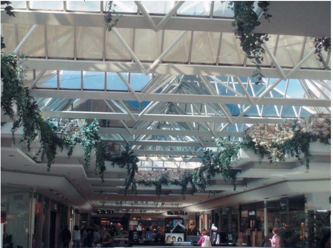
Foto A2.3. Lucernarios con filtros solares en el Centro Comercial La Vaguada.
