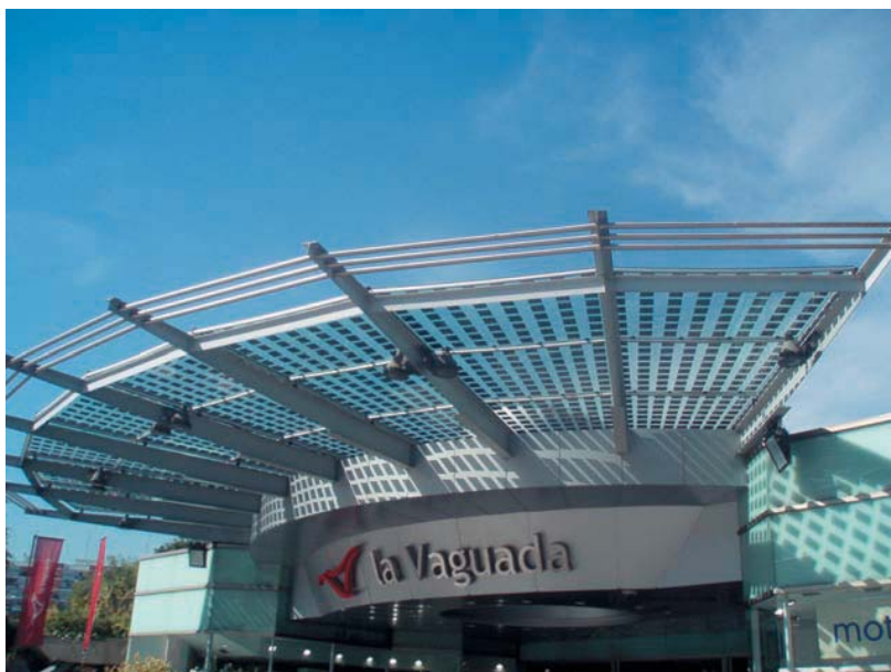
Foto 1.2. Acceso al Centro Comercial La Vaguada, con integración de producción de energía fotovoltaica en pérgola de acceso.
