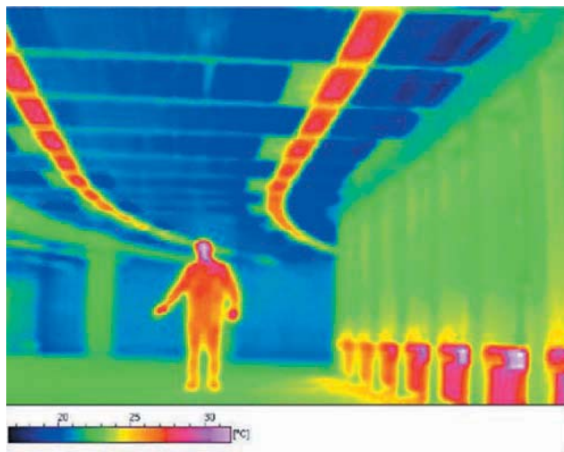
Figura A2.2. Termografía del efecto térmico de los elementos de climatización. (Fuente: Geoter).
