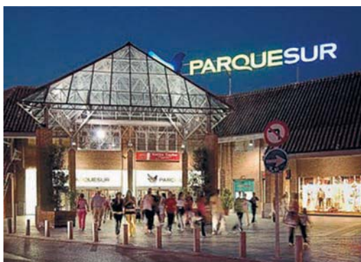
Foto A3.1. Vista general del Centro Comercial ParqueSur.
