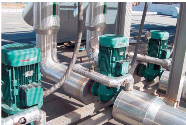
Foto A2.1. Detalle de generador térmico empleado en la climatización de Centros Comerciales.
