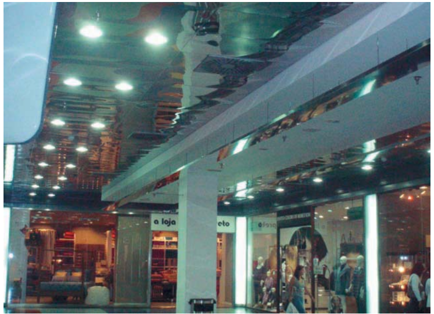
Foto A4.2. Iluminación general en el Centro Comercial Equinoccio mediante tecnología LED.
