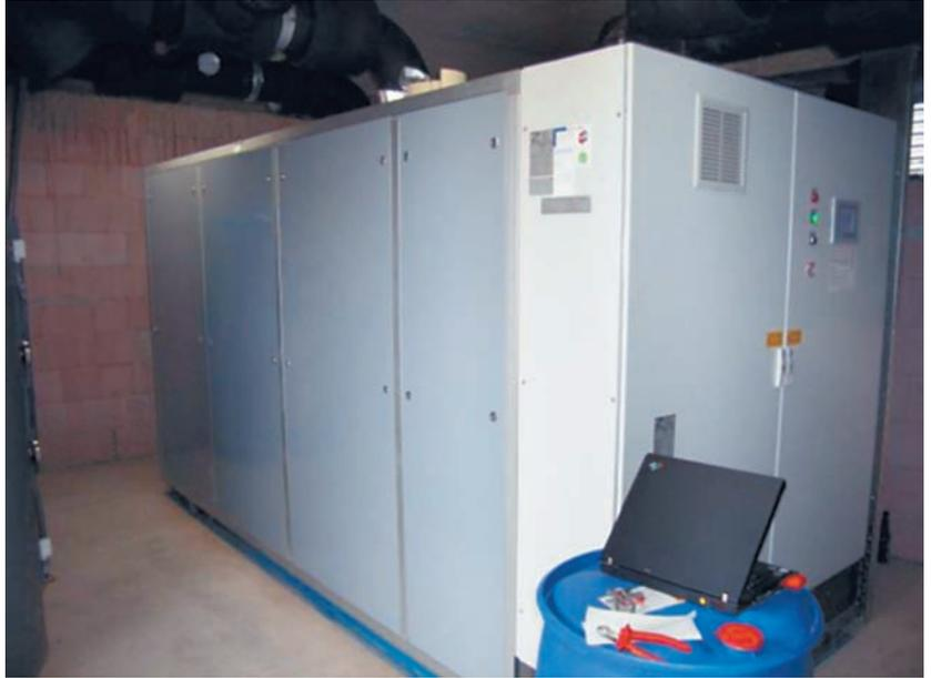
**Foto A1.4.** Bomba de calor geotérmica para altas potencias (unidad central de energía Geozent@ profi).
