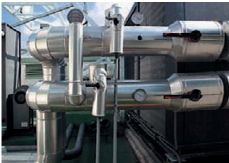
Foto 7. Instalación de climatización.
