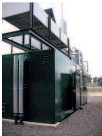
**Foto 2.** Contenedor amortiguador de ruido.
