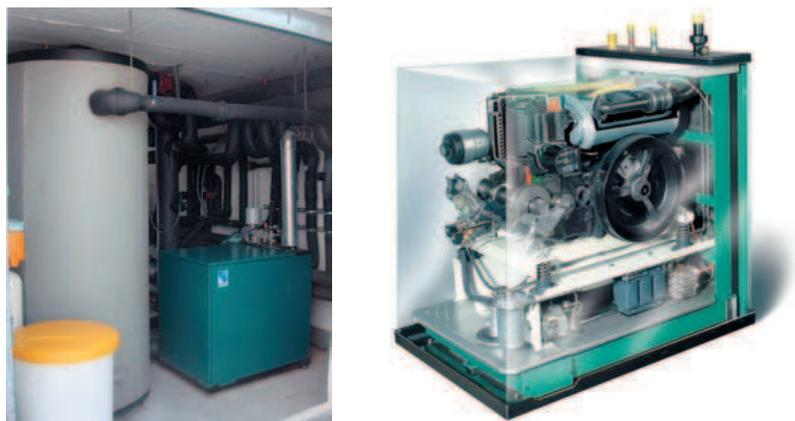
**Figura 1.** Izqda.: Vista del interior de la sala de calderas del edificio. Dcha.: Detalle del módulo de microcogeneración Senertec DACHS.
