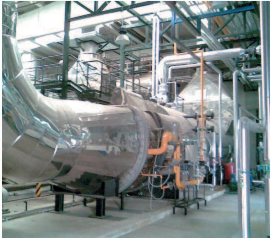
Foto 4. Detalle de la caldera de recuperación de calor.
