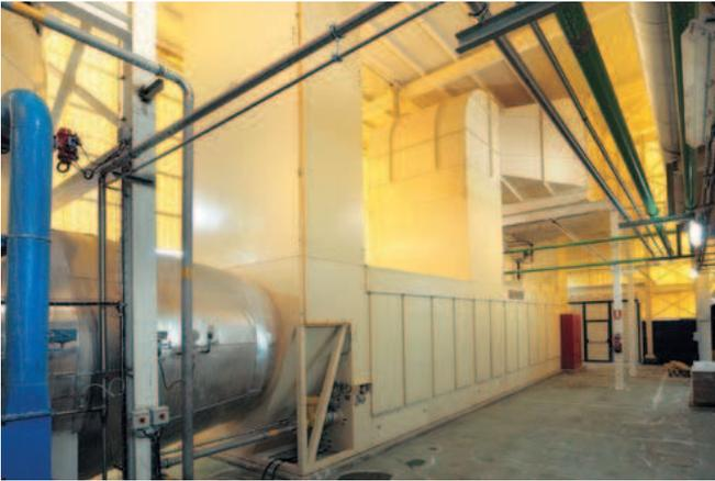
Foto 1. Turbogenerador a gas Titan 130 instalado en Enercrisa.
