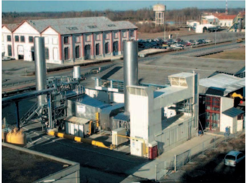
**Foto 1.** Planta de cogeneración a ciclo simple en empresa alimentaria.
