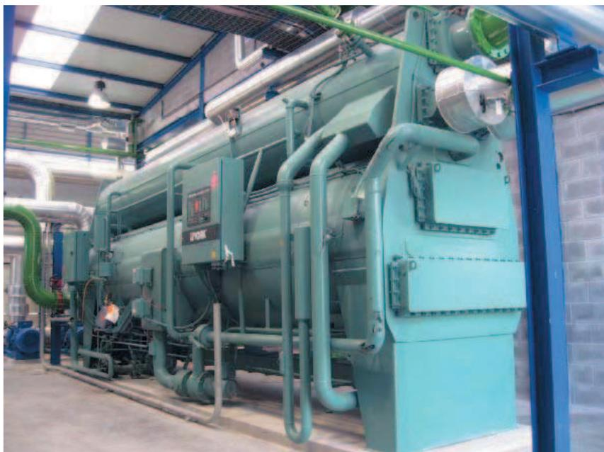
Foto 2. Máquina de absorción de bromuro de litio. Cortesía de York.
